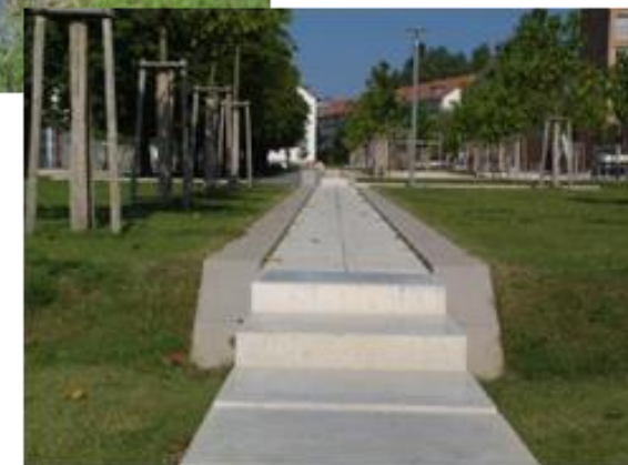
Fot. System zagłębień-niecek, rowów chłonnych i rynien służących retencji wód opadowych w Parku Scharnhauser w m. Ostfildern, rejon Stuttgartu (źr. http://www.seg-ostfildern.de/infos/team/index.html )
