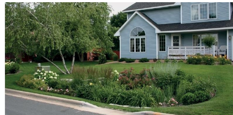
Niecka retencyjna przy domu jednorodzinnym (fot. EPA, United States Environmental Protection Agency.
