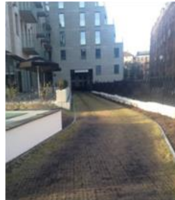
Nawierzchnia przepuszczalna z betonowej kostki ażurowej przy budynku mieszkalno-usługowym, Kraków ul. Dietla – fot. R. Bogdańska-Warmuz
