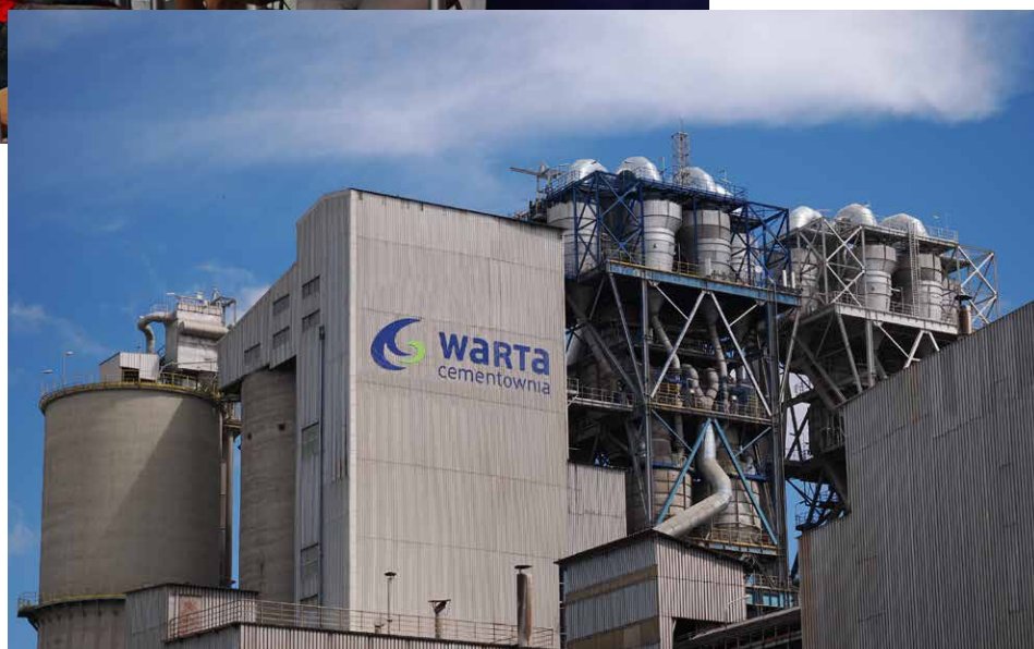
Fot. Błażej Boryń, Czterostopniowe cyklonowe wymienniki ciepła.
