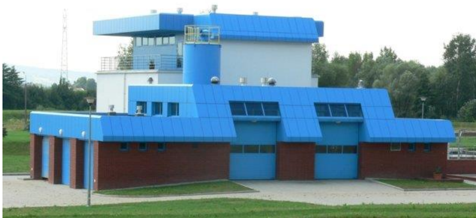
Fot. Stacja Uzdatniania wody MPWiK Rzeszów-Zwięczyca – budynek pras i odstojników.
