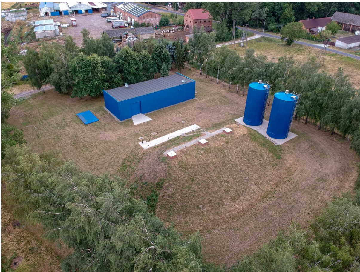
Zdjęcie 2. Stacja Uzdatniania Wody Wziąchów.
