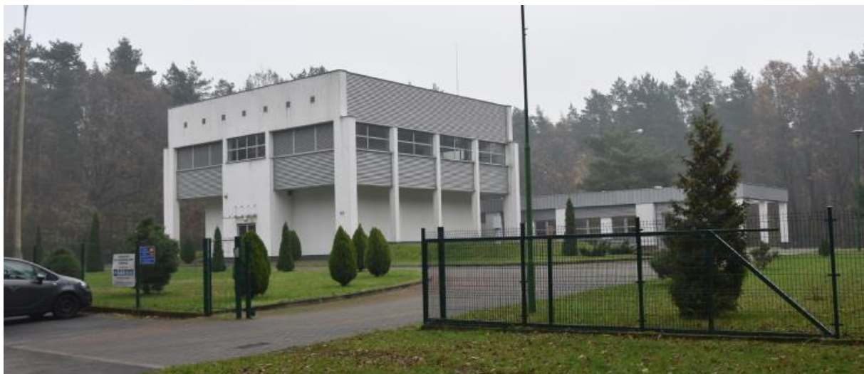
Zdjęcie 3. Stacja Uzdatniania Wody Gostyń.
