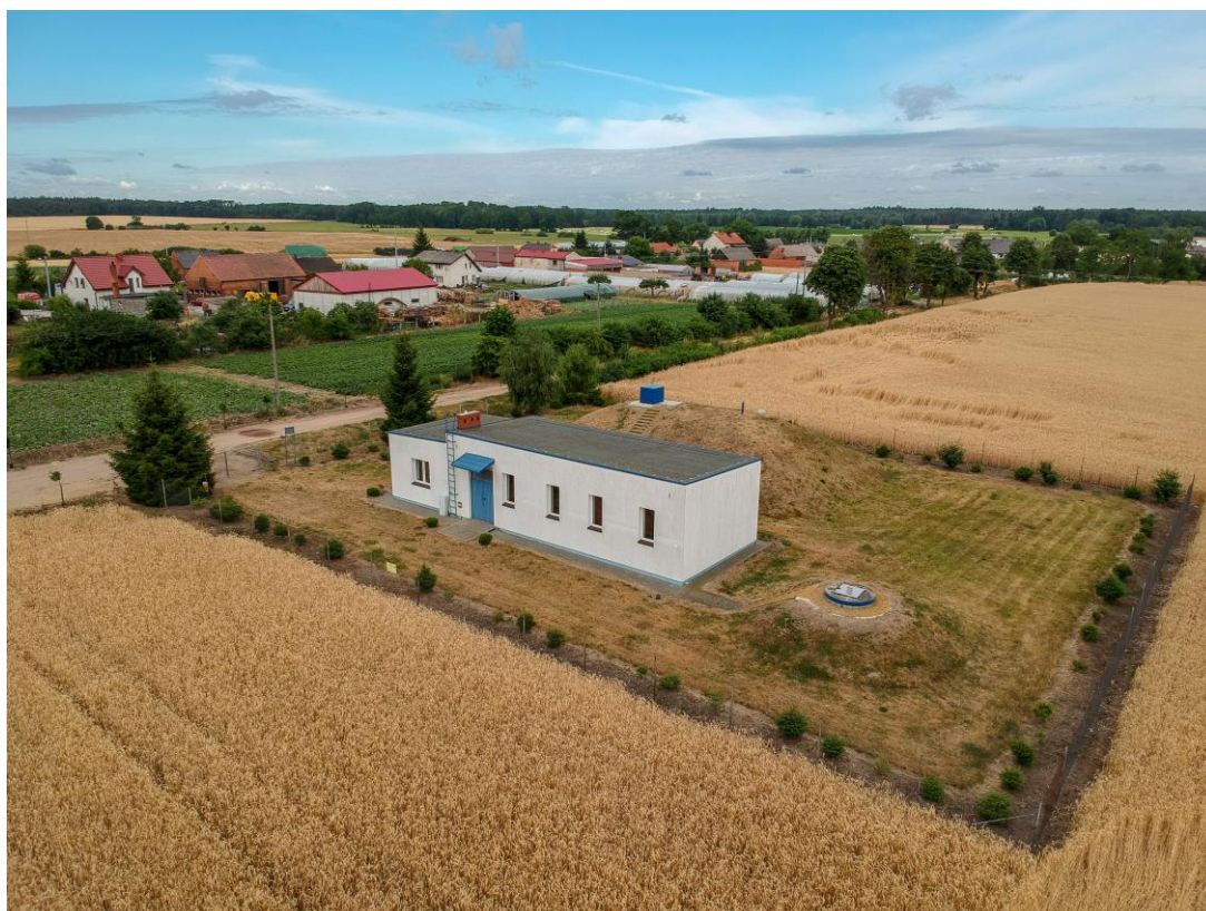
Zdjęcie 1. Stacja Uzdatniania Wody Karzec.
