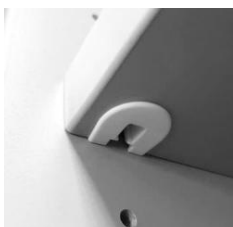
rys. 4 – podpórka półki płytowej typu secura
