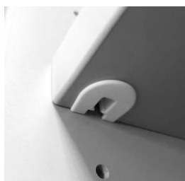
rys. 1 – podpórka półki płytowej typu secura
