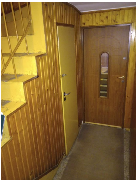
Fot. 1 Budynek mieszkalny – klatka schodowa
