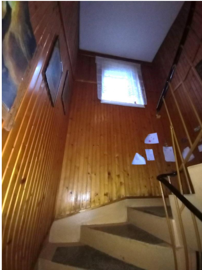
Fot. 5 Budynek mieszkalny – klatka schodowa
