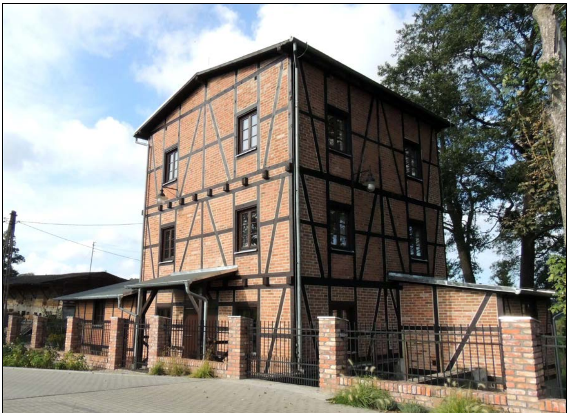
Fot. 77 Zespół Robakowskiego Młyna w Świecinie – obiekt wpisany do rejestru zabytków Pomorskiego Wojewódzkiego Konserwatora Zabytków pod numerem 1804
