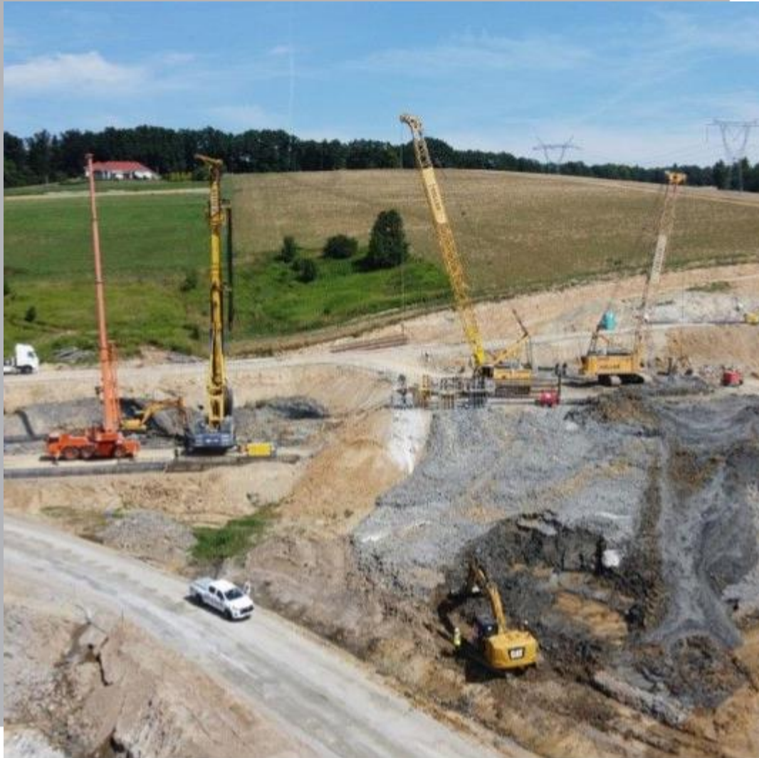
Widok na portal południowy tunelu
