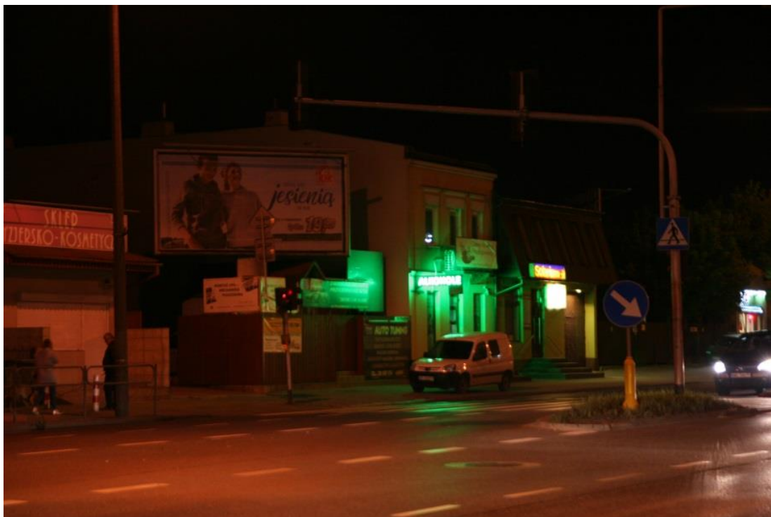
Rys. 10.48 Problem oślnienia w otoczeniu przejścia dla pieszych – przykład 3
