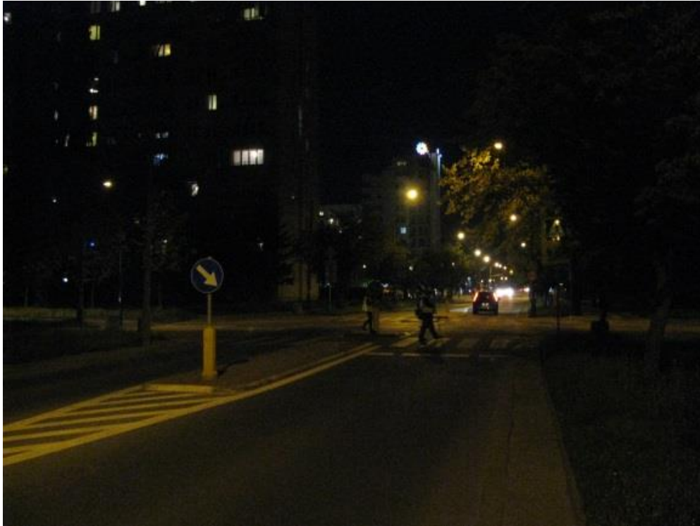
Rys. 10.67 Uszkodzone źródła światła w oprawach oświetleniowych – przykład 1
