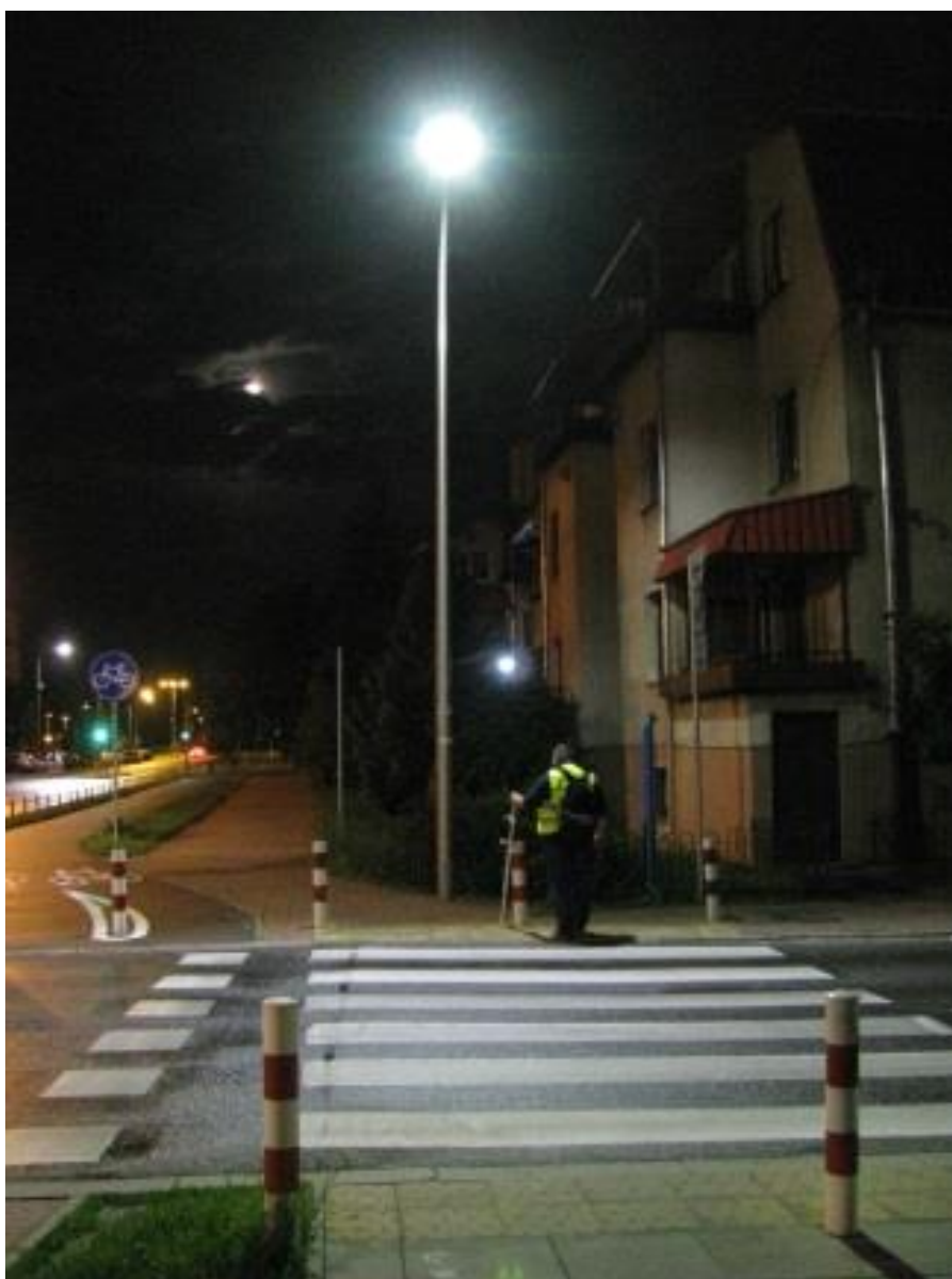
Rys. 10.1 Montaż słupa poza chodnikiem
