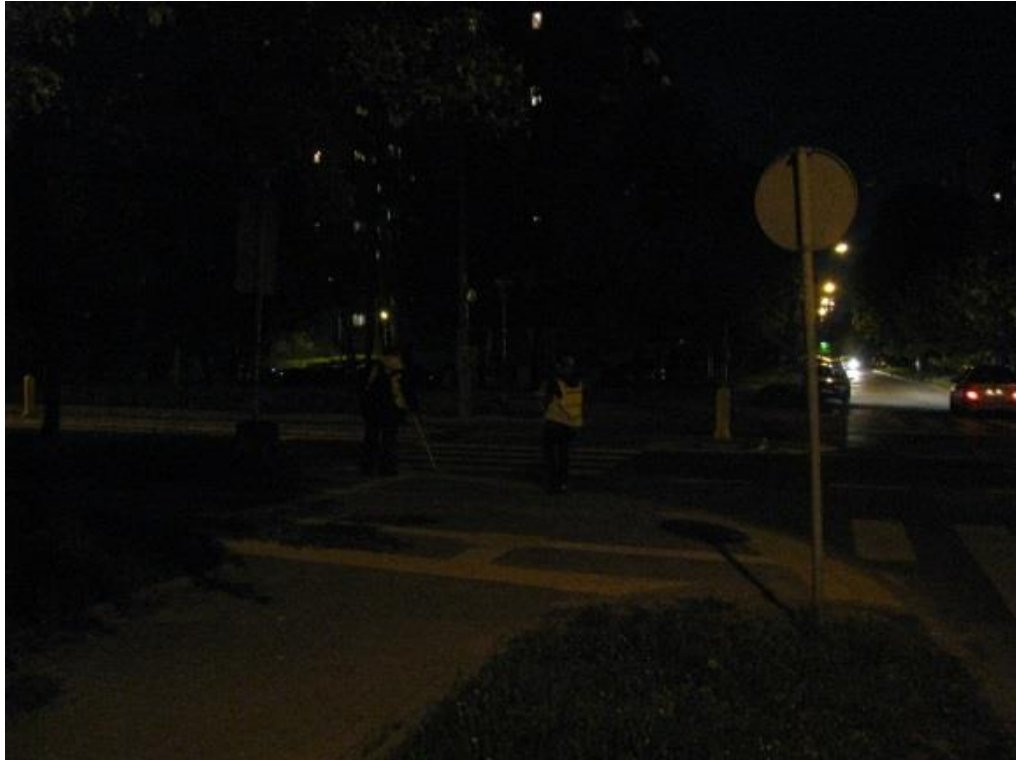
Rys. 10.57 Brak oprav oświetleniowych w bezpośrednim otoczeniu przejścia dla pieszych - 3
