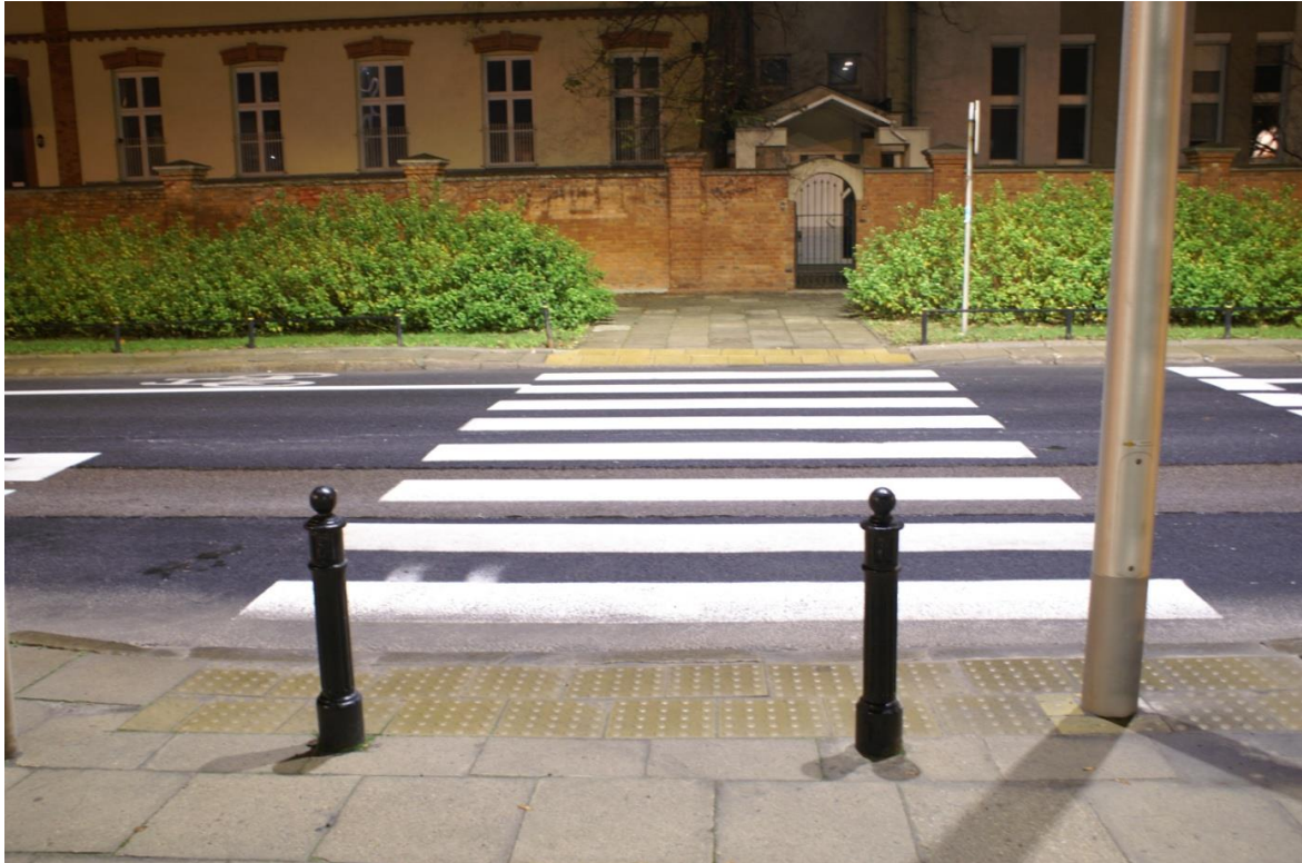
Rys. 9.2 Widok przejścia dla pieszych w kierunku północnym
