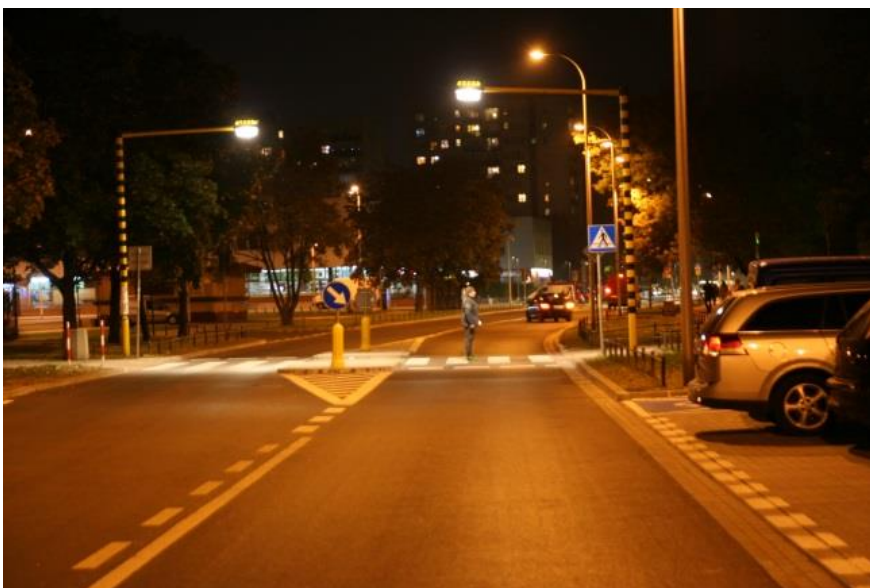
Rys. 10.6 Zastosowanie charakterystycznej konstrukcji słupa i jego malowania – przykład 1b
