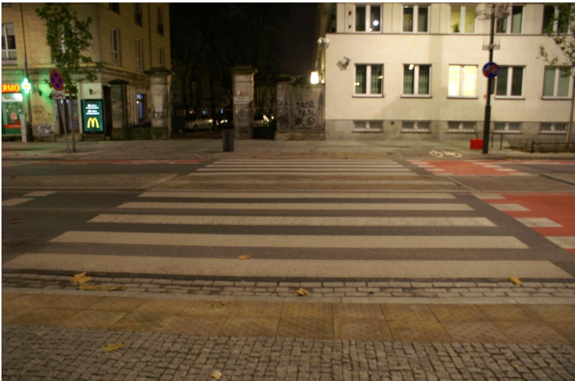
Rys. 9.75 Widok przejścia przez jezdnię ul. Świętokrzyskiej w kierunku S
