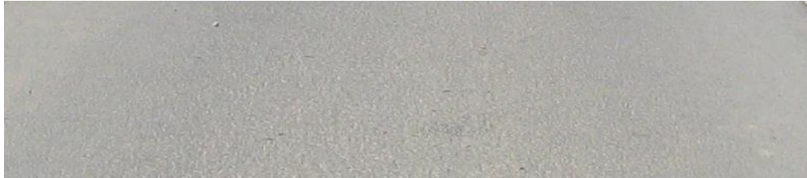
Rys. 3.2 Nawierzchnia drogi w klasie R1
