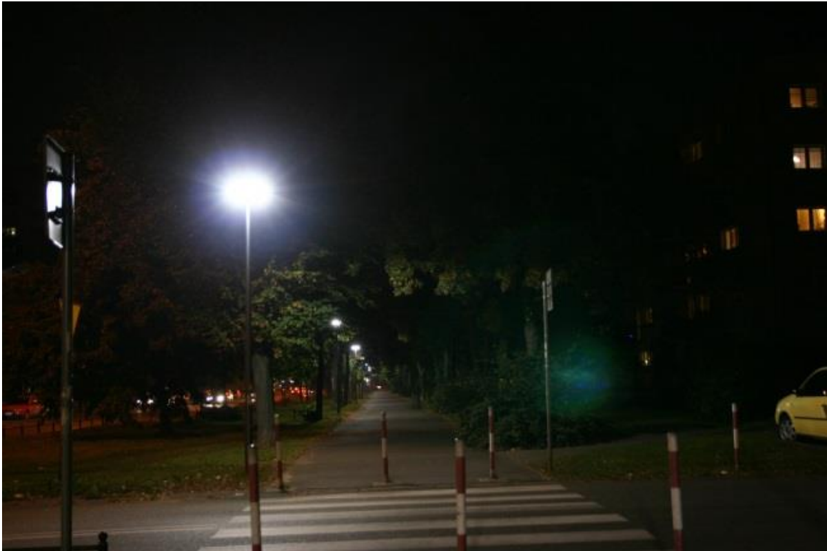
Rys. 10.46 Problem oślnienia w otoczeniu przejścia dla pieszych – przykład 1
