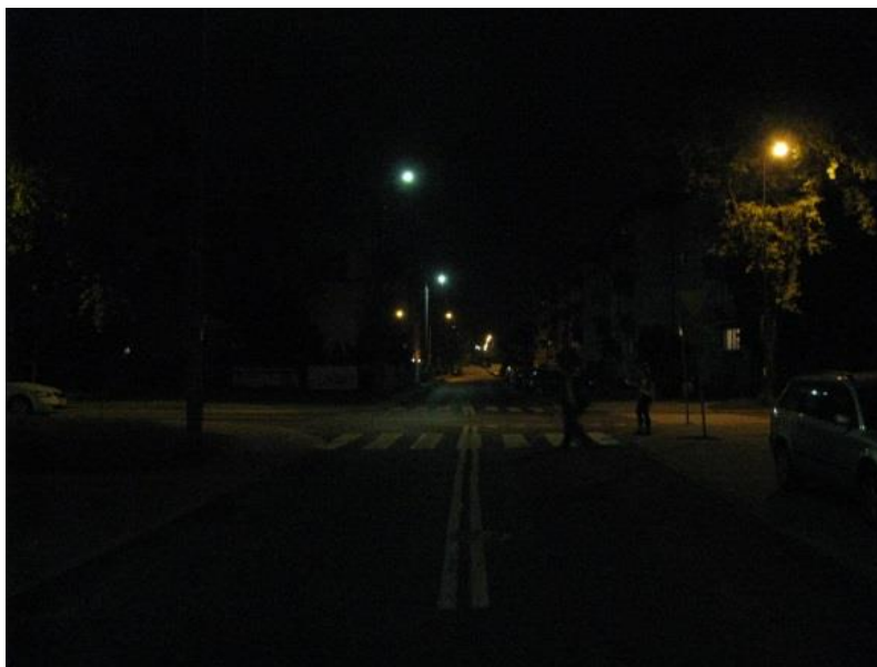
Rys. 10.55 Brak oprav oświetleniowych w bezpośrednim otoczeniu przejścia dla pieszych –1
