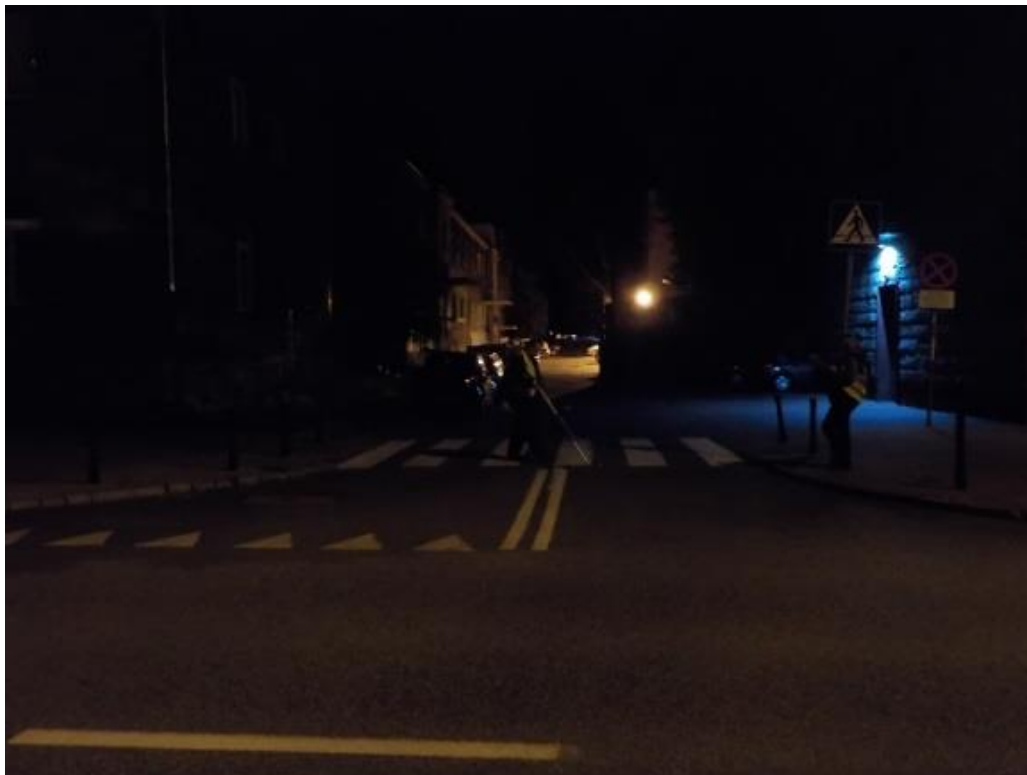
Rys. 10.59 Brak oprav oświetleniowych w bezpośrednim otoczeniu przejścia dla pieszych -5
