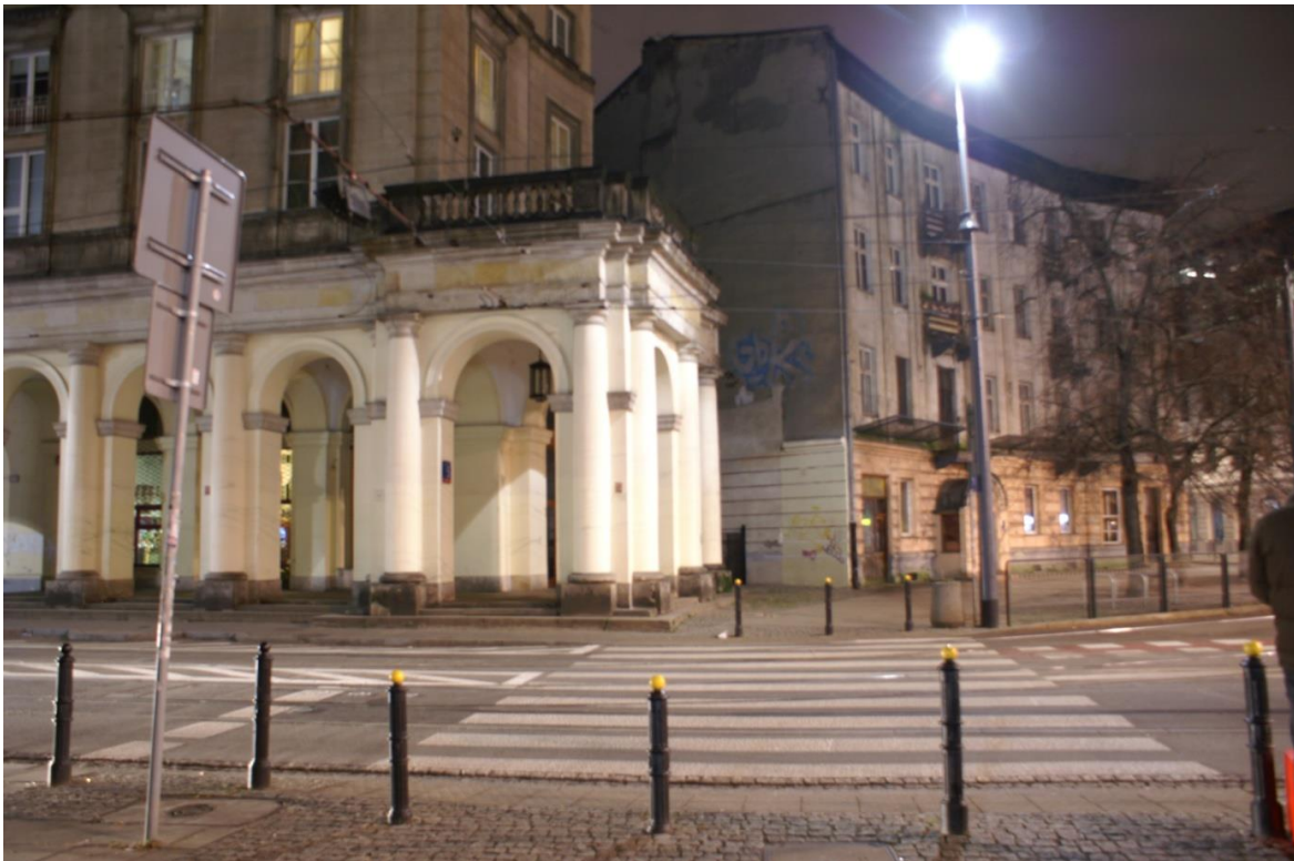
Rys. 9.26 Widok przejścia w kierunku W. Latarnia zlokalizowana 0,5 m od przejścia
