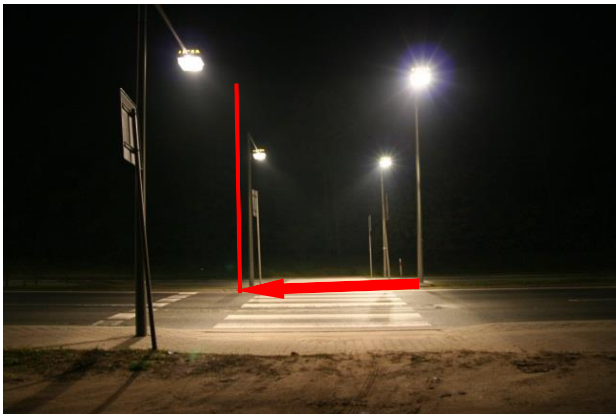
Rys. 10.43 Błędny dobór rozsyłów opraw oświetleniowych do kierunków ruchu
