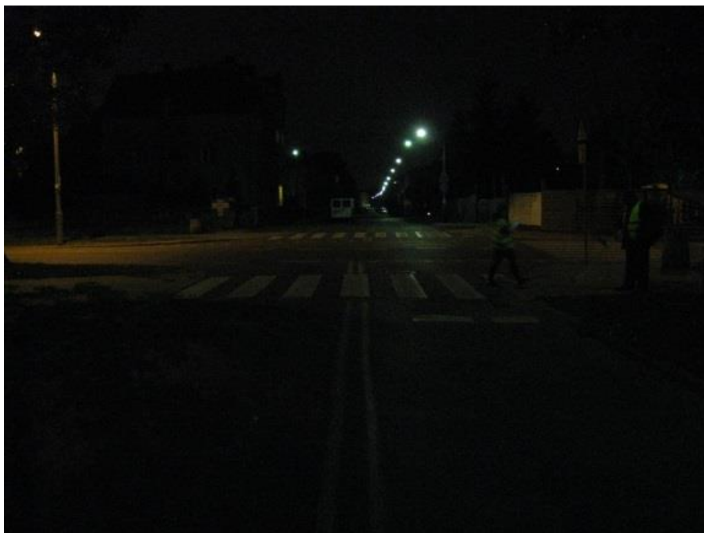
Rys. 10.60 Brak oprav oświetleniowych w bezpośrednim otoczeniu przejścia dla pieszych - 6
