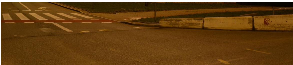
Rys. 3.4 Nawierzchnia drogi w klasie R3
