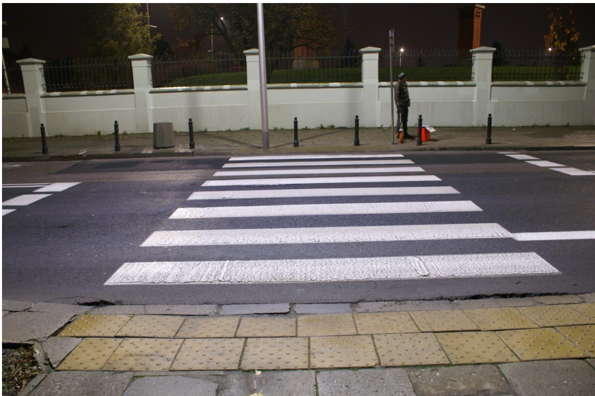
Rys. 9.3 Widok przejścia dla pieszych w kierunku południowym.
