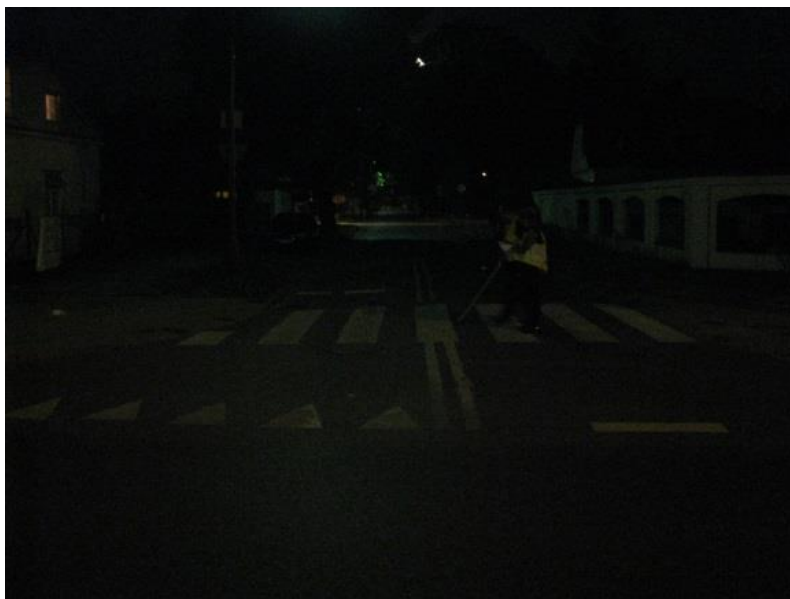
Rys. 10.56 Brak oprav oświetleniowych w bezpośrednim otoczeniu przejścia dla pieszych – 2
