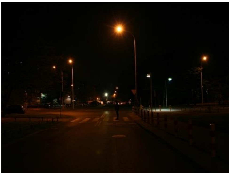
Rys. 10.52 Nieefektywne instalacje oświetlenia ulicznego – przykład 4
