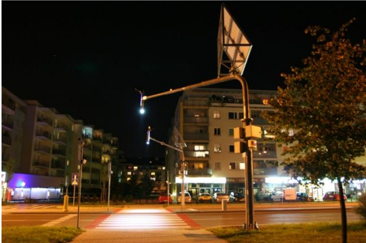
Rys. 10.37 Instalacja fotowoltaiczna w oświetlonym terenie zabudowanym
