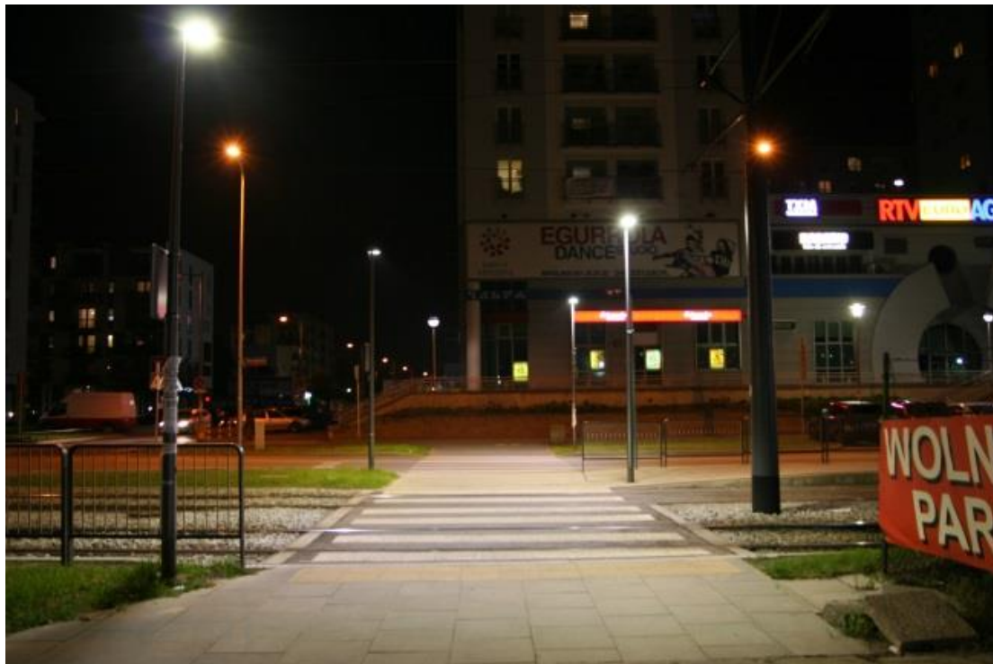
Rys. 10.29 Oświetlenie przejścia dla pieszych na torowisku tramwajowym – przykład 1b
