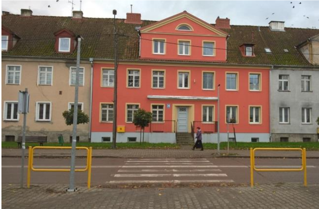
Rys. 10.3 Właściwy montaż i symetryczne rozmieszczenie słupów i opraw oświetleniowych względem osi przejścia dla pieszych - przykład 1
