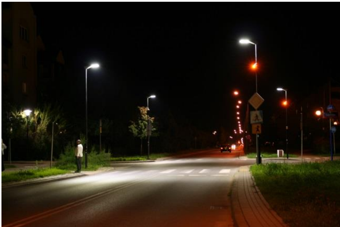
Rys. 10.39 Przykład dobry: Symetria usytuowania słupa
