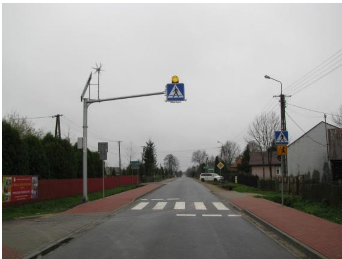
Rys. 10.36 Instalacja fotowoltaiczna w oświetlonym terenie zabudowanym
