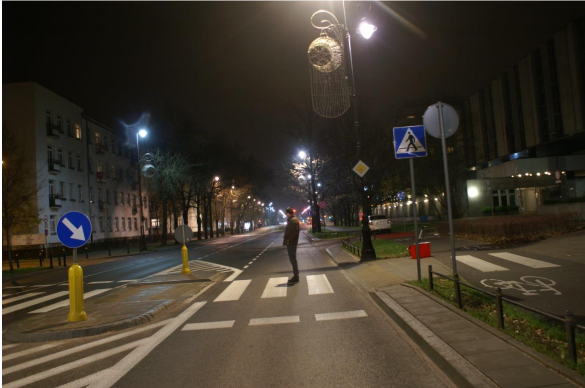
Rys. 9.52 Widok przejścia dla pieszych i pieszego w kierunku ul. Łądowej
