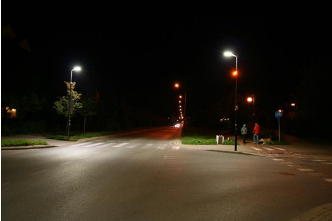
Rys. 10.38 Przykład zły: Brak symetrii usytuowania słupa
