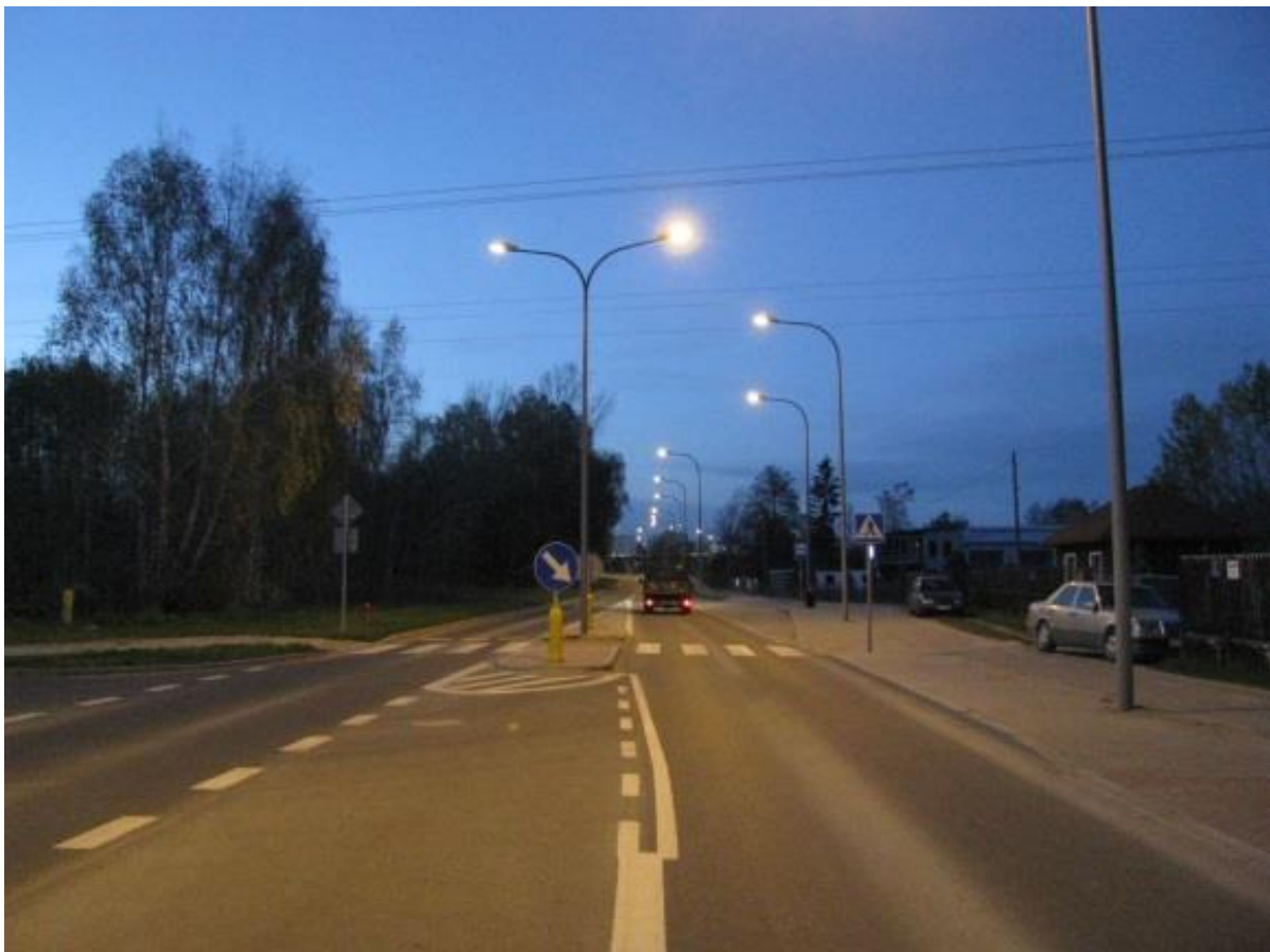
Rys. 10.18 Stosowanie wysięgników – przykład 1
