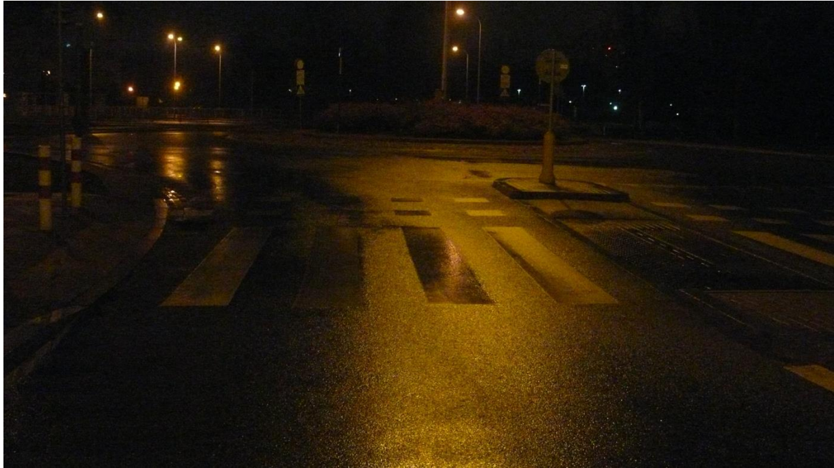
Rys. 9.41 Widok przejścia dla pieszych w kierunku ronda
