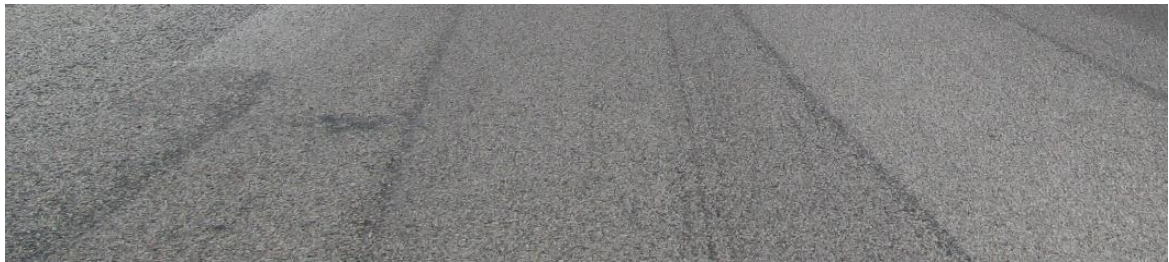
Rys. 3.3 Nawierzchnia drogi w klasie R2
