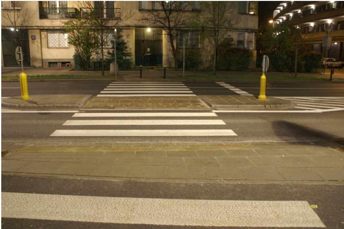
Rys. 9.50 Widok przejścia dla pieszych przez ul. Belwederską w kierunku wschodnim (E)
