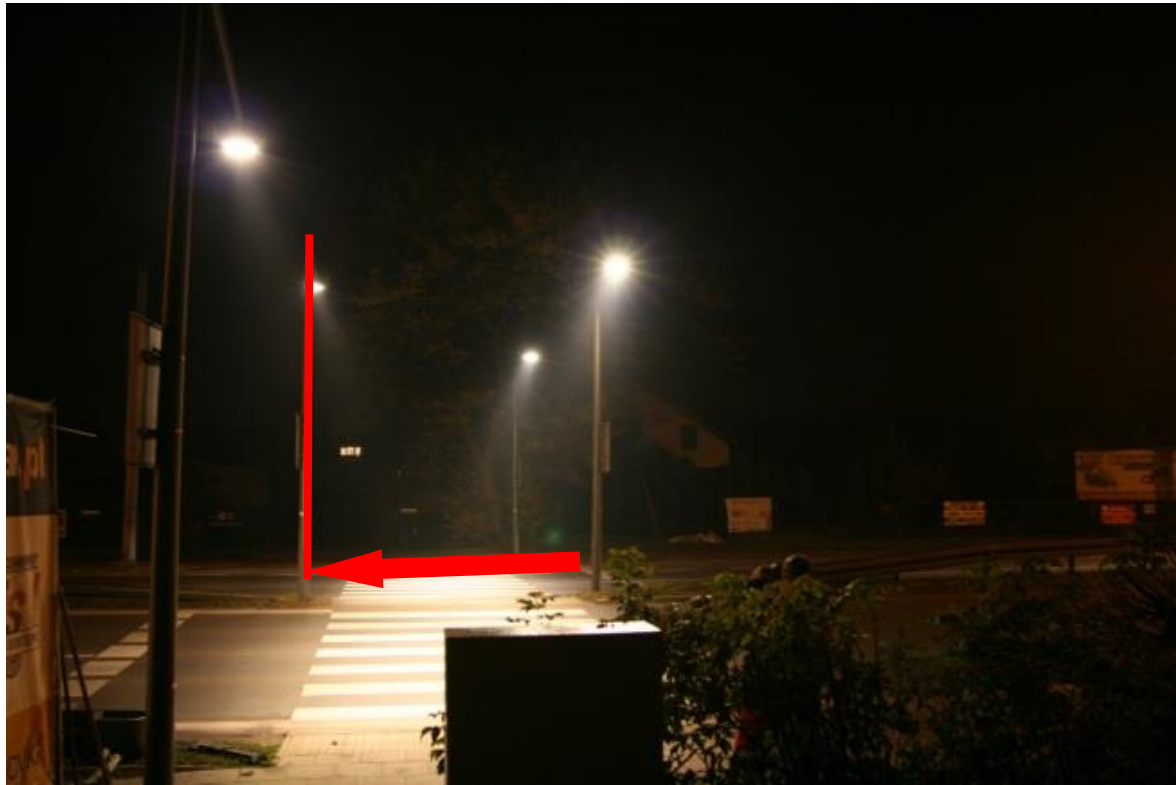
Rys. 10.41 Błędny dobór rozsyłów opraw oświetleniowych do kierunków ruchu
