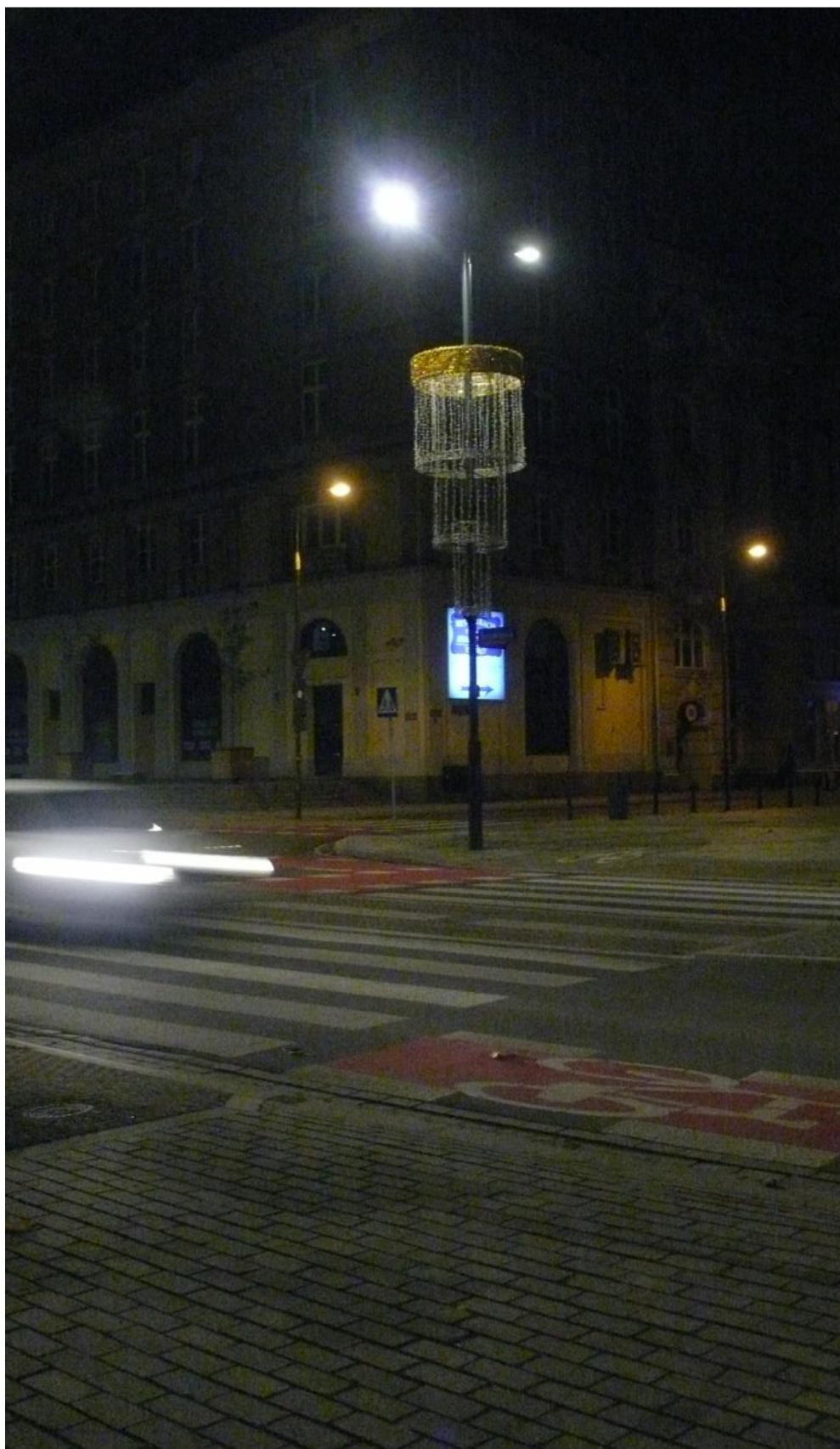
Rys. 9.79 Widok przejścia i najbliższej latarni – kierunek N
