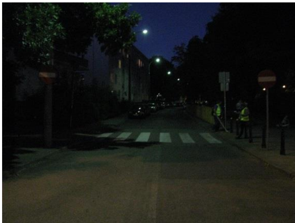
Rys. 10.49 Nieefektywne instalacje oświetlenia ulicznego – przykład 1
