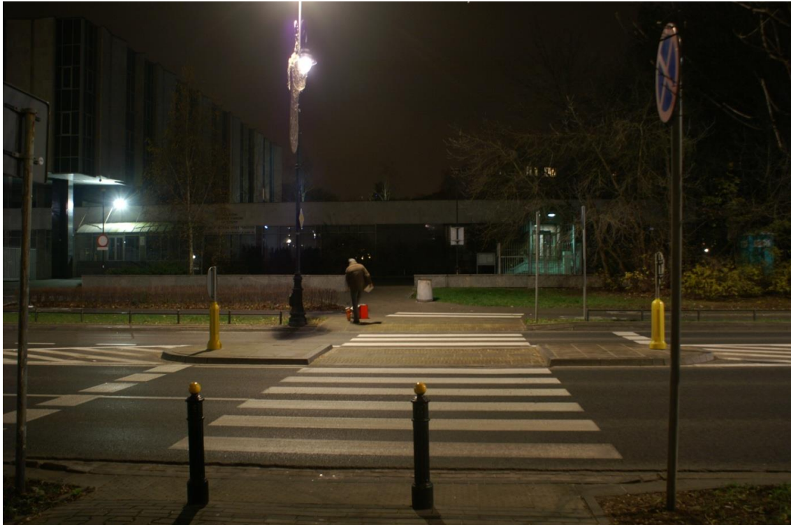
Rys. 9.51 Widok przejścia dla pieszych przez ul. Belwederską w kierunku zachodnim (W). Widoczna oprawa metalohalogenkowa oświetlenia ulicznego.
