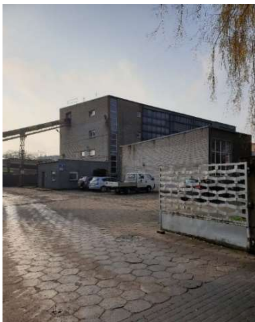
Rys. 4: Istniejąca ciepłownia w Choszcznie.
