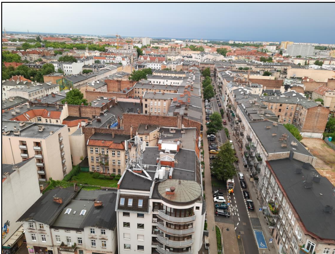
Widok z siedziby RDOŚ w Poznaniu od strony zachodniej, fot. ASB
