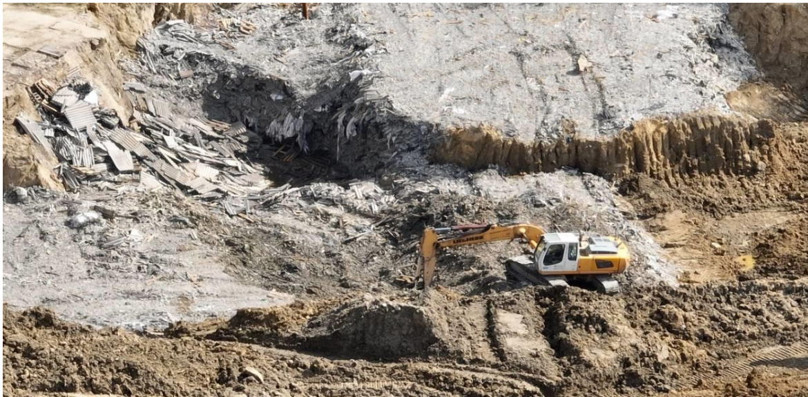
Zdjęcie 20. Zakopywanie i zagęszczanie płyt azbestowo-cementowych na składowisku odpadów niebezpiecznych.
