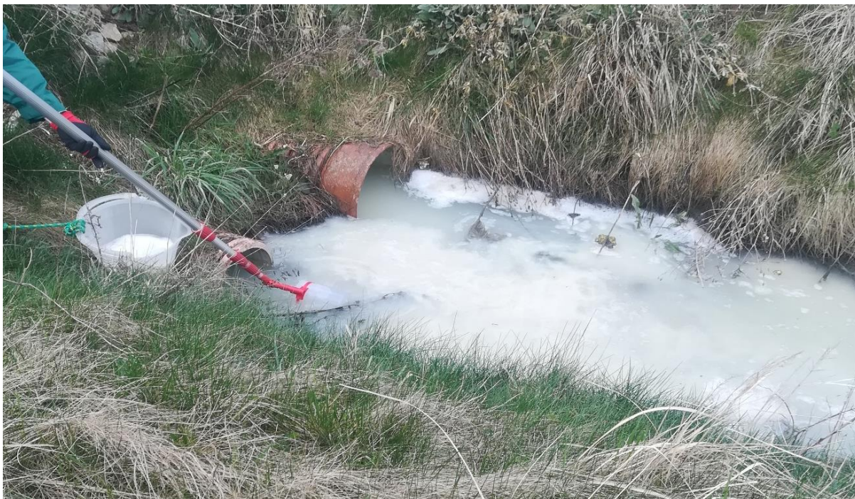
Zdjęcie 27. Wylot kanalizacji.
