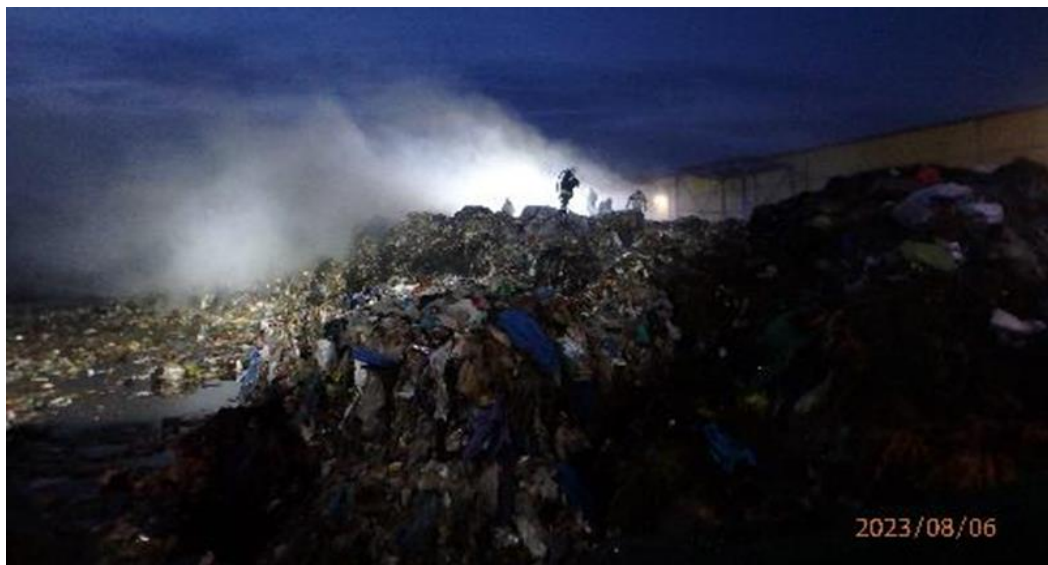
Zdjęcie 32. Pożar składowanych odpadów.
