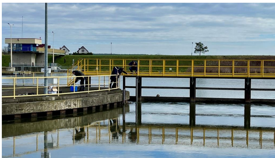
Zdjęcie 39. Montaż sondy automatycznej w Krapkowicach
