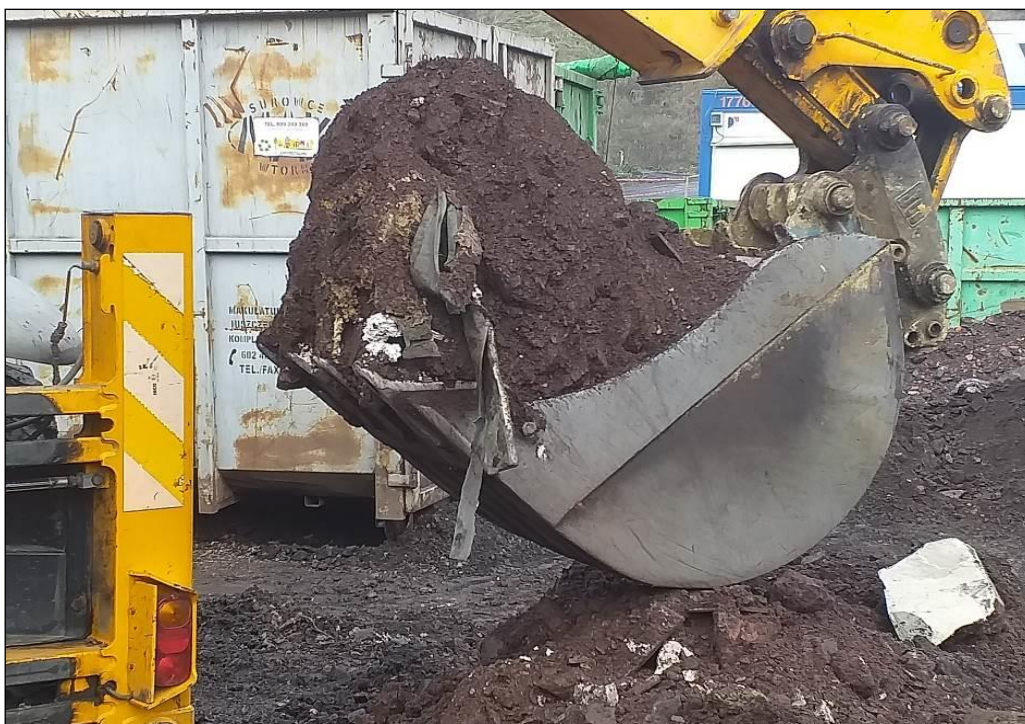
Zdjęcie 30. Ujawnienie faktu zakopywania odpadów.
