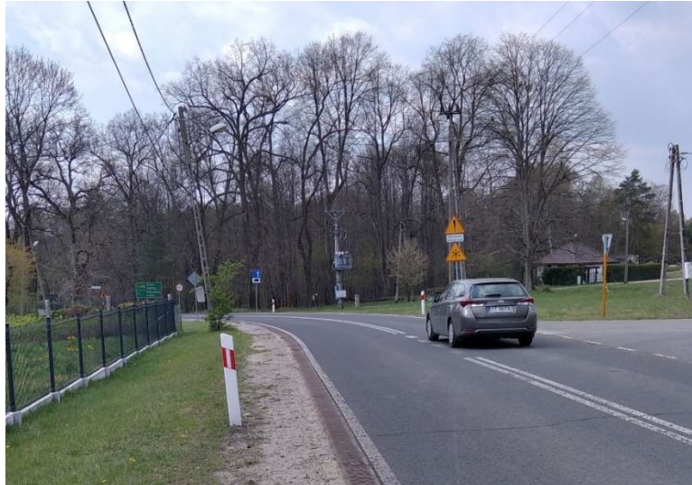
Fot. 5. Brusiek, RB2. Badany odcinek ul. Koszęcińskiej w kierunku Tworogu.
