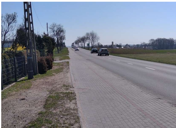
Fot. 15. Sadów, RB5. Badany odcinek ul. Powstańców Śląskich w kierunku Koszęcina.
