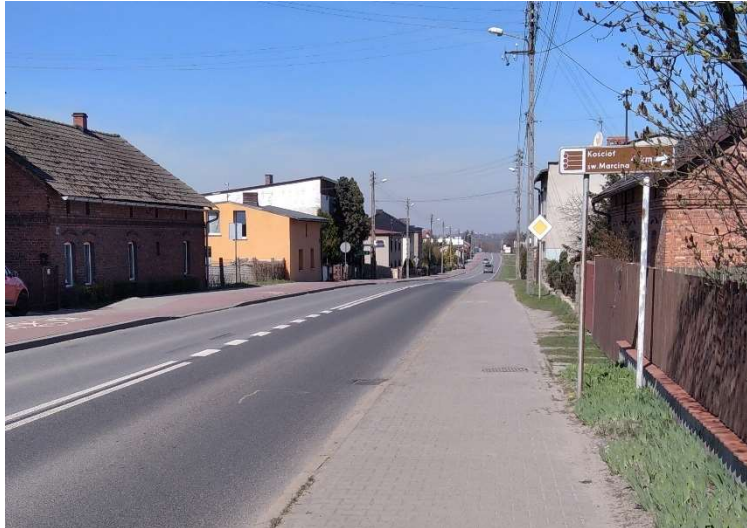
Fot. 11. Koszęcin, RB4. Badany odcinek ul. Lublinieckiej w kierunku Wierzbia.
