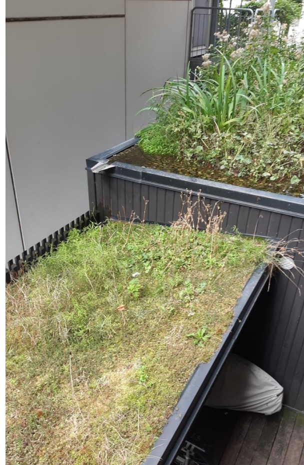
Zielone dachy na wiacie i pomieszczeniu gospodarczym (pierwszy z roślinami do stanowiska suchego drugi wilgotnego)
