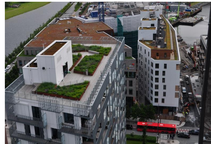
fot. M. Weber-Siwirska
