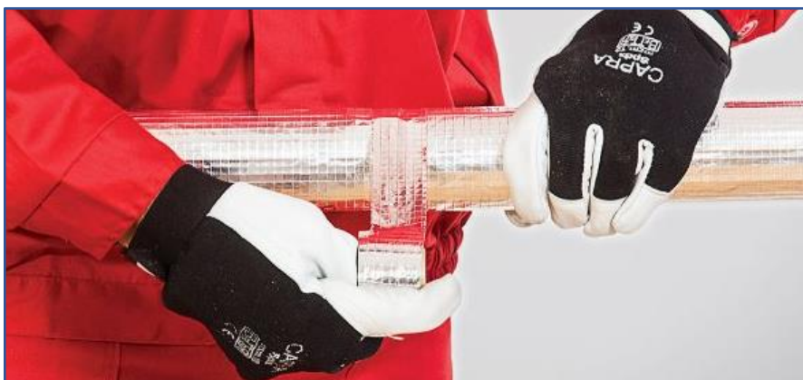
fot. 3 centrum izolacji: zabezpieczenie połączenia otulin
