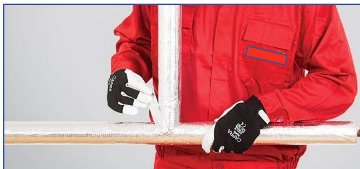
fot. 6 centrum izolacji: izolacja trójnika
