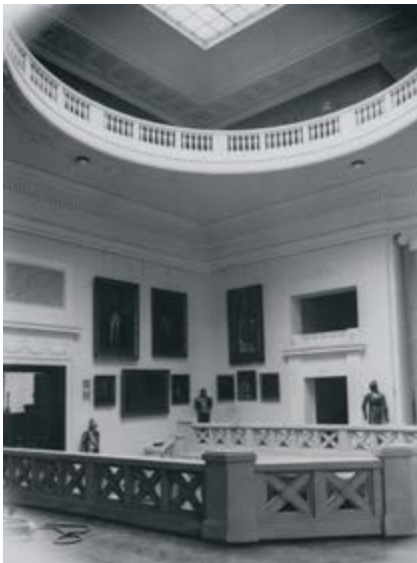
Hall pierwszego piętra Biblioteki Ordynacji Krasieńskich przy ul. Okólnik 9, 1930, fot. NAC
