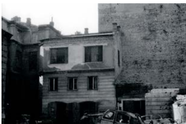
Ruiny pałacyku Tyszkiewiczów przy ul. Matejki 5, 1948, fot. K. Pęcherski, MPW
