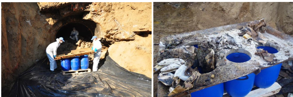
Fot. 11, 12. Wydobywanie odpadów p.ś.o.r. i bezpieczne opakowania odpadów w postaci atestowanych beczek
