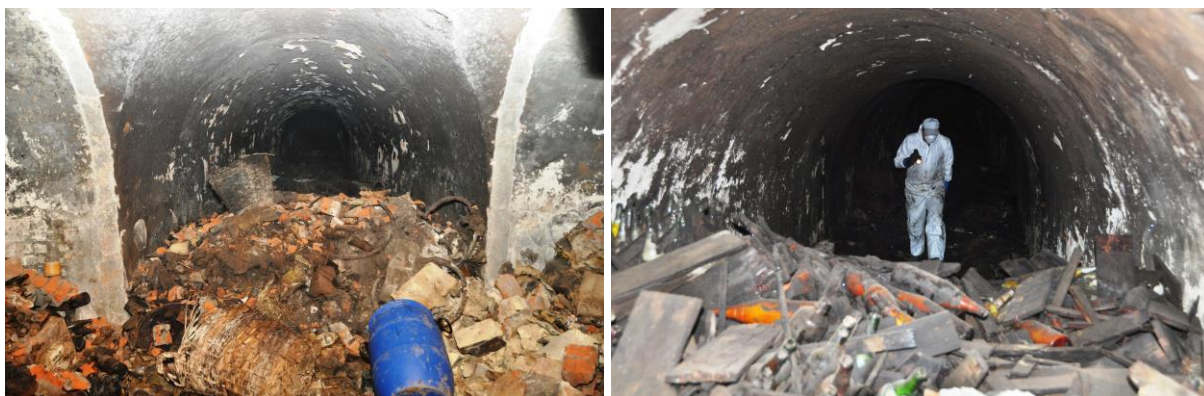
Fot. 9, 10. Widok na wnętrze mogilnika przed przystąpieniem do wydobywania odpadów p.ś.o.r.
