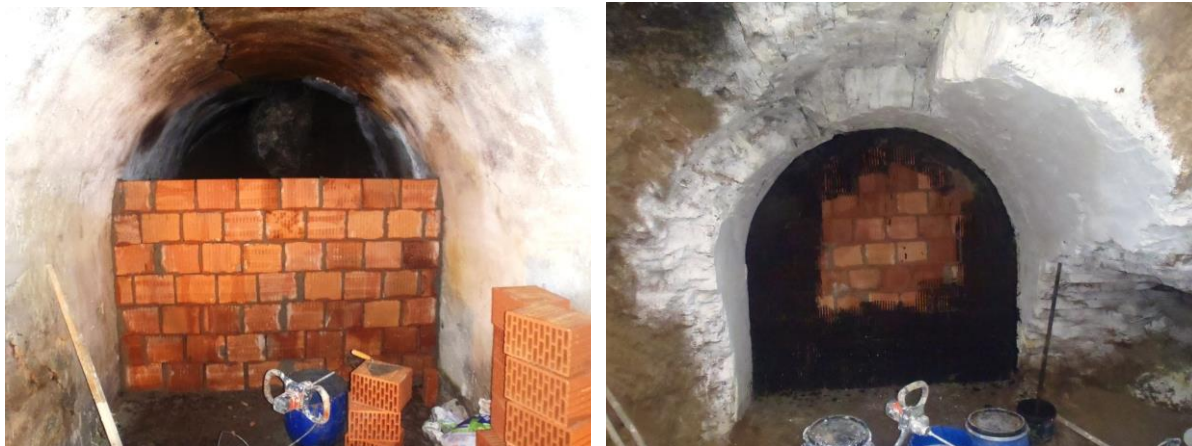
Fot. 19, 20. Wewnętrzna ścianka działowa oraz zamurowane wejście do bunkra
