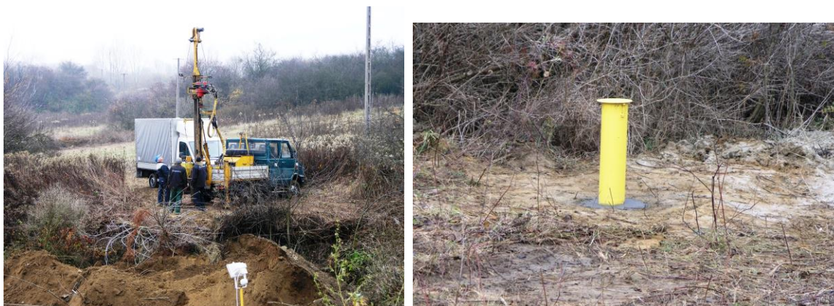
Fot. 21, 22. Wiertnica otworów badawczych i jeden z trzech wykonanych piezometrów
