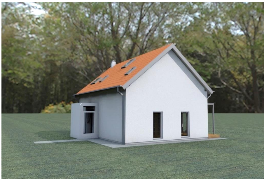
Rysunek 3.2. Widok budynku murowanego od strony wejścia
