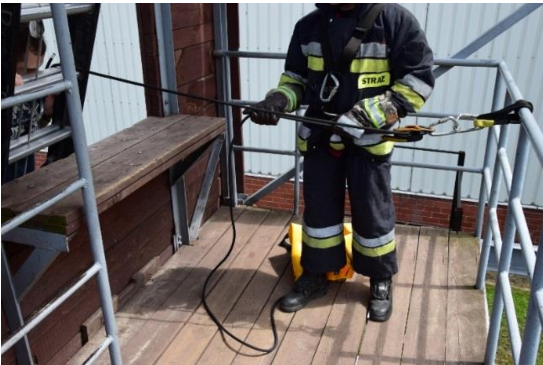
Rys. 45). Górna asekuracja na drabinie
