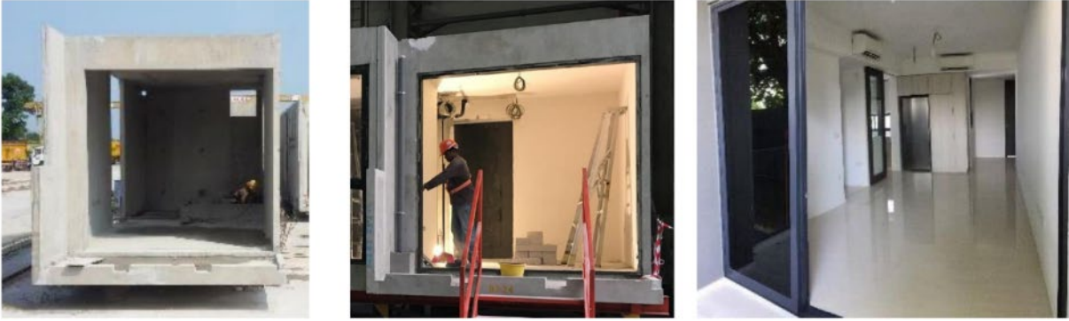
Rysunek 25: Trzy etapy prefabrykacji elementu wielkoprzestrzennego PPVC (HongKong). [34]
