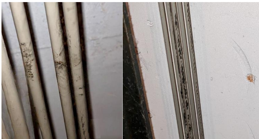
Rysunek 11 . Zanieczyszczenie liny wykryte podczas kontroli czystości
