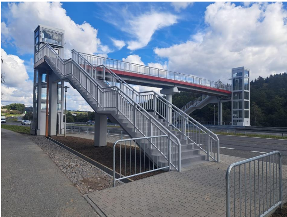
Widok kładki dla pieszych na kierunku do Krakowa wraz z zainstalowanymi szybami windowymi.
