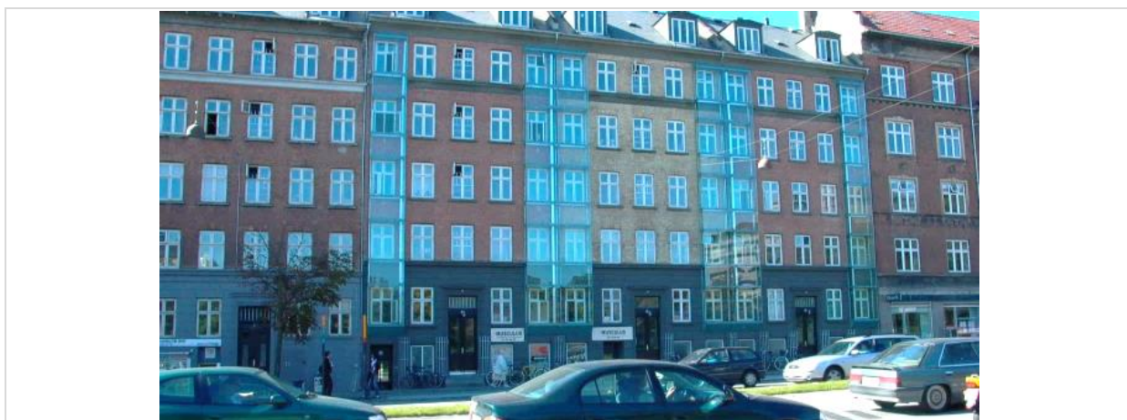
Rysunek 48 Elewacje szklane przy fasadach pomieszczeń sypialnianych budynku ulokowanego tuż przy drodze głównej; brak miejsca na budowę ekranu akustycznego
