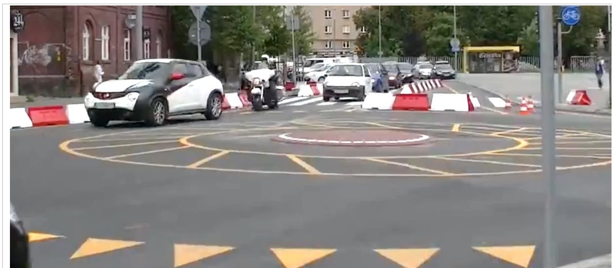
Rysunek 15 Rondo zastępujące skrzyżowanie z sygnalizacją świetlną (materiały własne)
