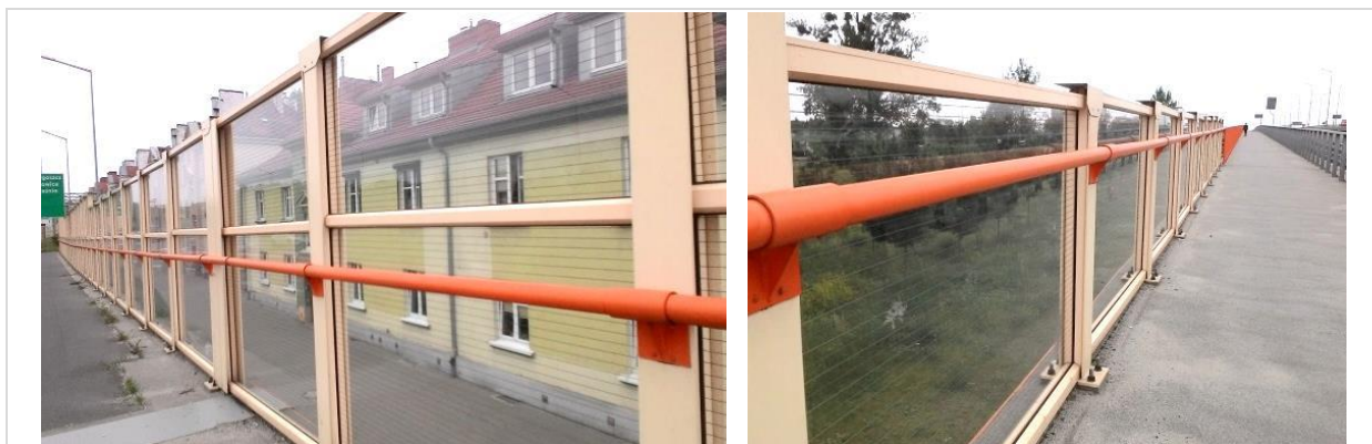
Rysunek 36 Przezierny ekran przeciwhałasowy odbijający o lekkiej konstrukcji na wiadukcie (materiały własne)
