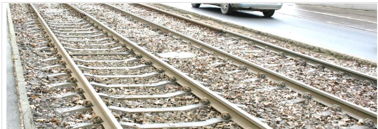
Rysunek 17 Przykład wydzielonego torowiska o podkładach strunobetonowych, mocowaniu sprężystym i szynach bezстыkowych na podsypce (materiały własne)
