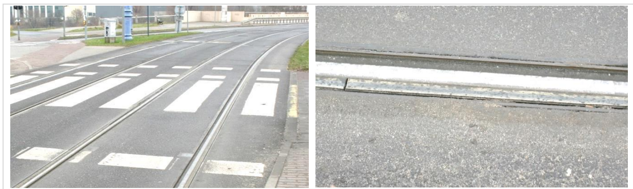
Rysunek 20 Torowisko w jezdni z systemem tłumiącym ORTEC (materiały własne)
