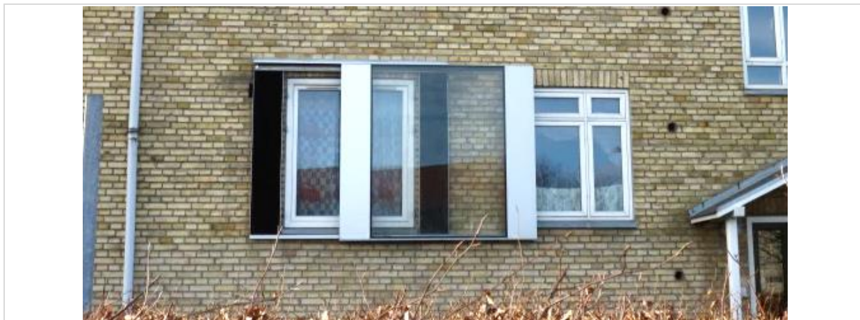
Rysunek 47 Dodatkowa, ruchoma elewacja szklana zamontowana przed oknem pomieszczenia mieszkalnego, pozostawiając możliwość otwarcia okna
