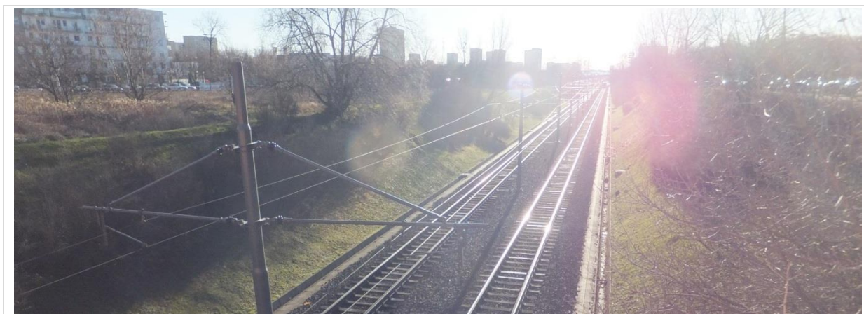
Rysunek 42 Wały ziemne wzdłuż linii tramwajowej; torowisko zlokalizowane jest poniżej poziomu terenu na którym znajduje się zabudowa mieszkaniowa (materiały własne)
