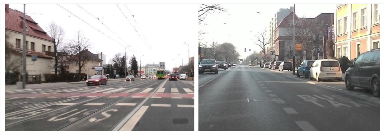
Rysunek 5 Drogi rowerowe, buspasy, wydzielone torowisko w jezdni, redukcja pasów ruchu dla pojazdów osobowych (materiały własne)
