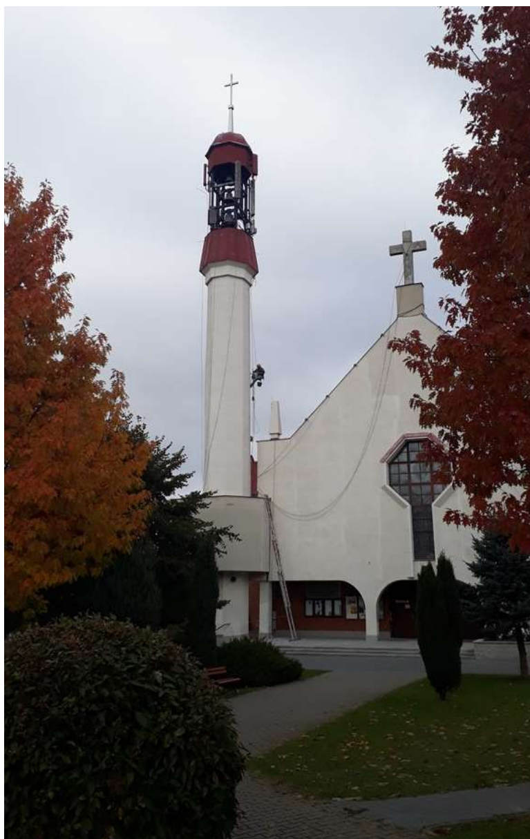
Fot. 1: Widoki anten stacji bazowych ID: LUB1048 oraz ID: BT12017, zlokalizowanych: ul. Kasztanowa 1, 20-138 Lublin
