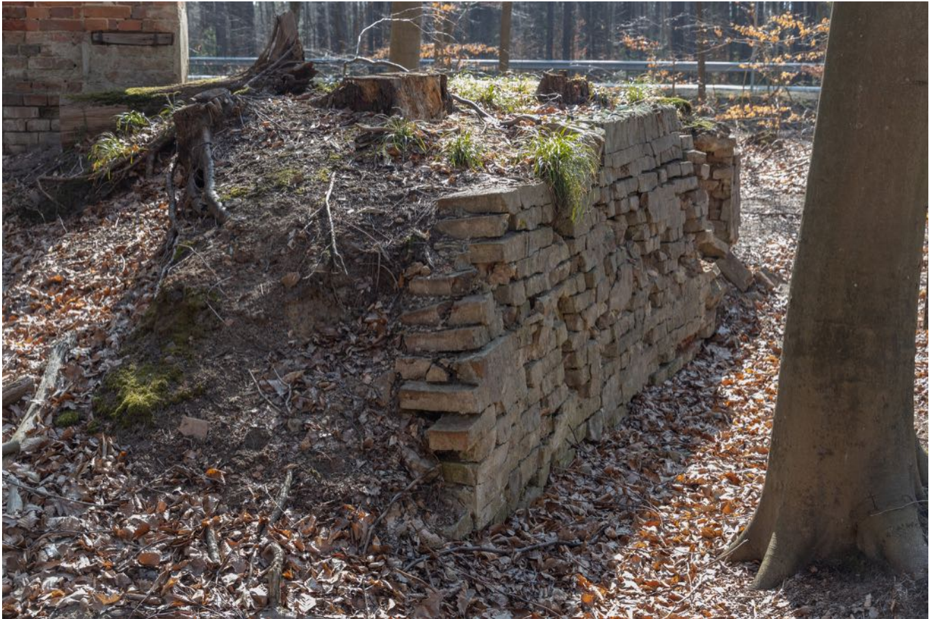
Fot. 3. Amfiteatr, mur oporowy
