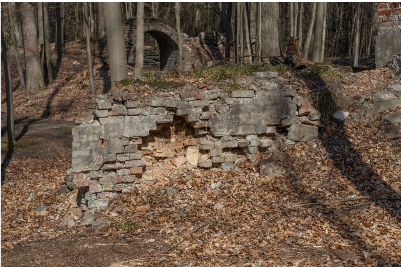
Fot. 2. Amfiteatr, mur oporowy
