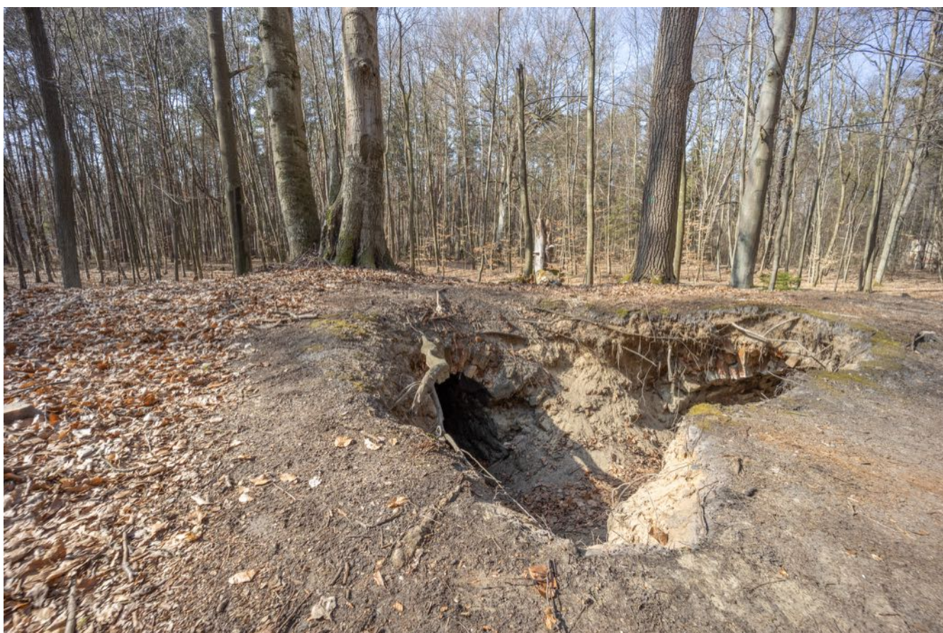
Fot. 22. Ciemne Ganki, zapadnięte sklepienie
