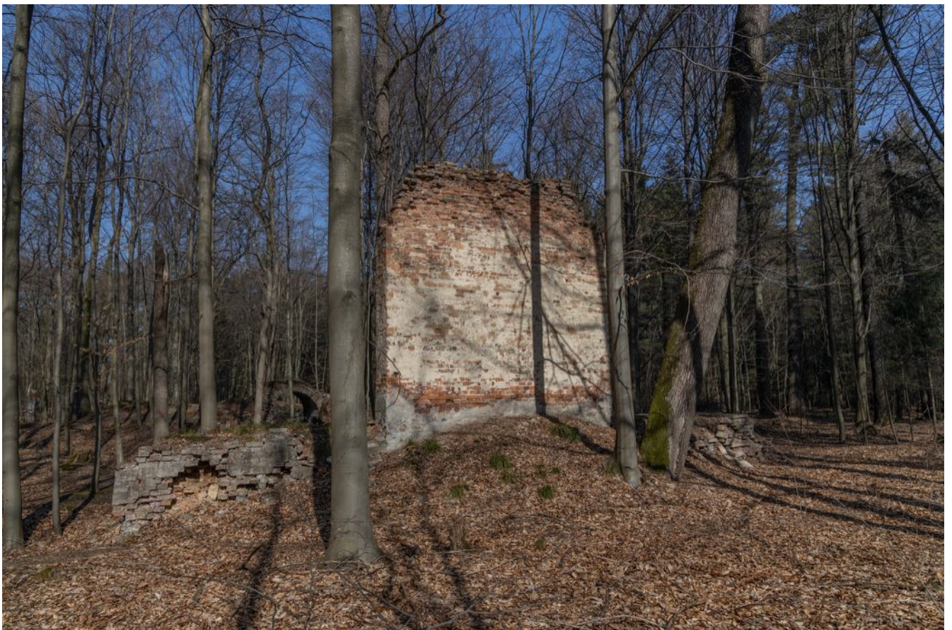
Fot. 4. Amfiteatr, ściana na której wieszano niezachowane malowidło
