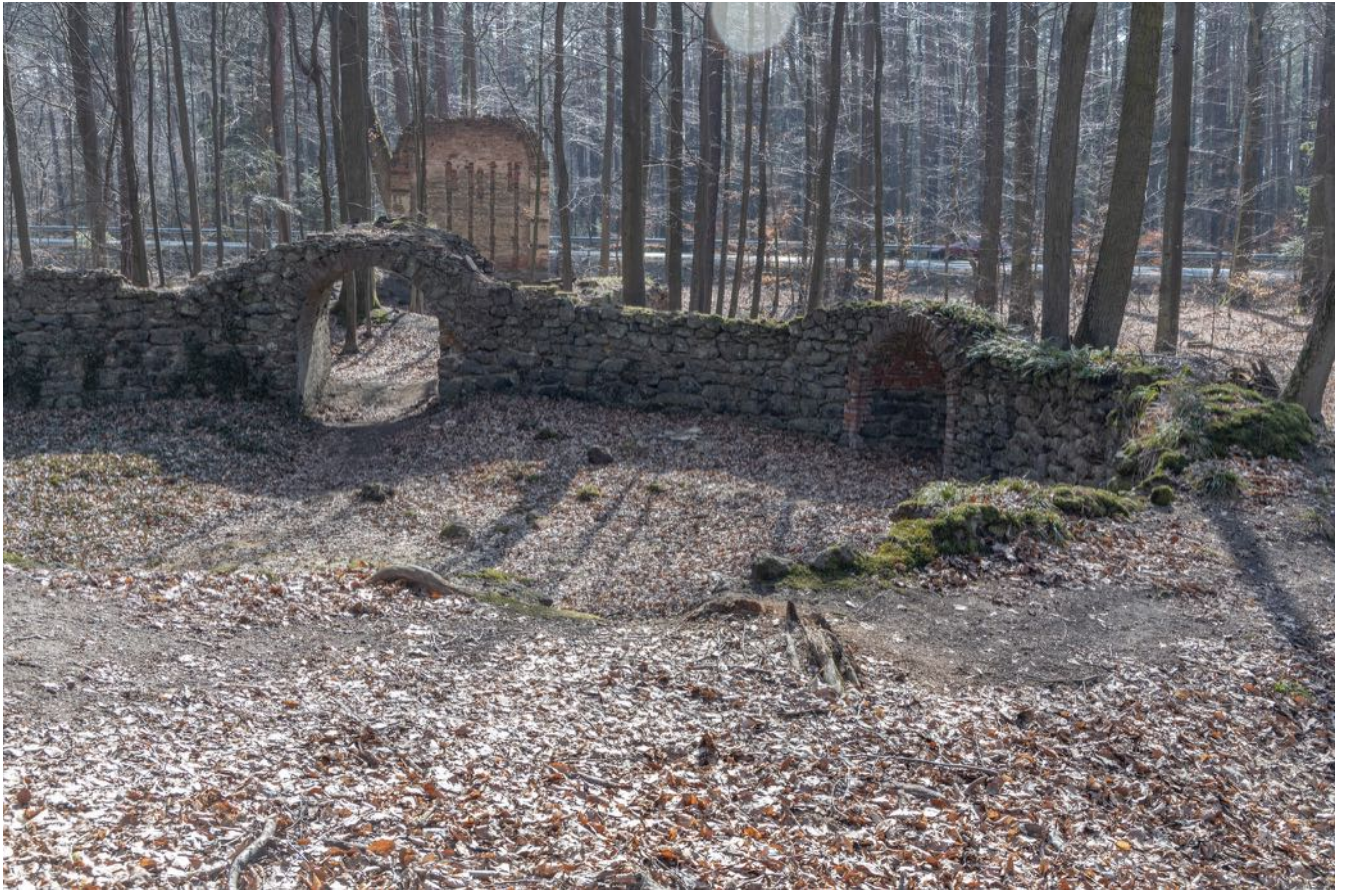
Fot. 7. Rotunda, widok ogólny w stronę bramy
