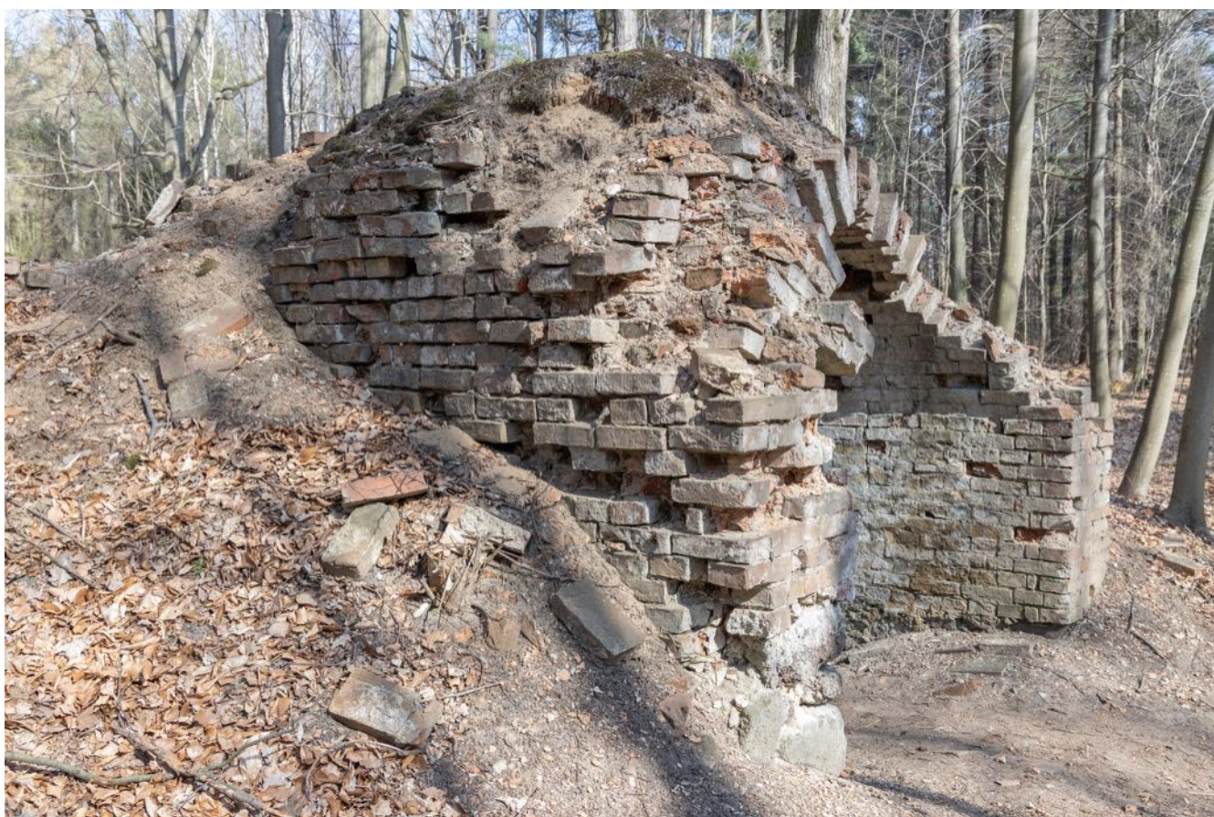
Fot. 6. Rotunda, brama wejściowa
