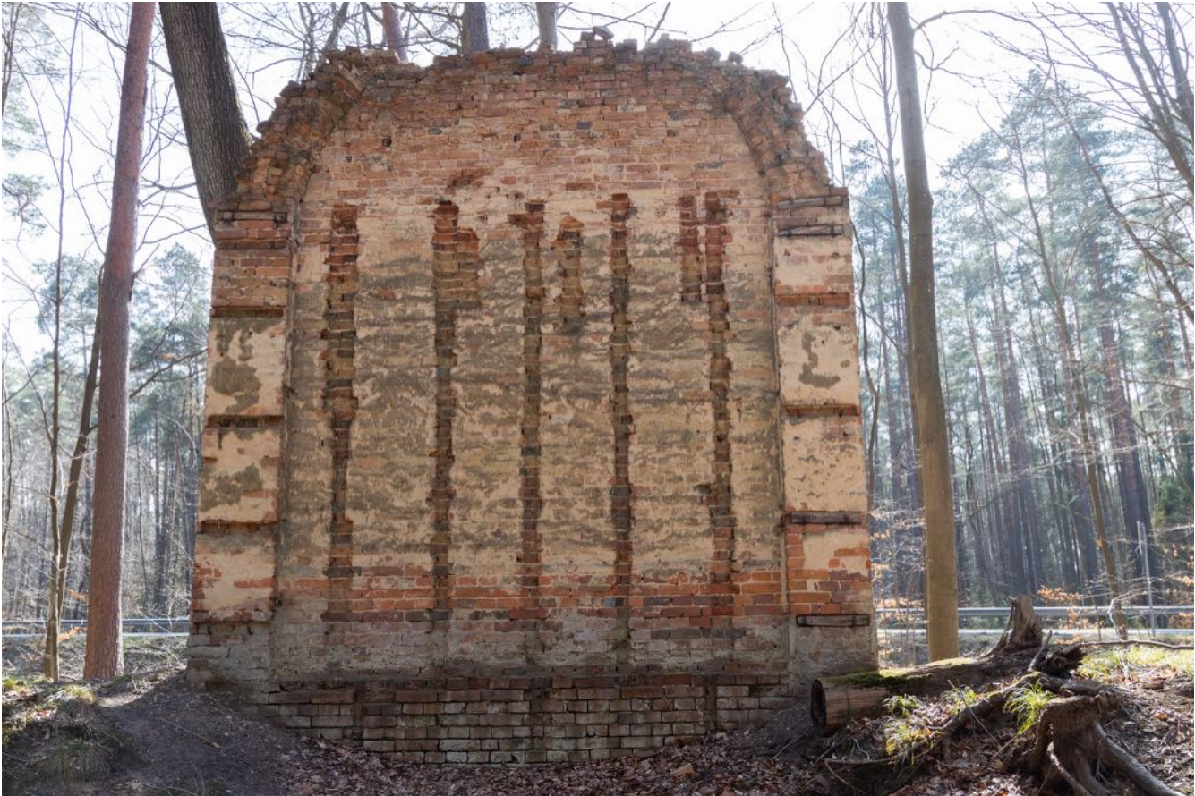
Fot. 1. Amfiteatr, ściana na której wieszano niezachowane malowidło
