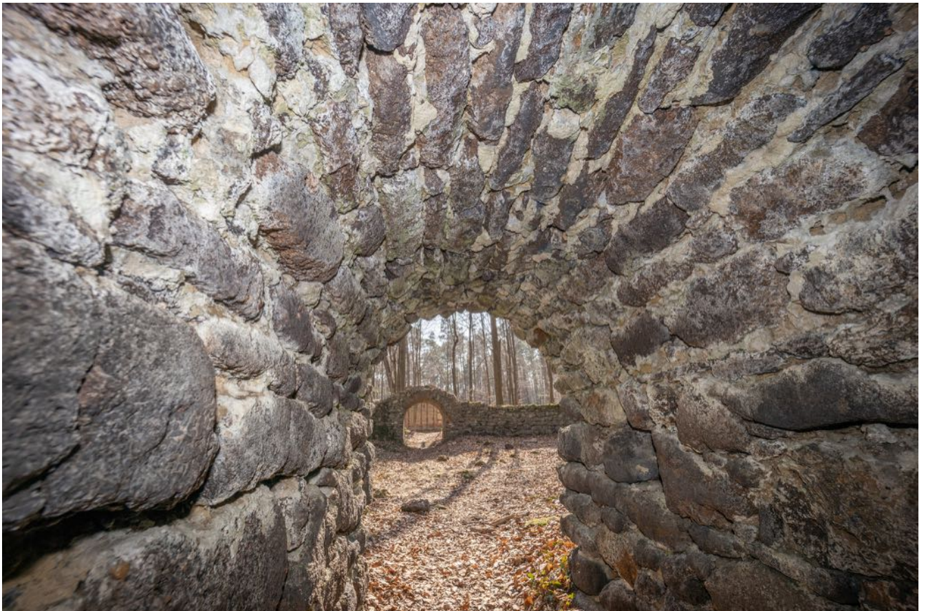
Fot. 20. Ciemne Ganki, wewnątrz, widok w stronę wejścia
