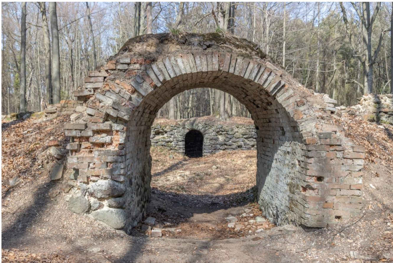
Fot. 5. Rotunda, brama wejściowa
