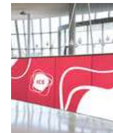
09 / Wyklejenie szklanych balustrad
