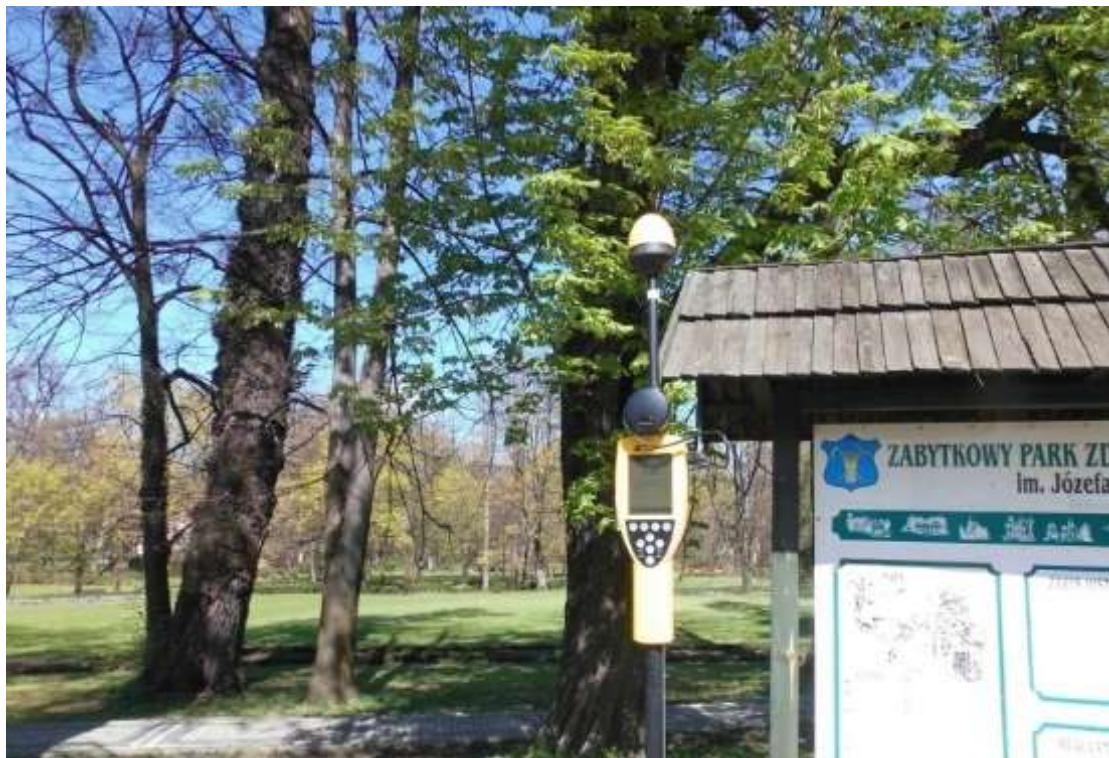
Fot. 4. Przyrząd pomiarowy w trakcie wykonywanego badania
