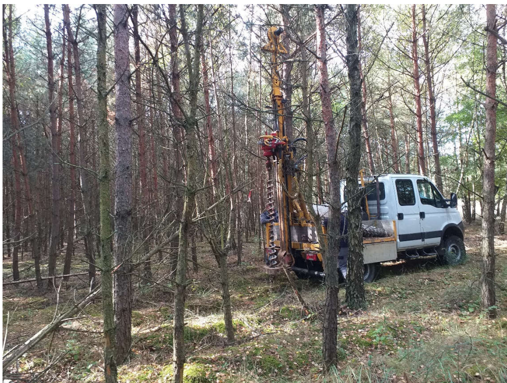
Fotografia nr 2. Wiercenie otworu badawczego (21.09.2021 r.).
