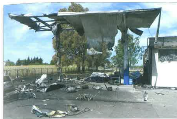
◆ Stacja paliw w Sokołowie Podlaskim po wybuchu gazu; 2015 rok.
