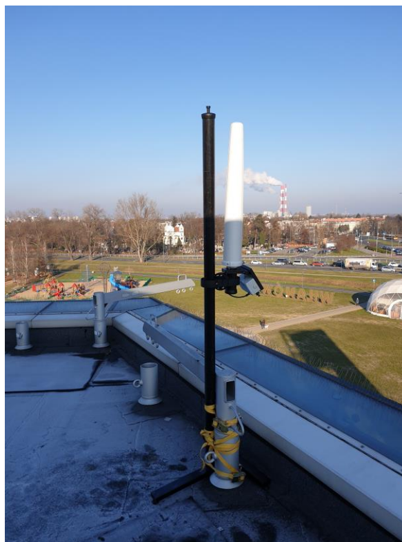
Rys. 2 Miejsce montażu pilotażowego SMS PEM – UM Warszawa Wilanów
