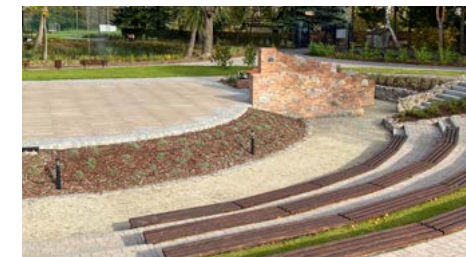
Park im. Armii Krajowej w Węgrowie, kostka brukowa z cementu CEM II/B-M (S-V) 42,5 R.
