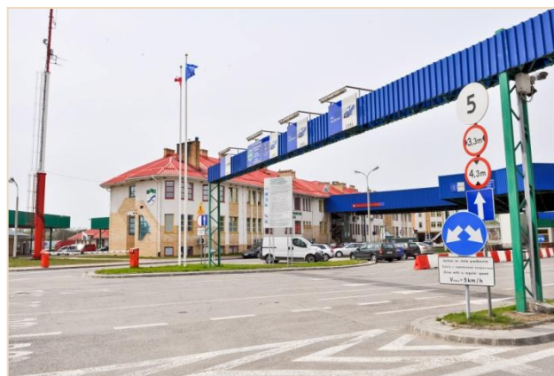
Ogólny widok na przejście graniczne w Bobrownikach.
