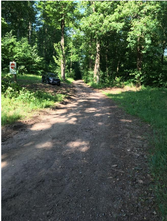
Widoczne koleinowanie, brak poboczy, zarośnięte pobocza
