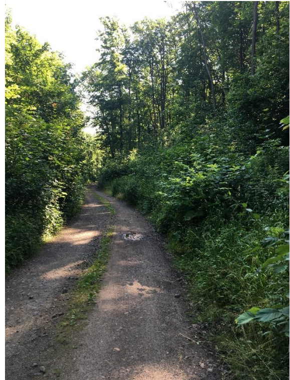
Koleinowanie, brak poboczy, zarośnięte i niedrożne rowy
