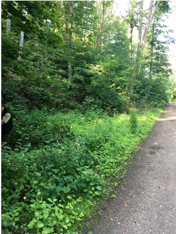
Konieczne odtworzenie rowu, ścięcie poboczy, usunięcie koleinowania
