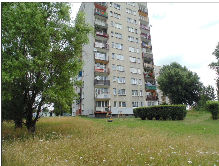
Fot. 2. Rejon badań, widok w kierunku północno-wschodnim
