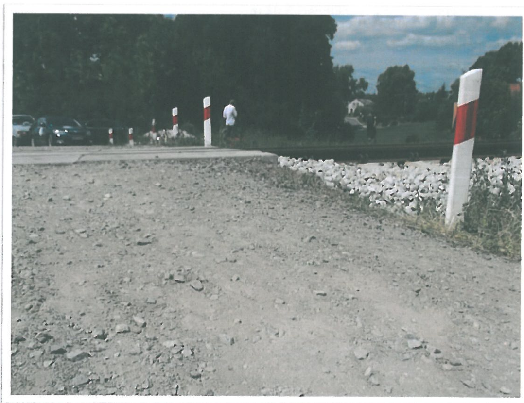
Nawierzchnia drogi dojazdowej gruntowa – kruszywo łamane.
