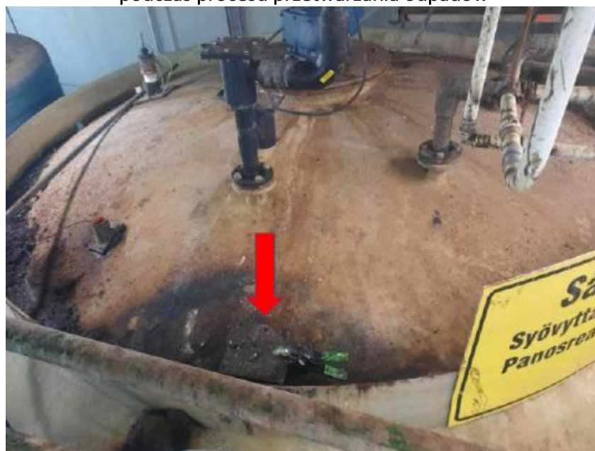
Rysunek 1. Miejsce pobierania próbek toksycznych gazów uwalnianych w górnej części reaktora podczas procesu przetwarzania odpadów
