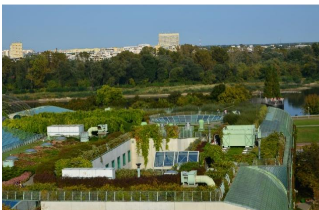
Fotografia 10. Ogród na dachu Biblioteki Uniwersytetu Warszawskiego.
