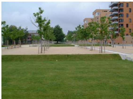
Fotografia 5-6. System zagłębień-niecek, rowów chłonnych i rynien służących retencji wód opadowych w Parku Scharnhäuser w m. Ostfildern, rejon Stuttgartu [7].
