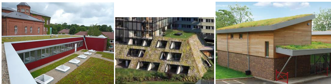
Fotografia 9. Zielony dach typu lekkiego (po lewej) i skośnego (pośrodku i po prawej).
