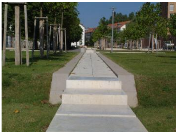
Fotografia 5-6. System zagłębień-niecek, rowów chłonnych i rynien służących retencji wód opadowych w Parku Scharnhäuser w m. Ostfildern, rejon Stuttgartu [7].
