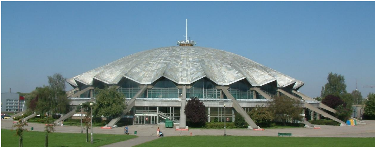
Fot. 27 Hala Arena - widok zewnętrzny obiektu.
