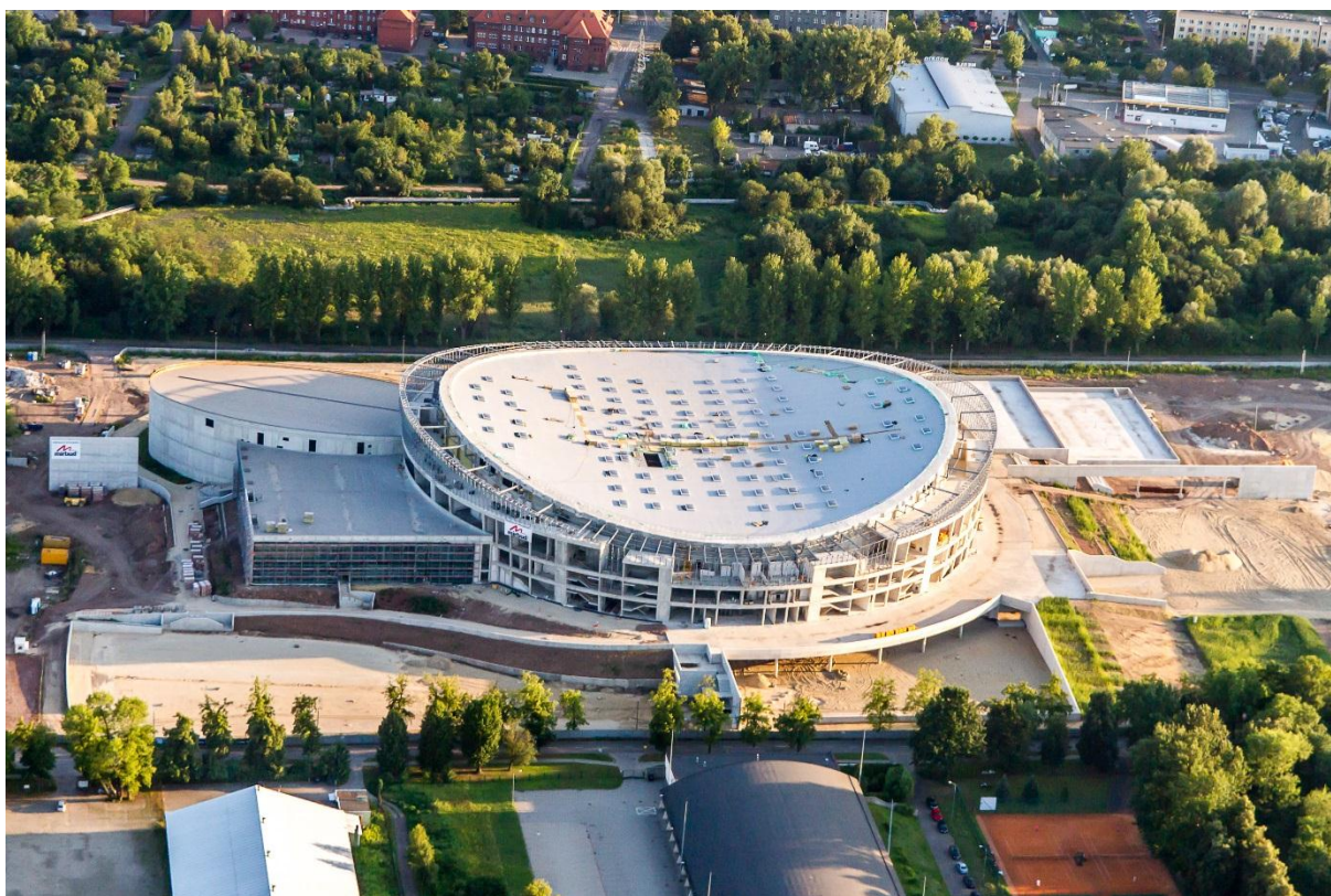
Fot. 5 Hala Gliwice - widok zewnętrzny obiektu.
