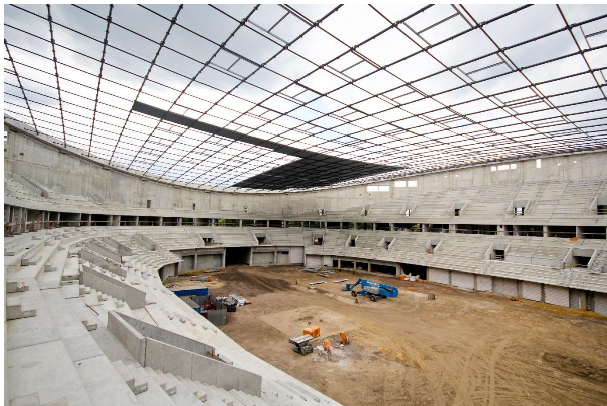
Fot. 6 Hala Gliwice - widok wewnątrz budowanego obiektu.
