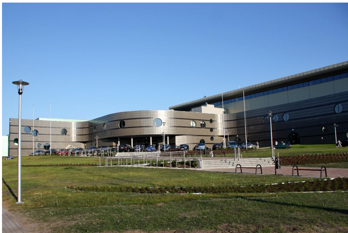
Fot. 33 CRS Hala Główna - widok zewnętrzny obiektu.
