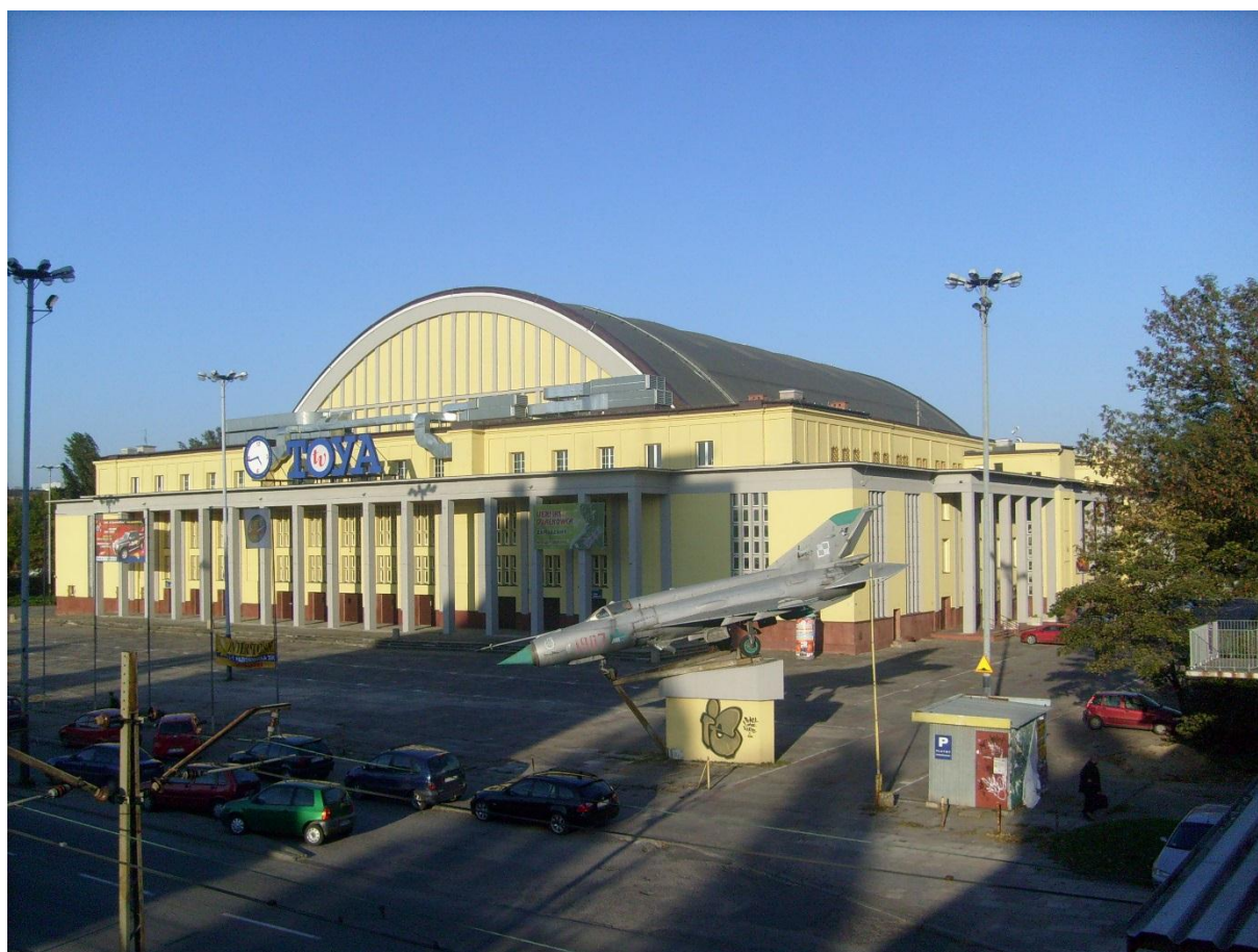
Fot. 11 Hala MOSiR Łódź - widok zewnętrzny obiektu.
