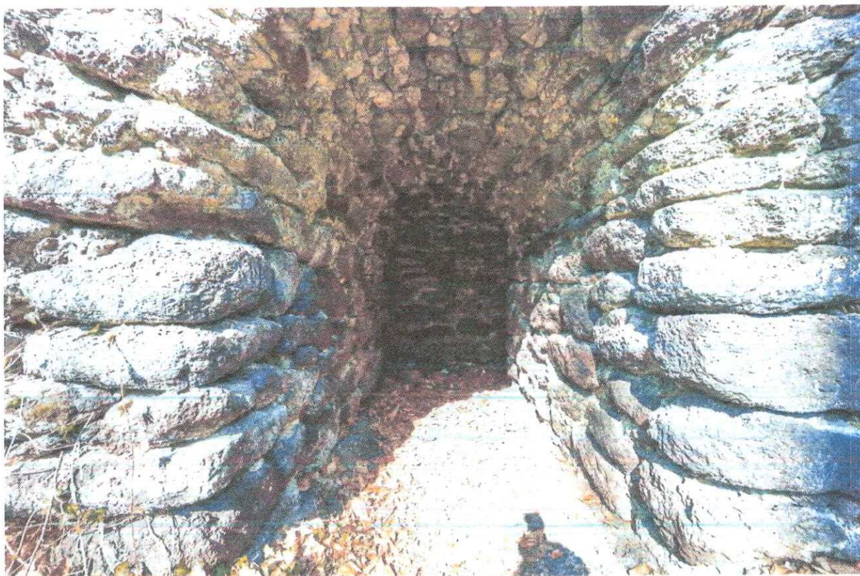
Fot. 14. Wejście do Ciemnych Ganków
