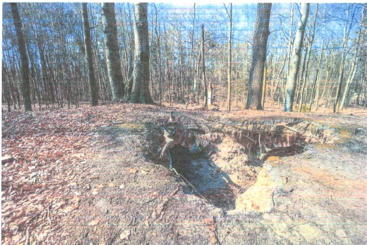
Fot. 22. Ciemne Ganki, zapadnięte sklepienie
