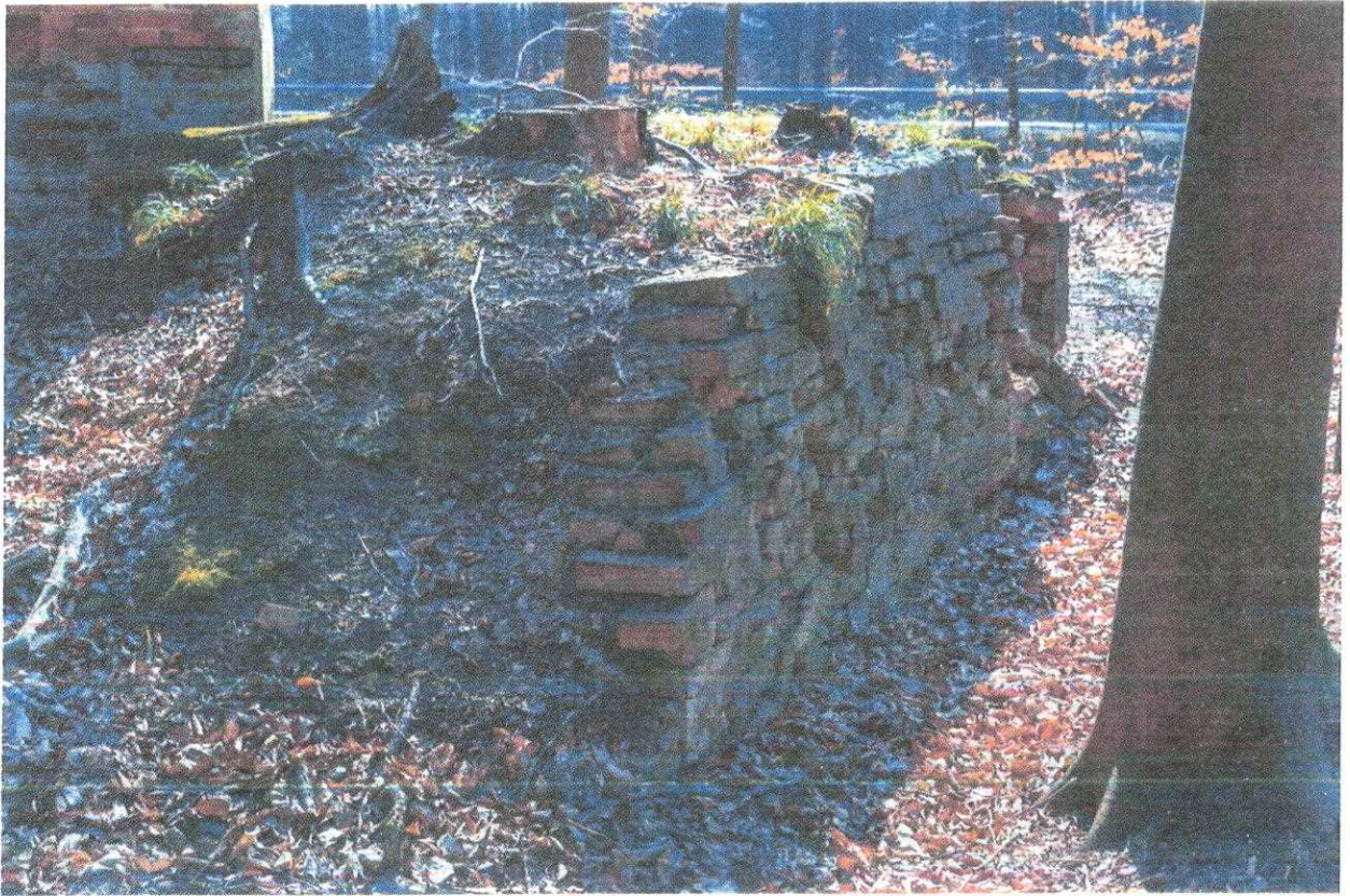
Fot. 3. Amfiteatr, mur oporowy
