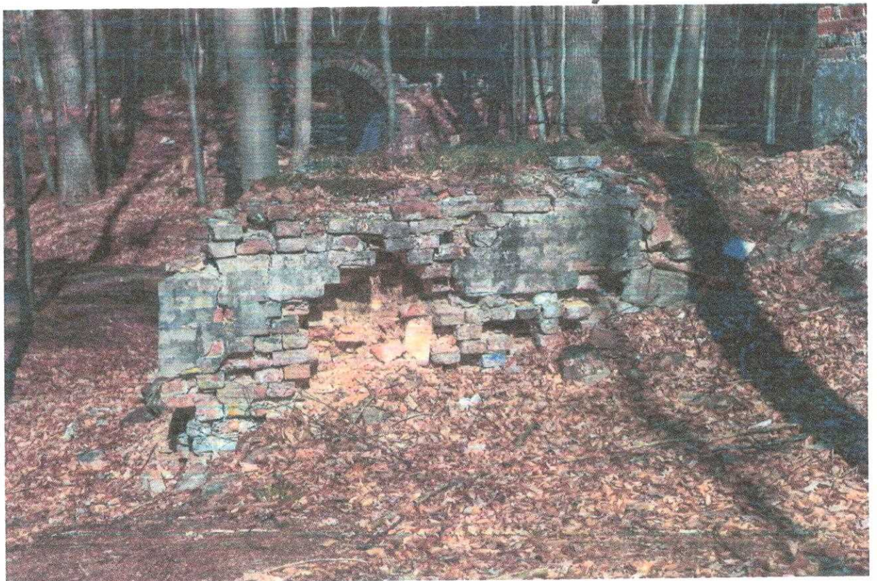
Fot. 2. Amfiteatr, mur oporowy
