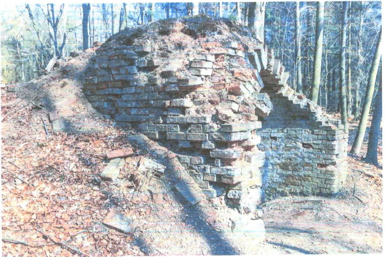
Fot. 6. Rotunda, brama wejściowa
