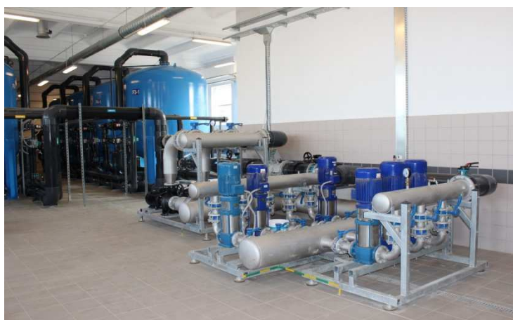
Stacja uzdatniania wody w Nisku
