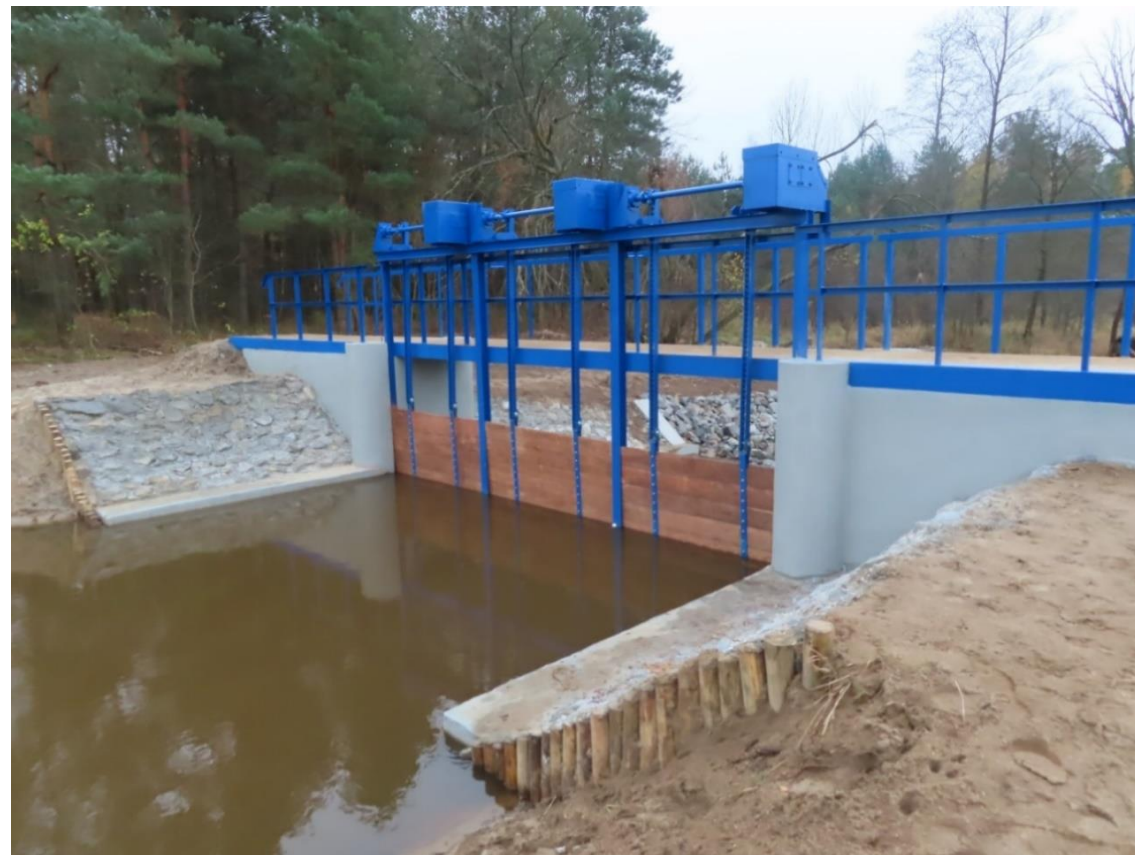
Jaz w km 22+495 na potoku Tuszymka Duża w m. Ruda
