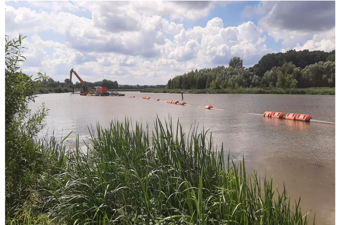
Refuler wydobywający osady na brzeg na Zalewie Rzeszowskim. Październik 2022
