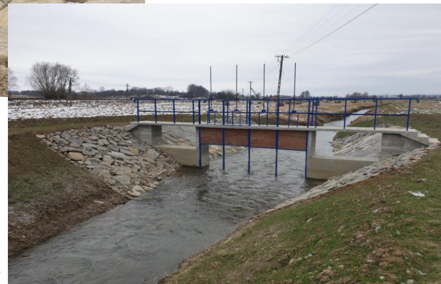
Jaz w km 2+200 na cieku potok Czarny
