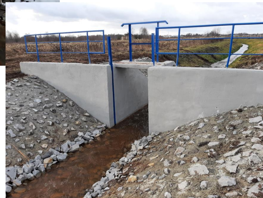
Zastawka w km 1+568 na potoku Grądzkim w m. Rzemień
