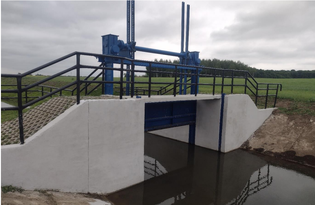
Jaz w km w km 15+546 na potoku Mrowla
