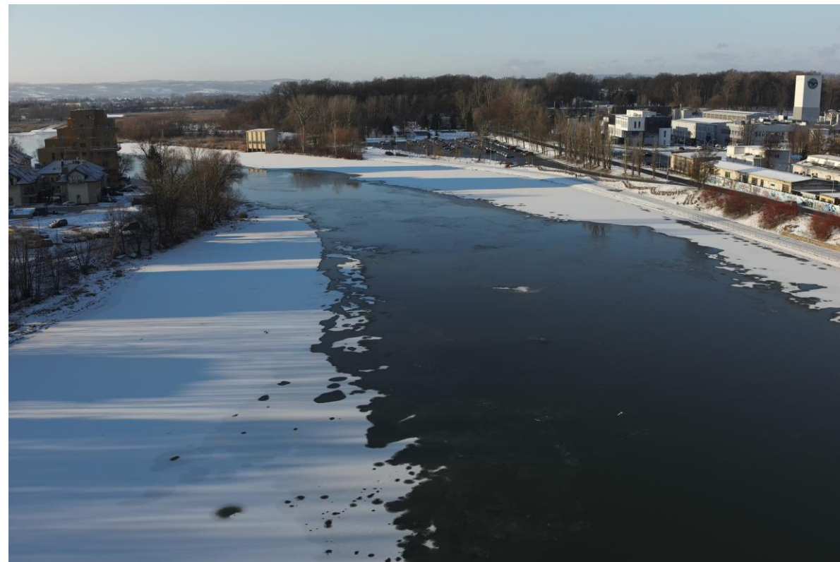
Zbiornik Rzeszowski po zakończeniu prac – luty 2023
