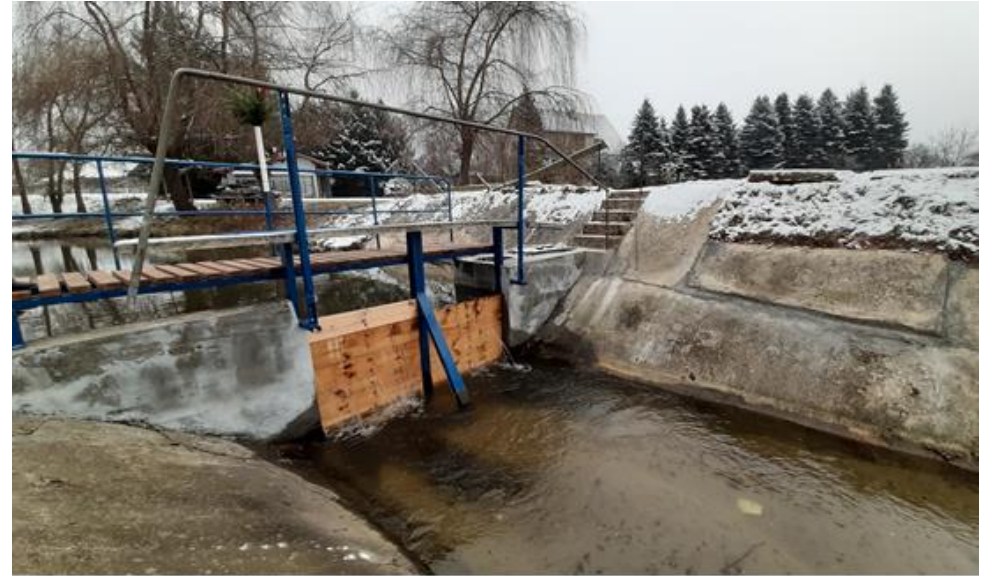
Fot. Zdjęcie zastawki po remoncie - rzeka Żołynianka
