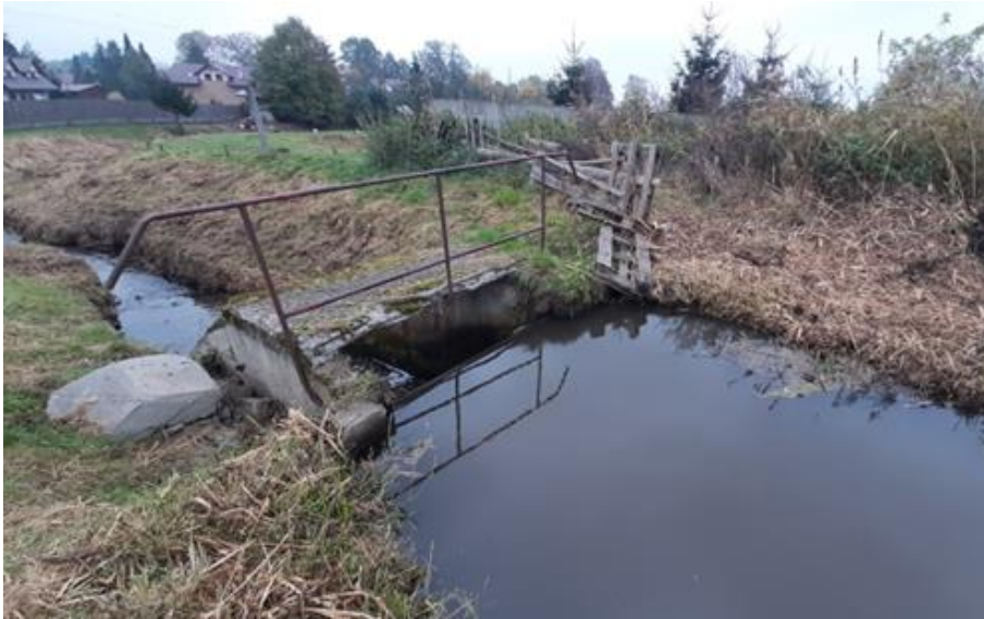
Fot. Zdjęcie zastawki przed remontem – rzeka Żołynianka
