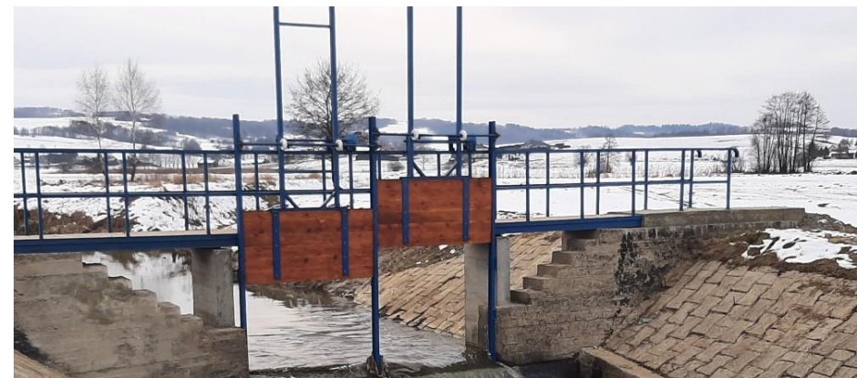
Zastawka w km 45+148 na cieku Wielopolka
