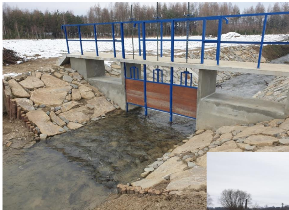
Jaz w km 6+000 na cieku potok Czarny
