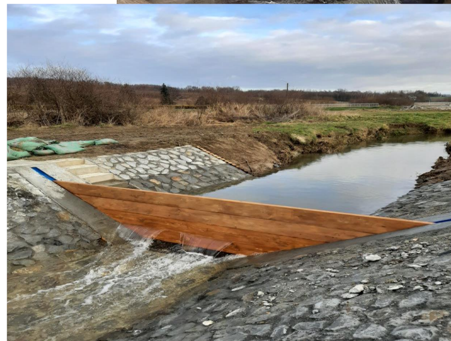
Zastawka w km 51+396 na cieku Wielopolka
