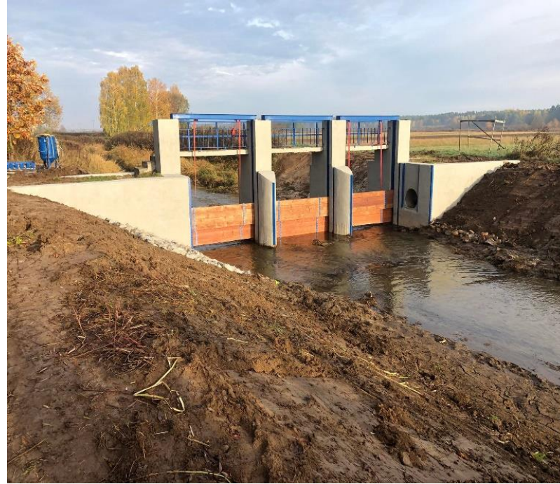
Fot. Jaz na rzece Lubaczówka w miejscowości Lisie Jamie-po remoncie
