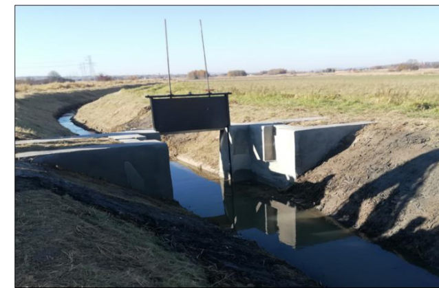
Fot. Zastawka betonowa na potoku Marcinek po remoncie
