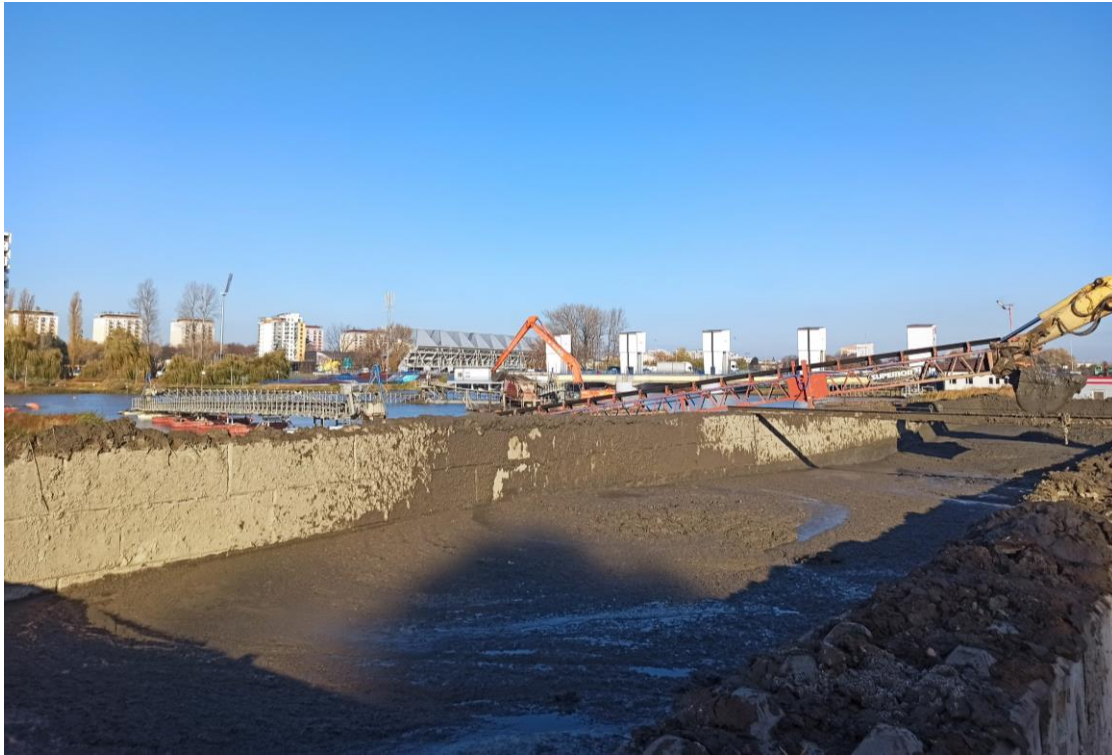
Miejsce tymczasowego składowania osadów na brzegu zbiornika
