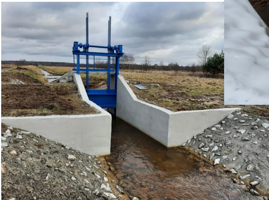
Jaz w km 0+757 na potoku Grądzkim w m. Rzemień.
