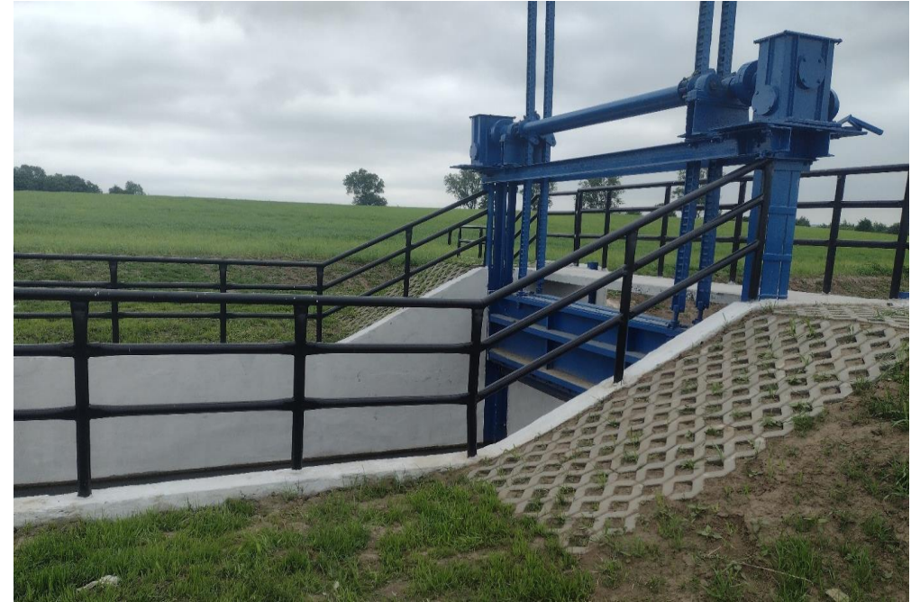
Jaz w km w km 15+546 na potoku Mrowla
