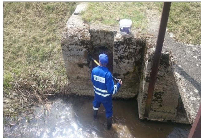
Fot. Prace związane z odtworzeniem zastawki piętrzącej na potoku Marcinek w Krośnie – widok na lewy przyciótek budowli
