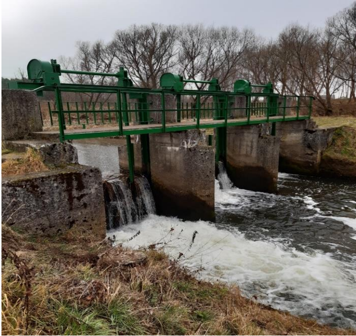
Fot. Jaz na rzece Lubaczówka w miejscowości Lisie Jamy przed remontem
