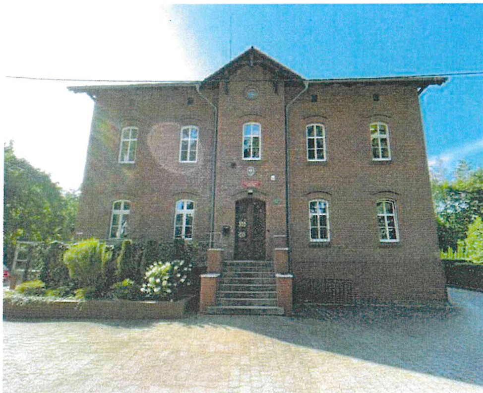
Fot. 1 Elewacja frontowa
