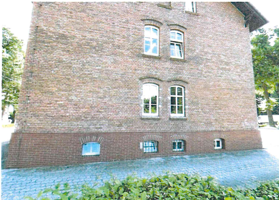
Fot. 4 Elewacja boczna – widoczny cokół licowany płytkami
