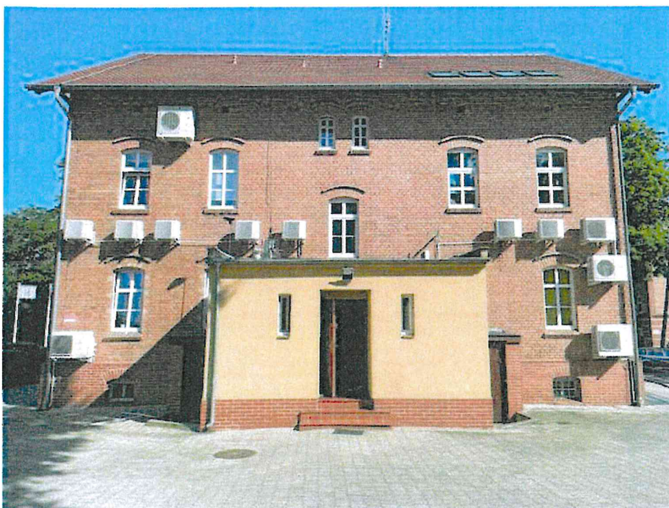
Fot. 2 Elewacja tylna
