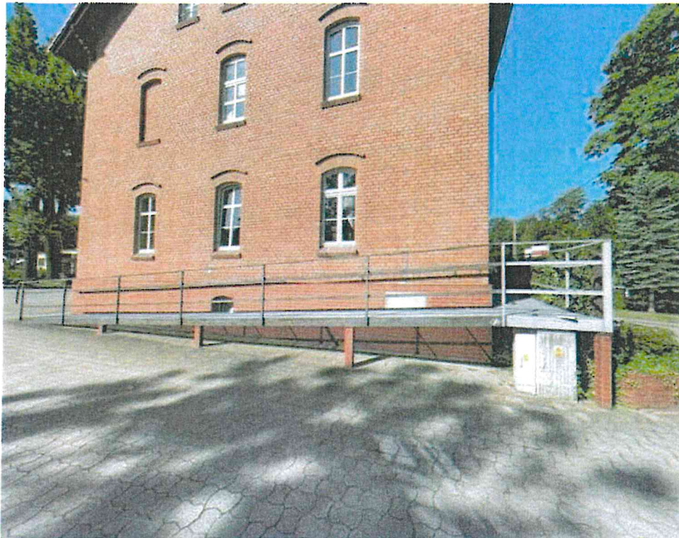
Fot. 3 Elewacja boczna – podjazd
