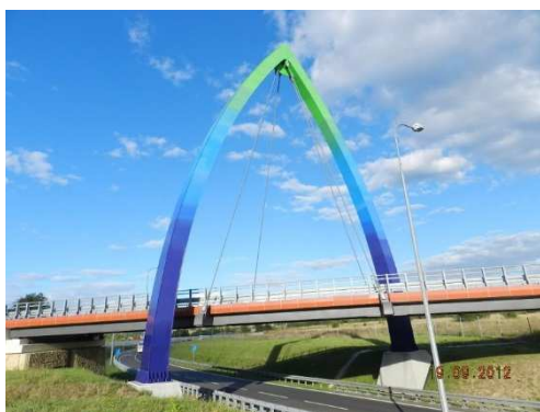
Rys. 3.291. Stalowy pylon o nietypowej konstrukcji oraz betonowe fundamenty pylonu niewykazujące uszkodzeń
