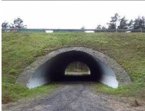
Rys. 3.266. Obiekt gruntowo-powłokowy o przekroju zamkniętym, stan fundamentu niewzbudzający zastrzeżeń. Nie stwierdzono osiadań konstrukcji, deformacji powłoki z blachy falistej i innych ewentualnych uszkodzeń spowodowanych złym stanem fundamentu
