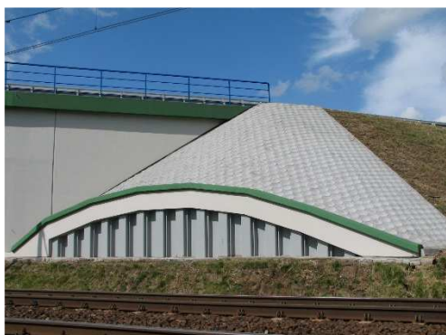
Rys. 3.318. Konstrukcja oporowa o wysokości większej niż 1.5 m utrzymująca betonowe umocnienie stożka i nasyp drogowy przy przyczółku w bardzo dobrym stanie
