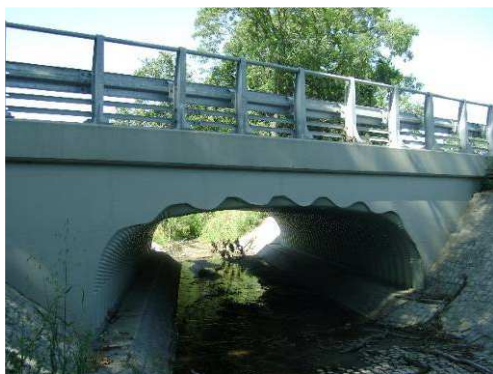
Rys. 3.149. Zasyпка i ściany boczne niewykazujące uszkodzeń
