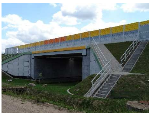
Rys. 3.16. Balustrady przy schodach skarpowych i na murze oporowym, chroniące pracowników obsługi przed upadkiem, skarpy nasypów oraz betonowe umocnienia skarp – bez uszkodzeń
