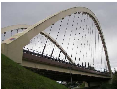
Rys. 3.365. Wieszaki w dobrym stanie technicznym
