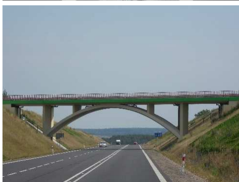
Rys. 3.184. Dźwigar łukowy w przęśle centralnym oraz dźwigary płytowe w przęsłach skrajnych niewykazujące uszkodzeń
