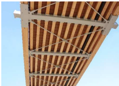
Rys. 3.139. Drewniane elementy pomostu nie wykazują uszkodzeń
