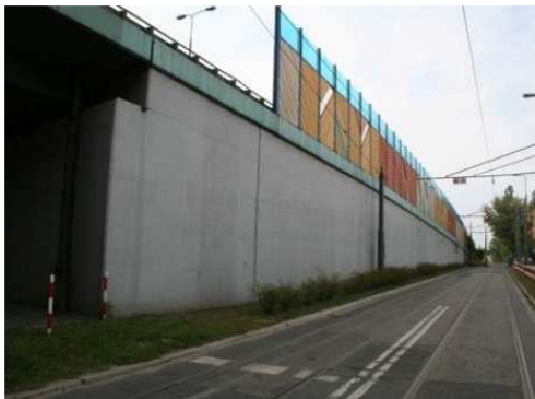
Rys. 3.314. Konstrukcja oporowa przyległa do przyczółka w bardzo dobrym stanie
