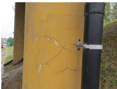
Rys. 3.283. Rysy skurczowe z białymi wyługowaniami na bocznych powierzchniach słupów filara
