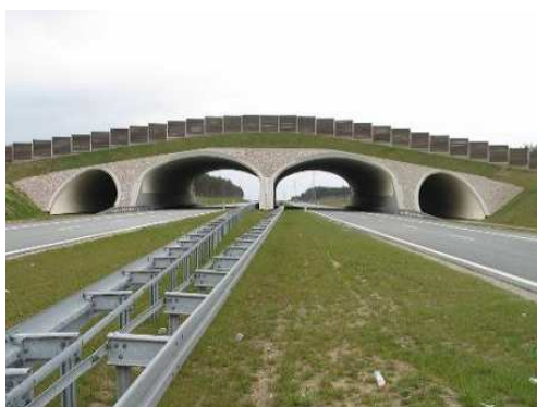
Rys. 3.292. Filary czteroprzęsłowego przejścia dla zwierząt bez uszkodzeń
