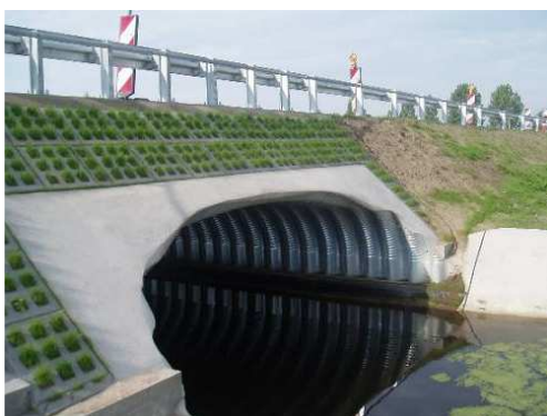
Rys. 3.86. Konstrukcja gruntowo-powłokowa bez gzymsu. Ewentualne uszkodzenia umocnienia zasypki należy oceniać w wierszu „Nasypy i skarpy”
