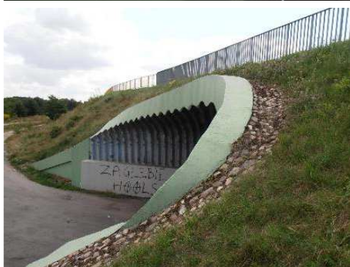
Rys. 3.82. Gzyms (wieniec betonowy) na krawędzi konstrukcji z blachy falistej bez uszkodzeń, w dobrym stanie technicznym
