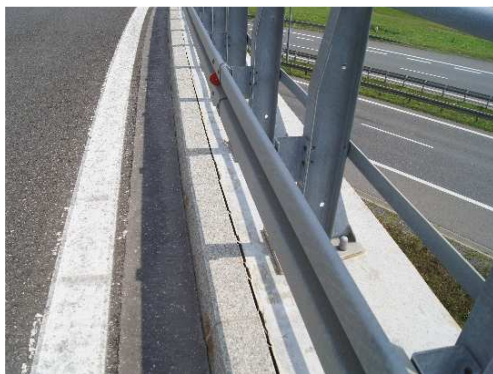
Rys. 3.46. Pęknięcie pojedyncze pomiędzy krawężnikiem a betonem kapy (nieszczelne spojenie technologiczne) na całej długości pobocza technicznego wyniesionego
