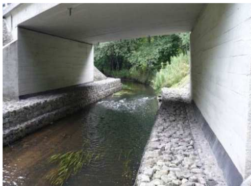
Rys. 3.294. Koryto rzeki i przestrzeń podmostowa bez zastrzeżeń
