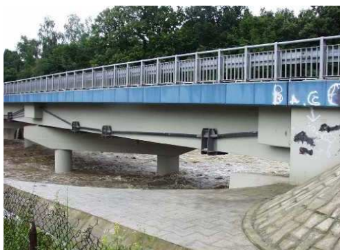
Rys. 3.344. Stan dewiatorów i zakotwień kabli sprężających wzmacniających dźwigary żelbetowe niewzbudzający zastrzeżeń
