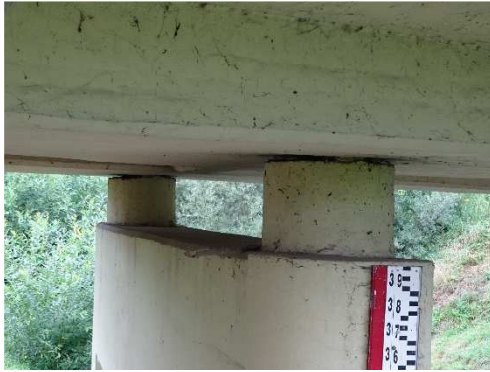
Rys. 3.227. Łożysko przegubowe betonowe w dobrym stanie, niewielkie zanieczyszczenie w przegubie, brak widocznych uszkodzeń na powierzchniach zewnętrznych w otoczeniu przegubu
