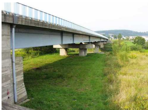
Rys. 3.295. Przestrzeń podmostowa bez zastrzeżeń
