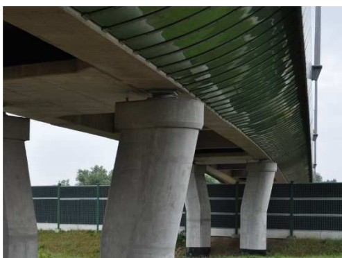
Rys. 3.71. Osłona boczna, pełniąca funkcję dekoracyjną/maskującą, w dobrym stanie (na elementach osłon widoczne refleksy świetlne)
