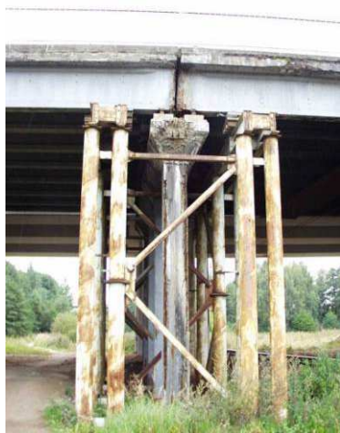
Rys. 3.279. Podpora tymczasowa wzmocniająca osłabiony filar żelbetowy
