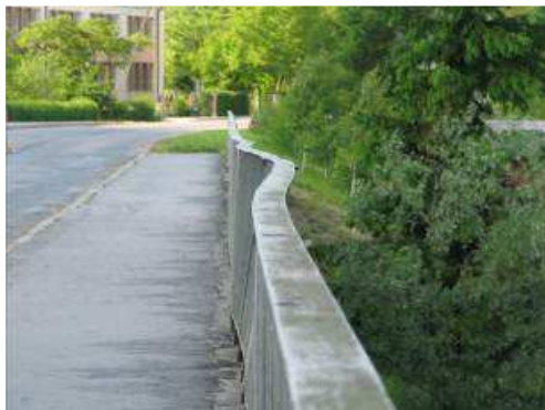
Rys. 3.60. Deformacja o wielkości 10-15 cm w stosunku do pierwotnego położenia, osłabienie zamocowania balustrady do pomostu
