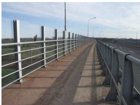
Rys. 3.327. Ekran przeciwhałasowy w dobrym stanie
