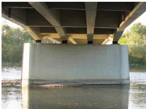
Rys. 3.267. Filar bez uszkodzeń
