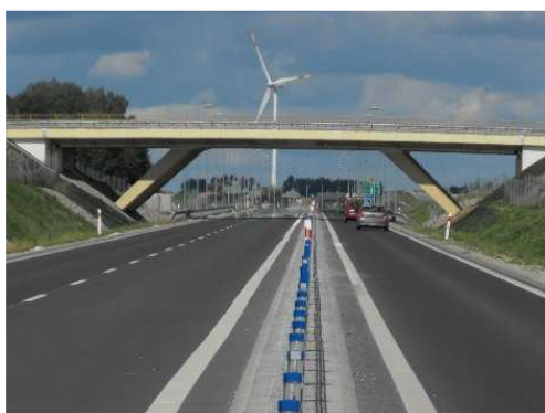
Rys. 3.183. Rygiel ramy kozłowej o konstrukcji płytowo-belkowej niewykazujący uszkodzeń
