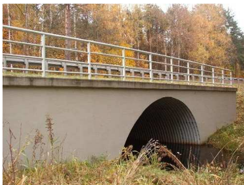
Rys. 3.148. Zasyпка i ściany boczne niewykazujące uszkodzeń
