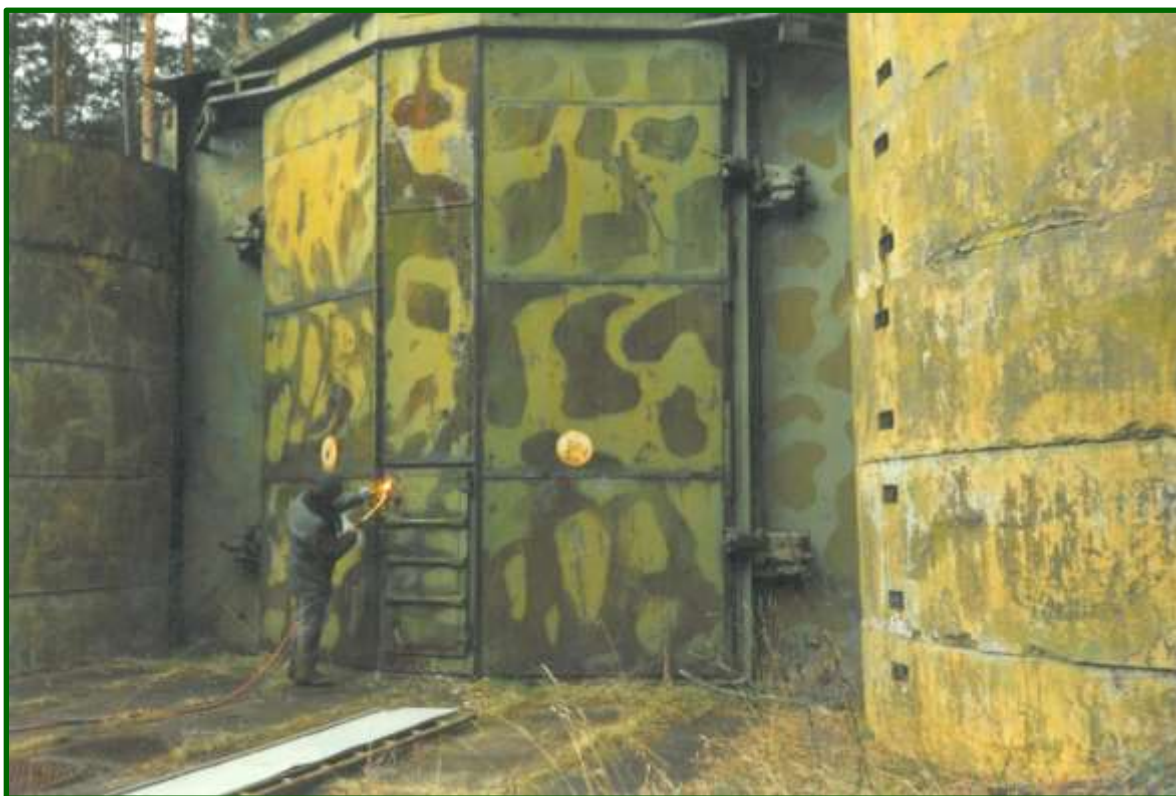
Fot. 14. Magazyn broni jądrowej typu „Granit” (fot. N-ctwo Jastrowie)
