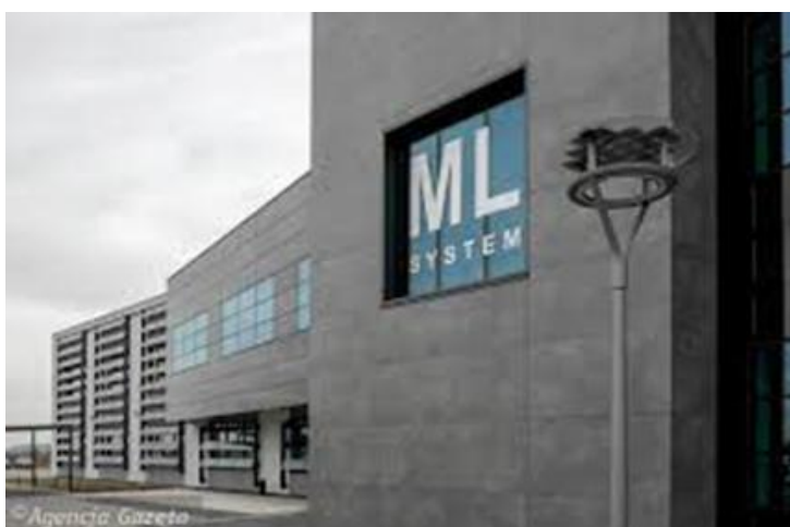
Rys. 16. Budynek produkcyjny z częścią biurowo-socjalną i laboratorium badawczym w Zaczerniu.
