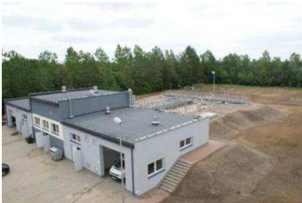
Przebudowa i rozbudowa oczyszczalni ścieków w Nekli
