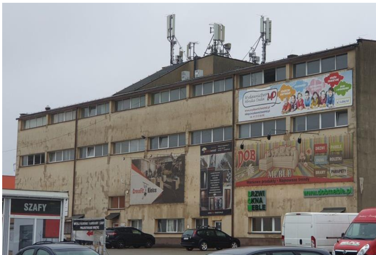
Fot. 1: Widok anten stacji bazowych: ID: KIE1016_C oraz ID: 55315 (27315), zlokalizowanych pod adresem: ul. Zagnańska 71, 25-558 Kielce
