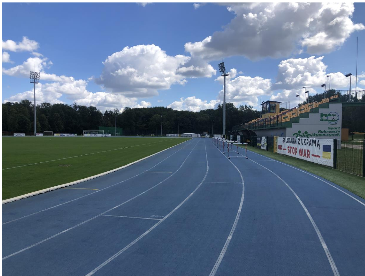
Fot. 3 Widok ogólny badanego obiektu – główna prosta
