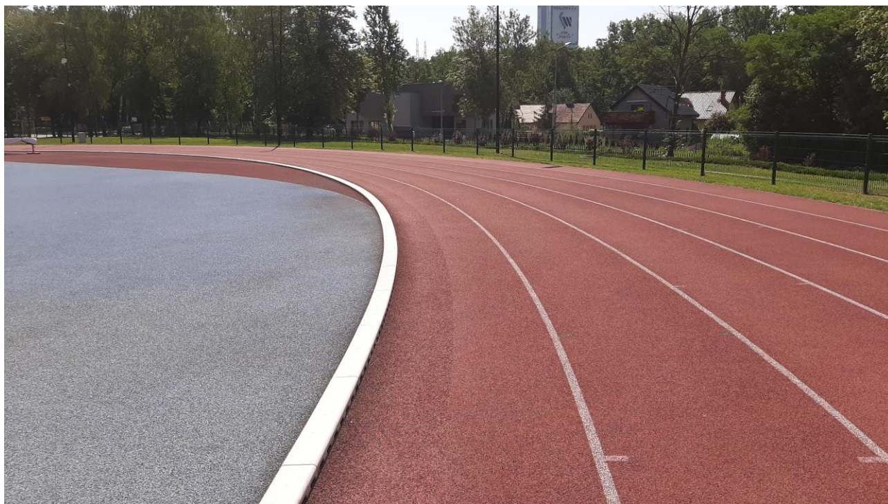
Fot. 4 Widoczny pas nowej nawierzchni przy odwodnieniu na łuku
