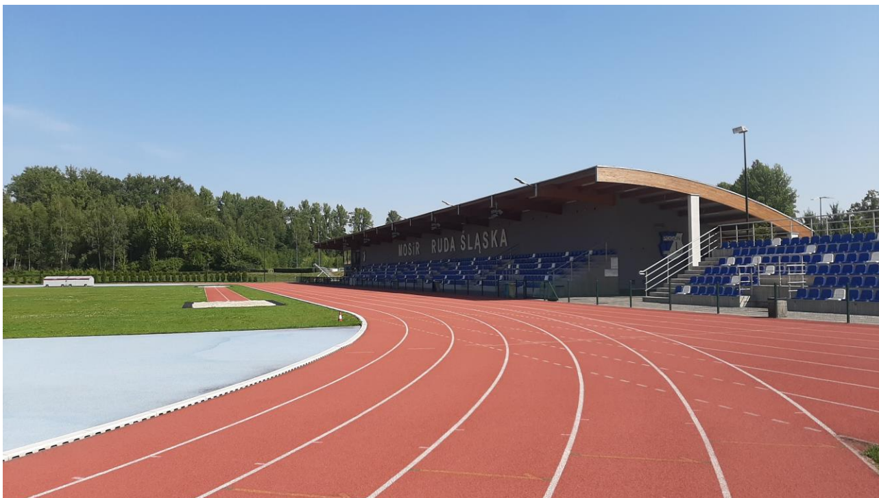
Fot. 1 Widok ogólny badanego obiektu – główna prosta
