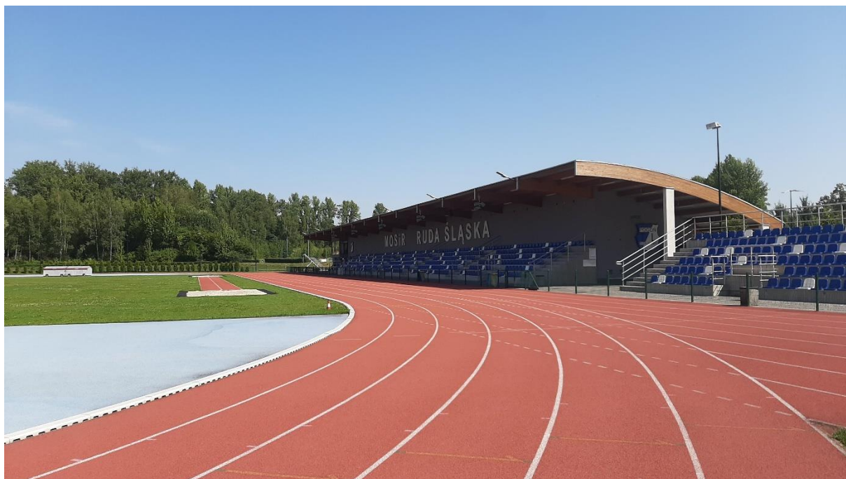
Fot. 7 Widok ogólny stadionu w Rudzie Śląskiej
