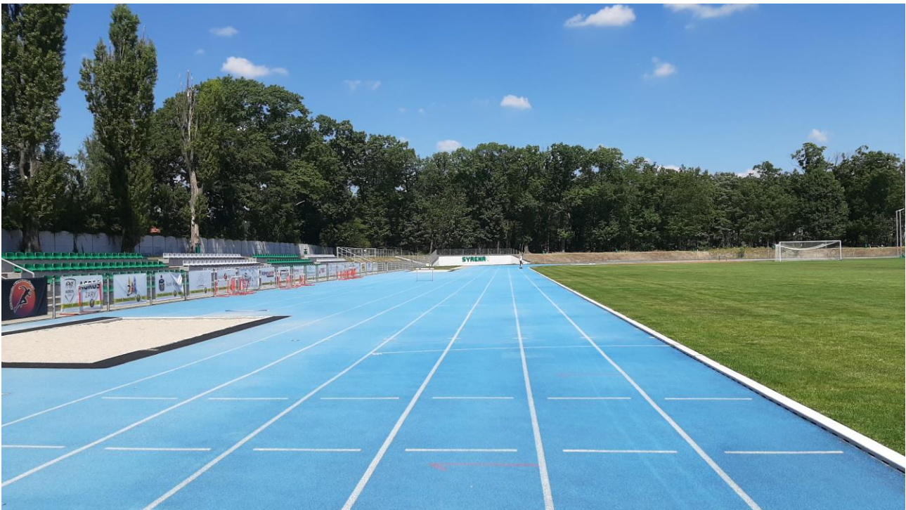
Fot. 1 Widok ogólny badanego obiektu – główna prosta
