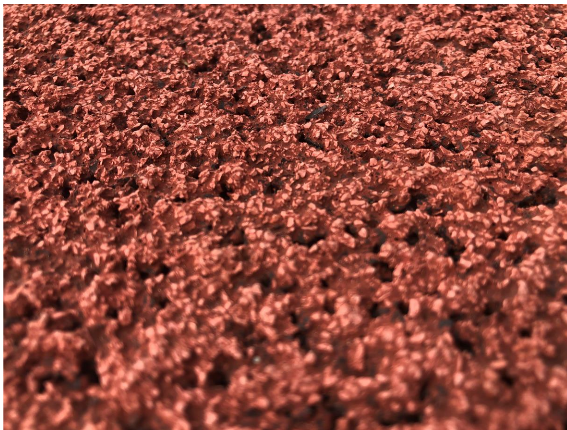
Fot. 4 Ślady wytarcia warstwy wierzchniej nawierzchni.
