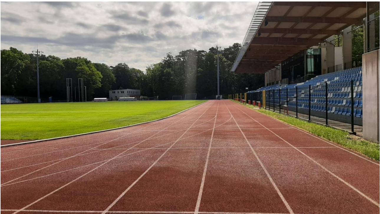
Fot. 1 Widok ogólny badanego obiektu – główna prosta
