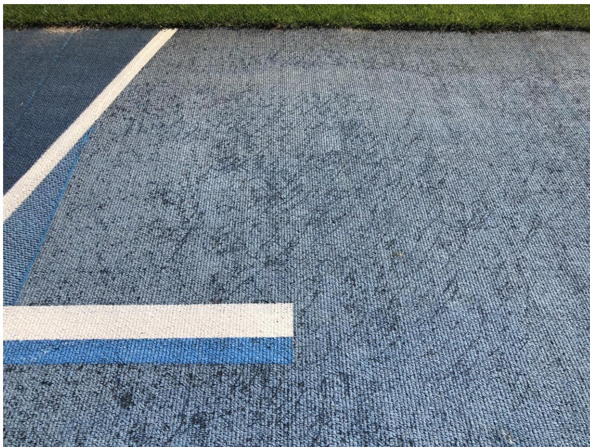
Fot. 7 Rysy pozostawione przez kolce lekkoatletyczne
