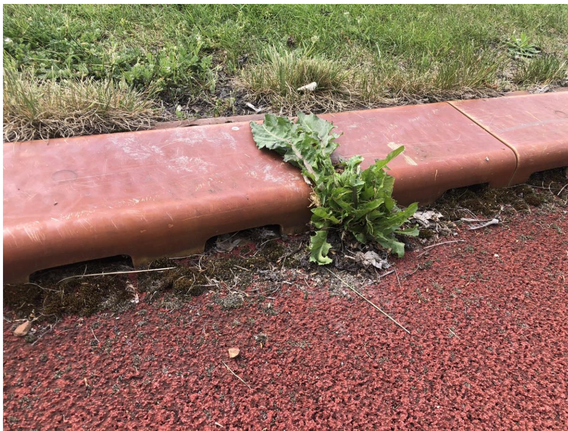
Fot. 5 Liczne zanieczyszczenia roślinne i rosnące chwasty przy linii odwodnienia
