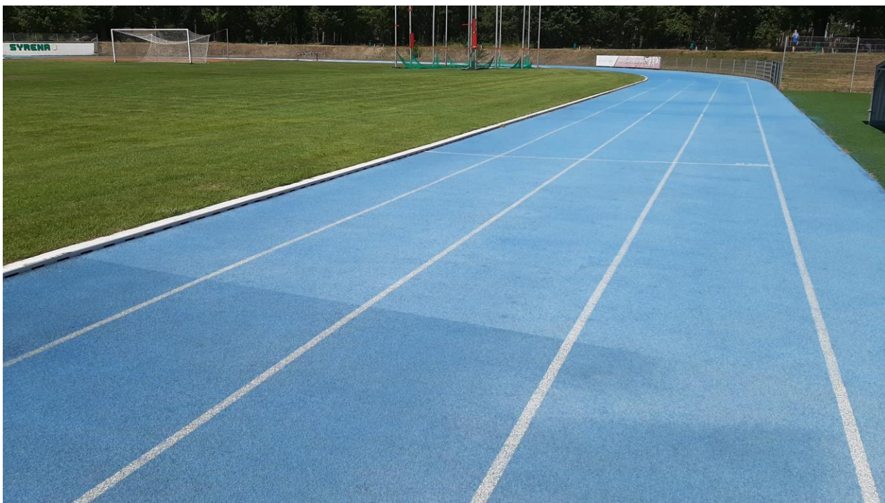
Fot. 4 Różnica w zabarwieniu pasów bieżni na łączeniu technologicznym
