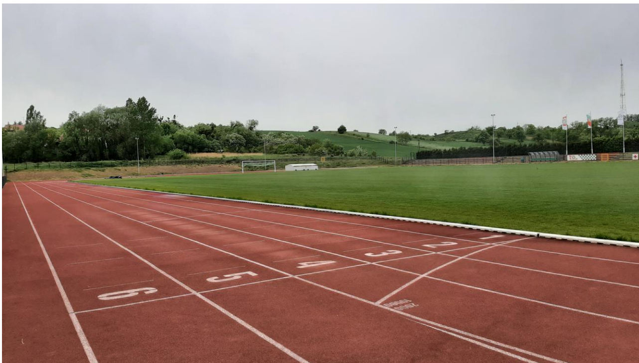
Fot. 1 Widok ogólny badanego obiektu – główna prosta
