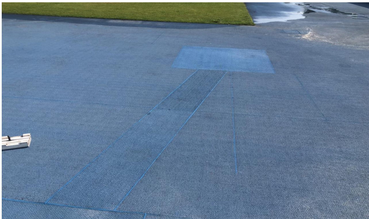
Fot. 4 Miejsce po naprawie
