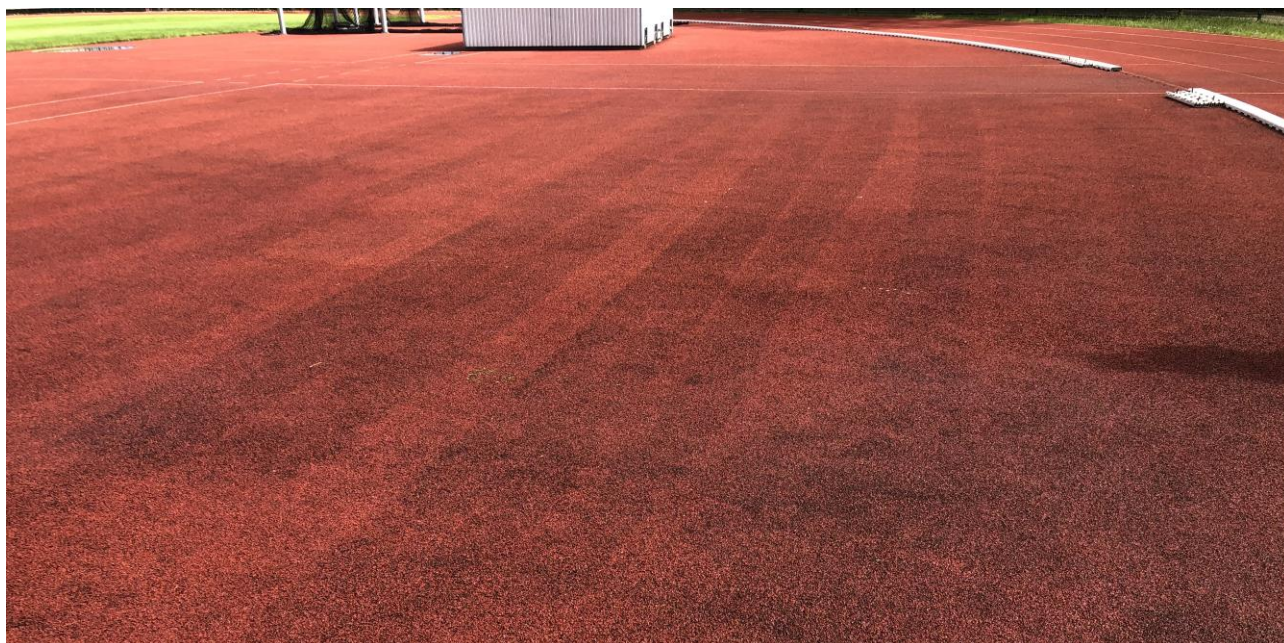
Fot. 4 Zakole D po przeprowadzonej konserwacji
