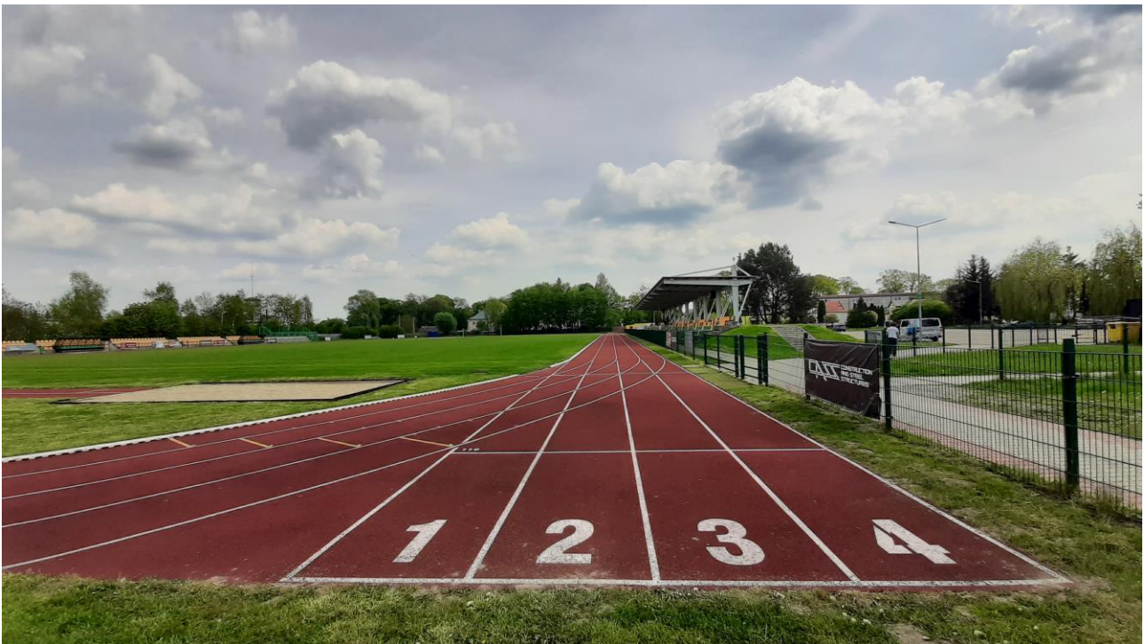
Fot. 1 Widok ogólny badanego obiektu – główna prosta
