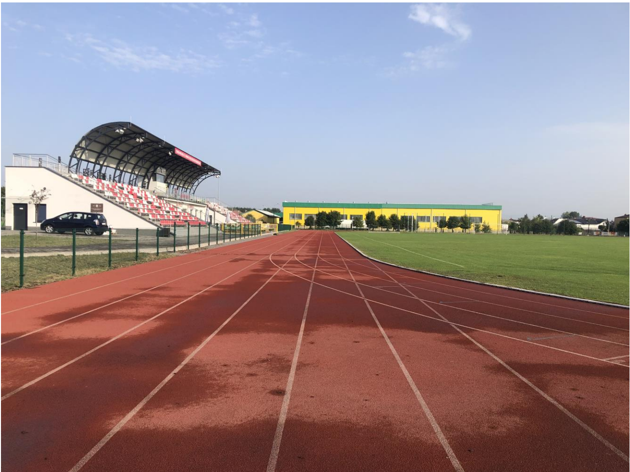
Fot. 1 Widok ogólny badanego obiektu – główna prosta
