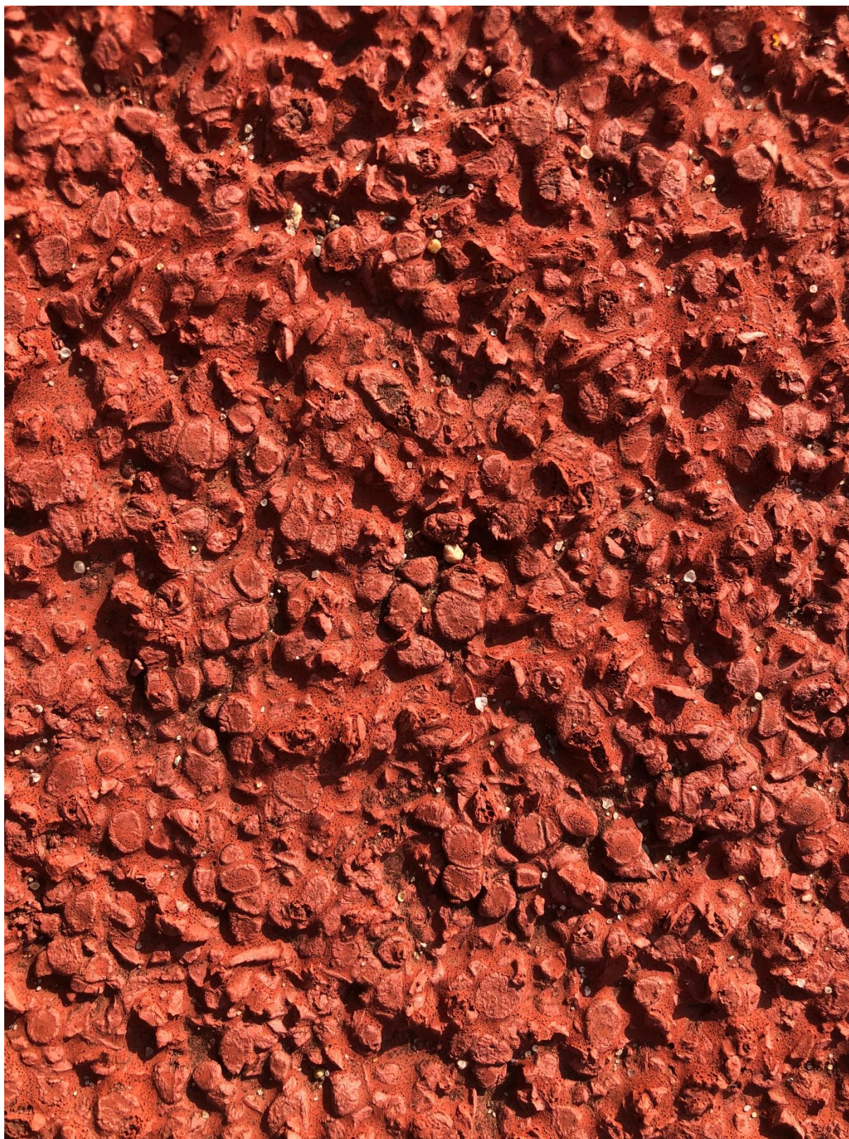
Fot. 19 Przykład startego i uplastycznionego granulatu – stadion w Białobrzegach
