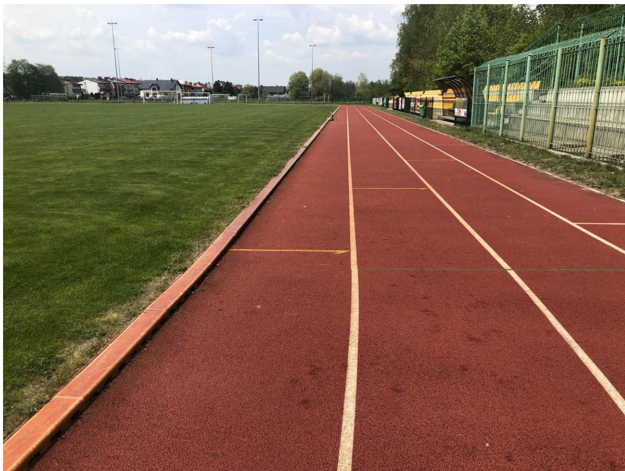
Fot. 8 Widoczne żółknięcie linii bieżni oraz paneli odwodnienia.
