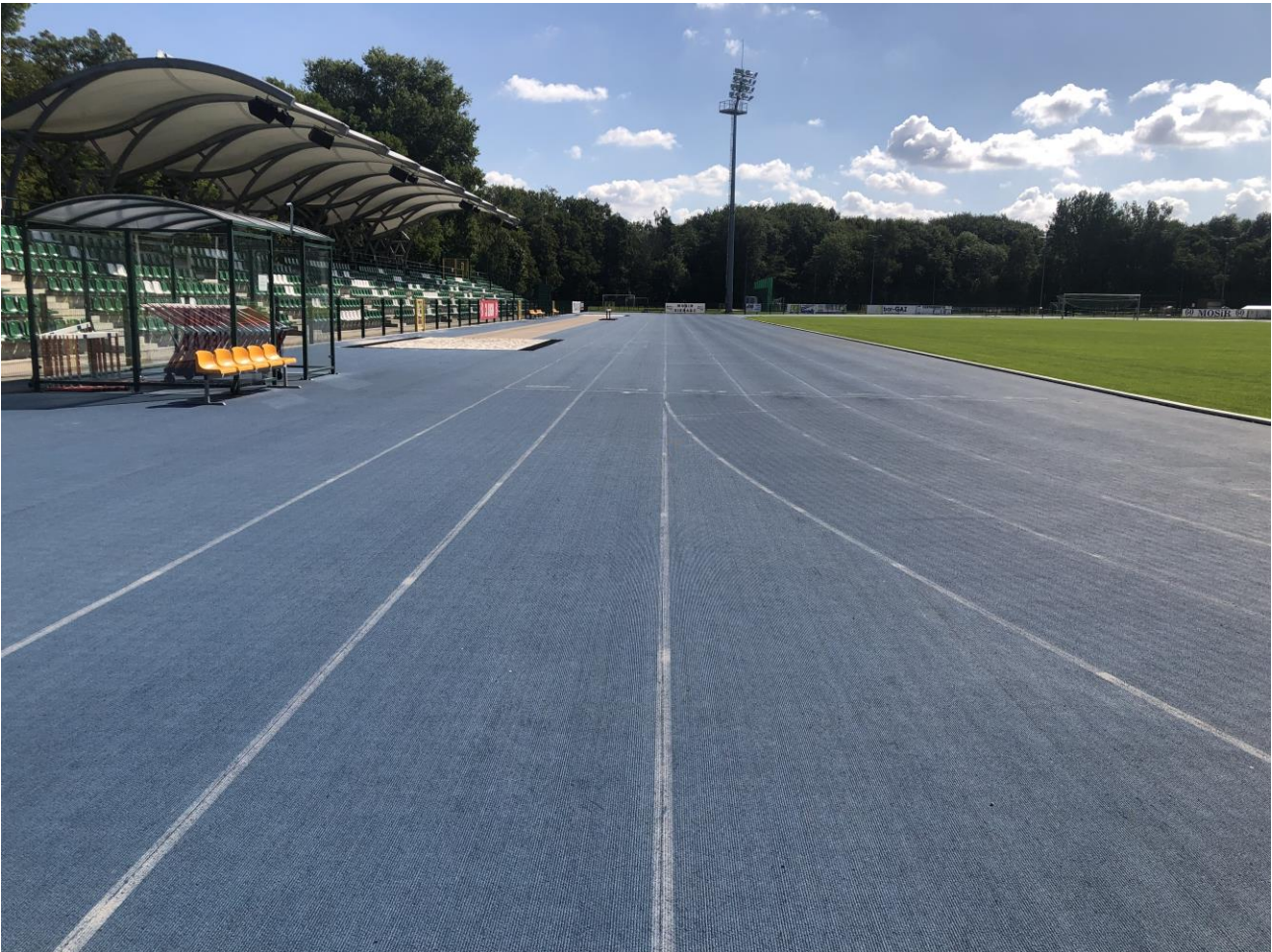
Fot. 1 Widok ogólny badanego obiektu – główna prosta
