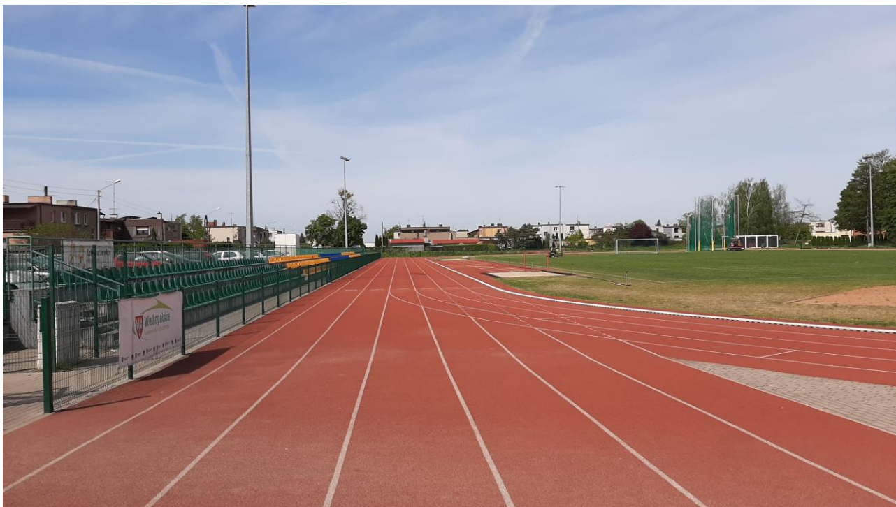
Fot. 1 Widok ogólny badanego obiektu – główna prosta
