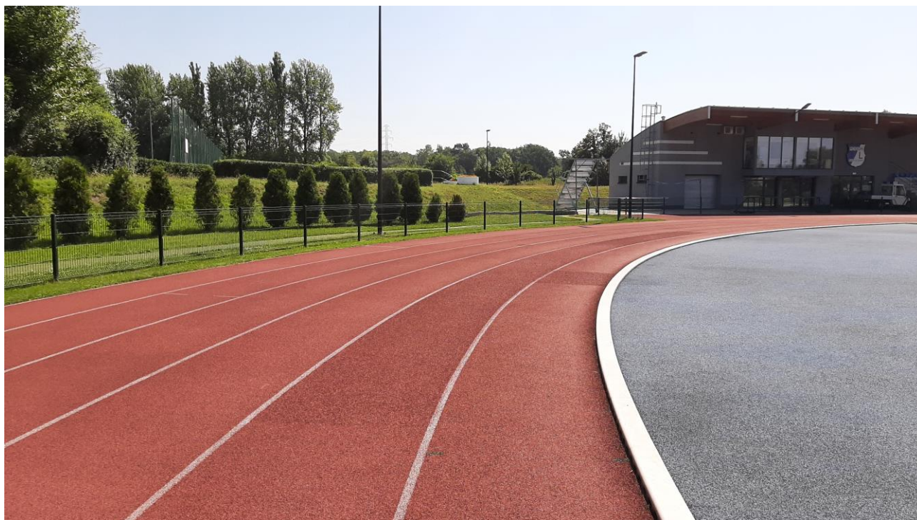
Fot. 5 Miejsce po naprawie tor 2 na łuku bieżni.
