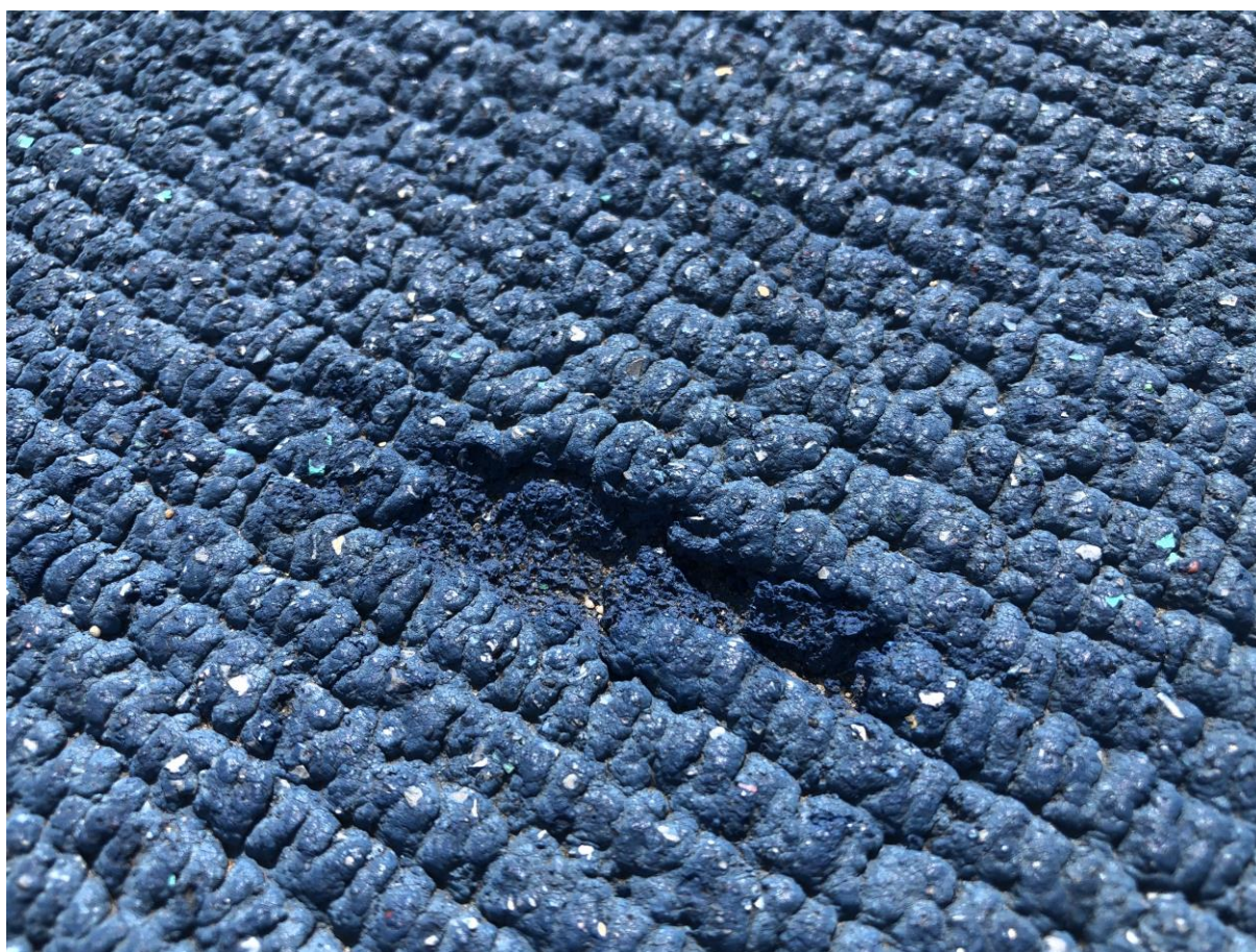
Fot. 8 Ubytek w warstwie użytkowej
