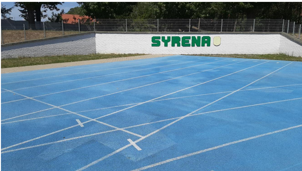
Fot. 5 Widoczne miejsca po przeprowadzonych naprawach
