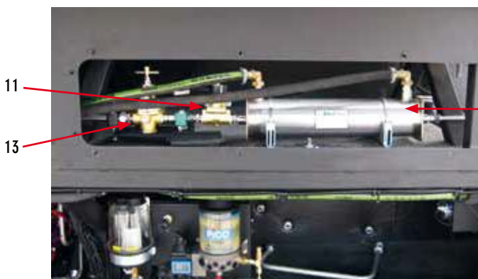
Rys. 3. Część instalacji paliwowej widoczna w komorze silnika pojazdu po otwarciu tylnej górnej pokrywy
