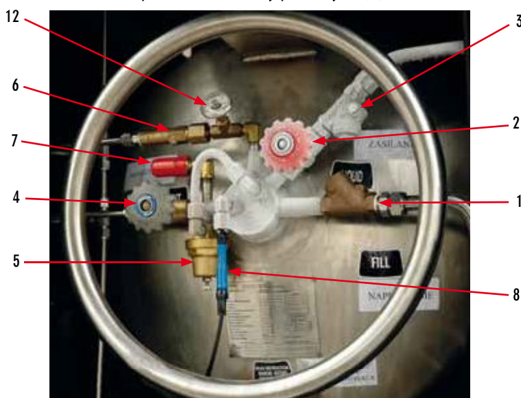
Rys. 2. Rozmieszczenie zaworów na głowicy zbiornika LNG
