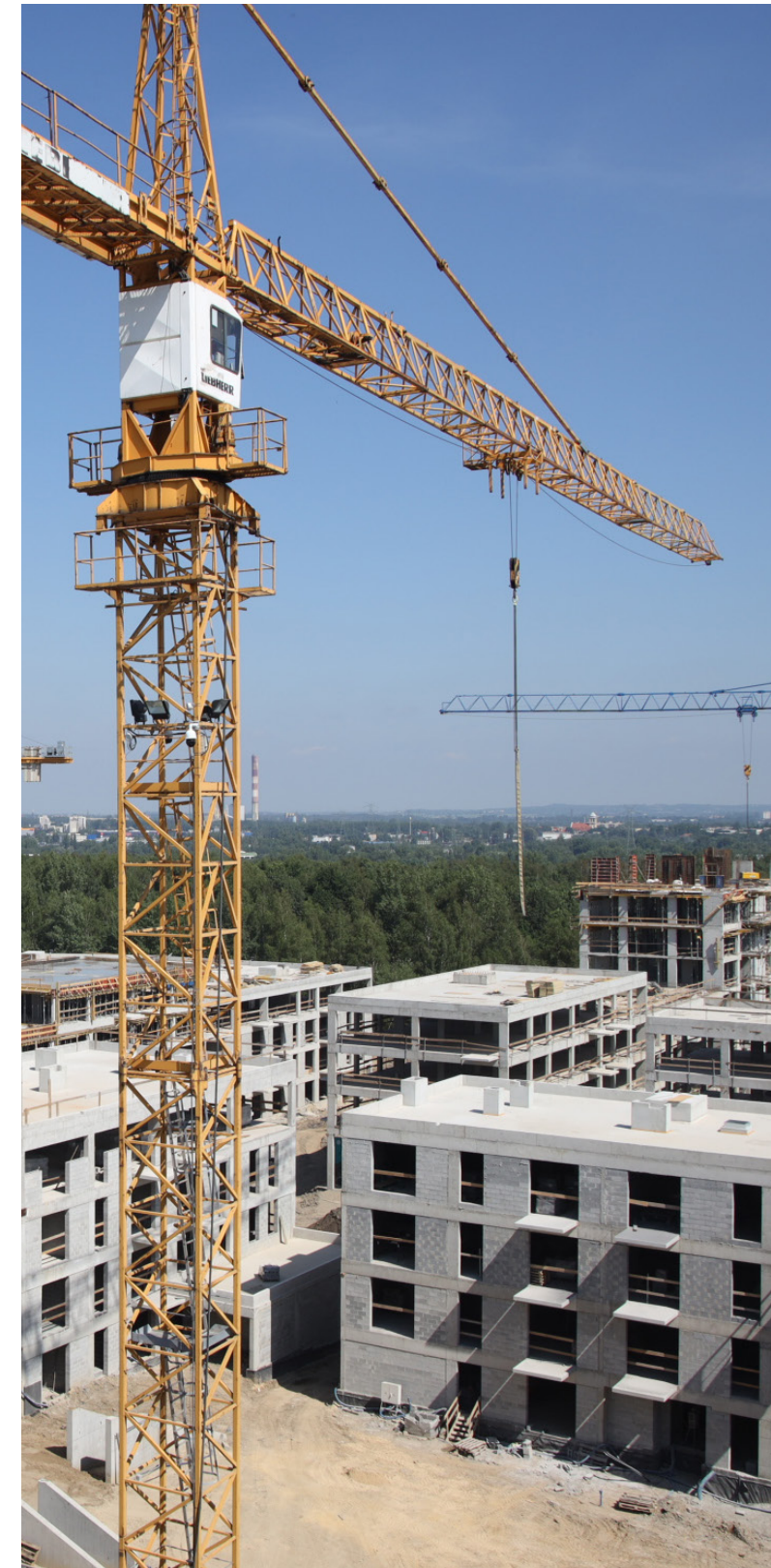
Katowice, ul. Górniczego Dorobku, 513 mieszkań. Zakończenie inwestycji jest planowane na III kw. 2020 r.
