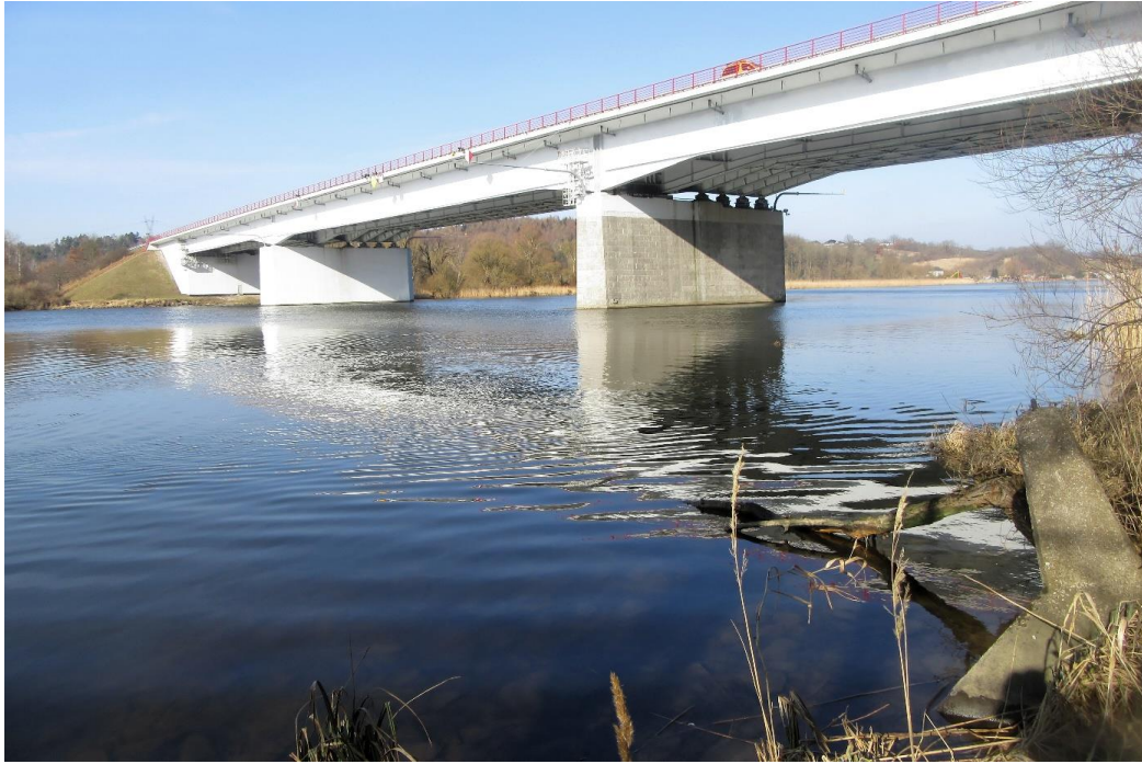
Fotografia 49 Widok na most autostrady A6, pod którym przechodził wilk
